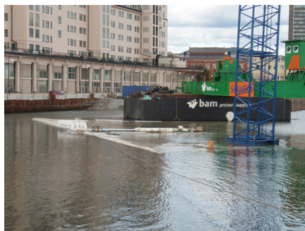
Hele elementet under vann. Utstyr for fortauing og kobling til Havnelageret synlig
