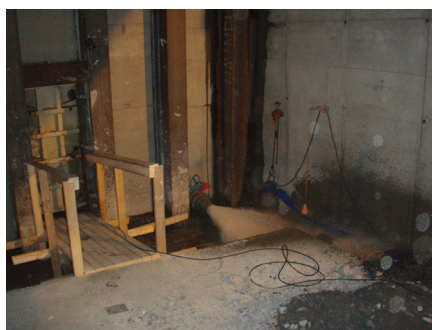
Lensing av vann mellom endeskottene (28. aug kl 2330). Dør mellom endeskott ble åpnet en time senere
