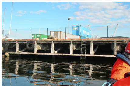
Del av gammelkaia som er rehabilitert
