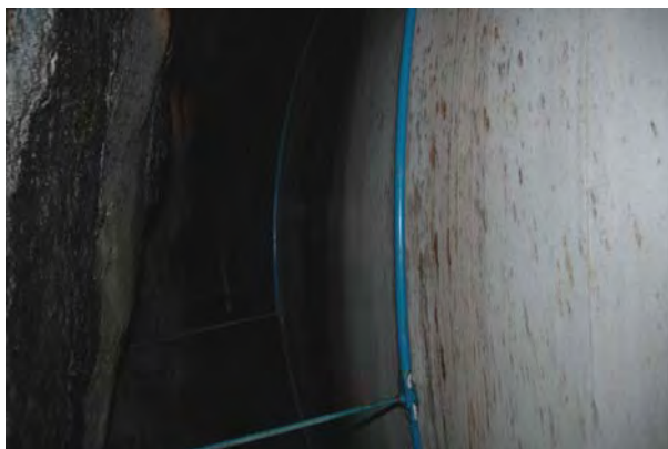
Figur 9 Bjorøytunnelen. Bergsiden av hvelvet. Vått belegg av organisk materiale dekker overflaten av tunnelduken, og er dels oppkonsentrert rundt boltegjennomføring (bilde til høyre).
