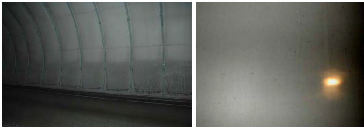
Figur 13 Storvikskartunnelen. Trafikkstøv på overflaten. a) Markert skittkant nederst på veggen. b) Flekker/prikker av støv og skitt på tunnelduken kan skimtes på bildet.
