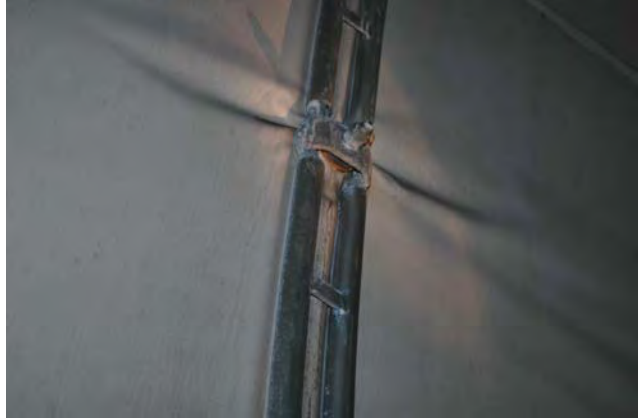
Figur 6 Bjorøytunnelen. På trafikksiden av hvelvet. Eksempler på bukling i tunnelduken, i langsgående felt (a) eller rundt boltegjennomføring (b).
