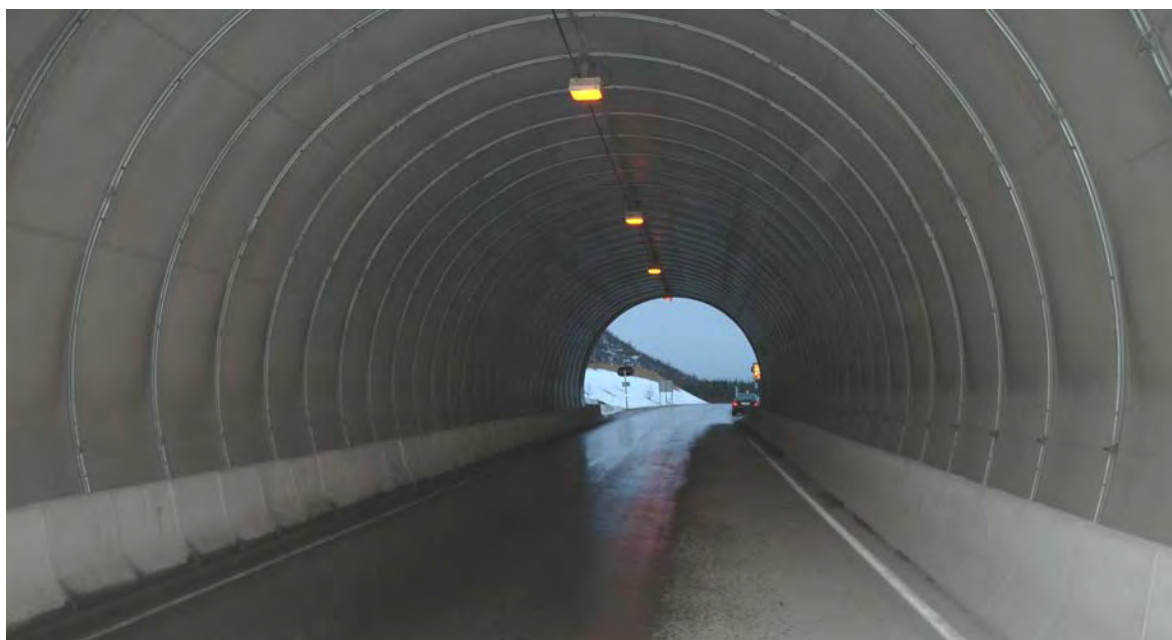
Figur 1 Hvelv av tunnelduk i Storvikskartunnelen, Nordland
