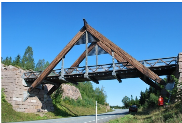
6-1710 Beston – Sprengverk / hengverksbro
