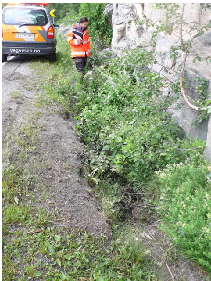
Figur 6 Venstre bilde: Stikkrenne 1 779, innløp fullstendig overgrodd. Høyre bilde: Stikkrenne 1 872, vegetasjon tetter igjen innløp med resultat kun 10 cm åpning.
