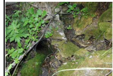
plastrør 200mm inn mot innløp (oppstrøms)
