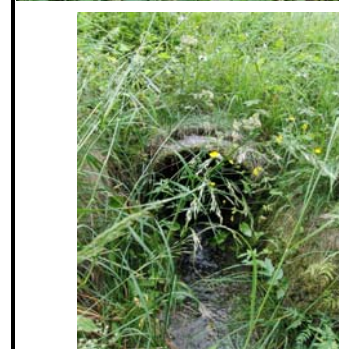
Betongrør ca 5m
