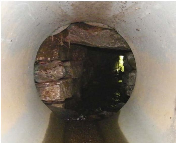
Figur 3: Stikkrenne 14 582. Overgang betongrør - steinsatt renne.
