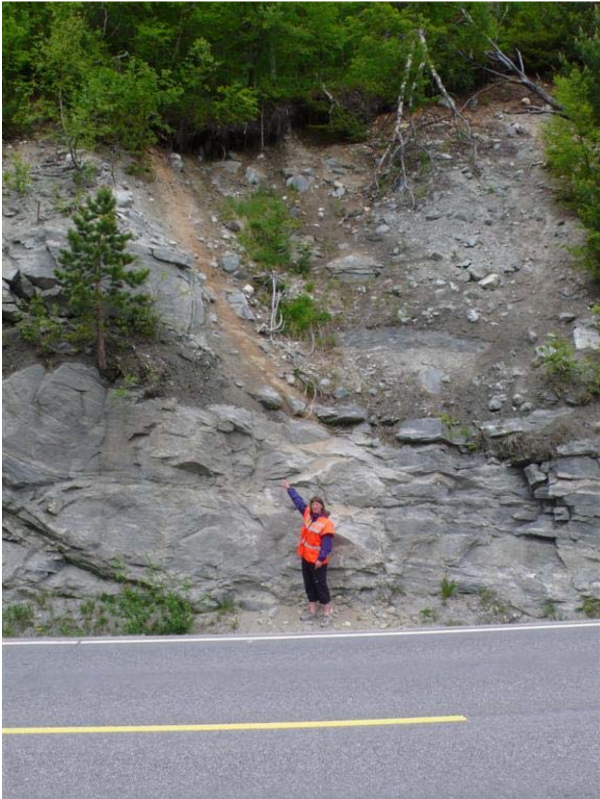
Figur 1 Overflateglidning, E136 – hp1 – meter 1470, 02.06.2009
