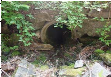
Dreining 20 grader fra vinkelrett posisjon
