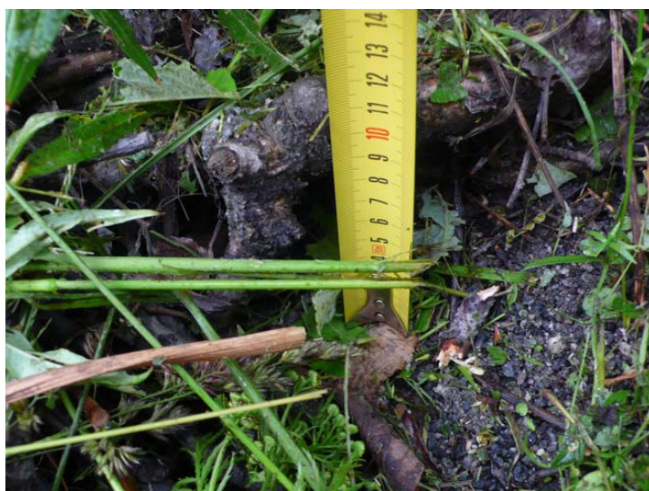
Figur 6 Venstre bilde: Stikkrenne 1 779, innløp fullstendig overgrodd. Høyre bilde: Stikkrenne 1 872, vegetasjon tetter igjen innløp med resultat kun 10 cm åpning.
