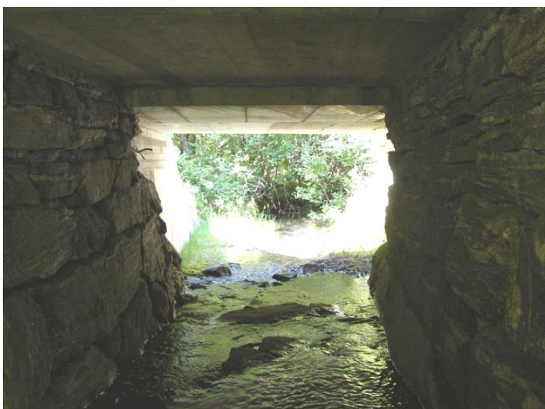
Figur 15 Stikkrenne 15 980. God overgang mellom steinsatt del og betongdel.
