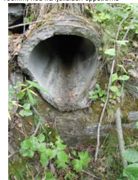
rør 100mm, ned fra fjellsiden oppstrøms
