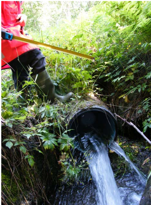
Figur 14 Stikkrenne 16 319. Velfungerende stikkrenne
