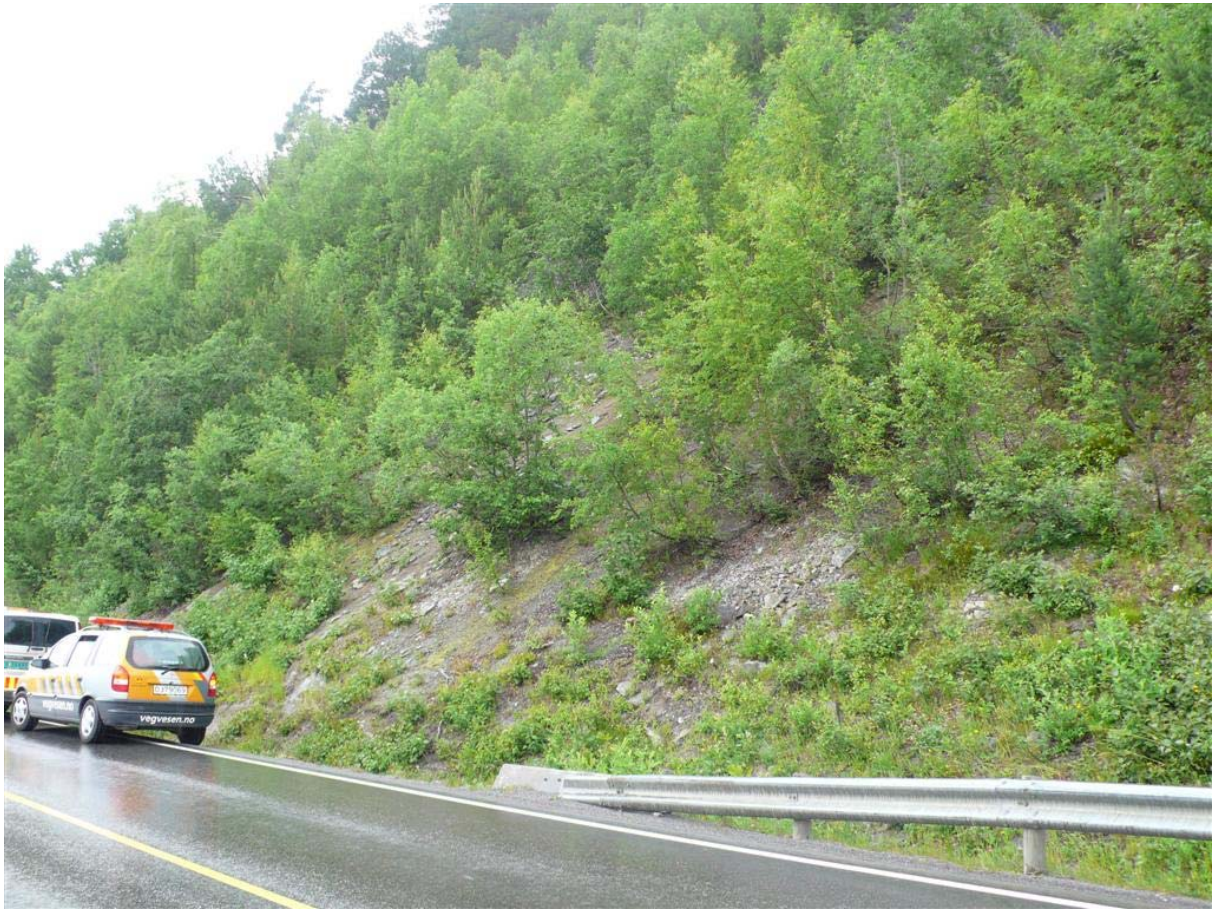
Figur 3 Overflateglidning, E136 – hp1 – meter 1470, 30.06.2009
