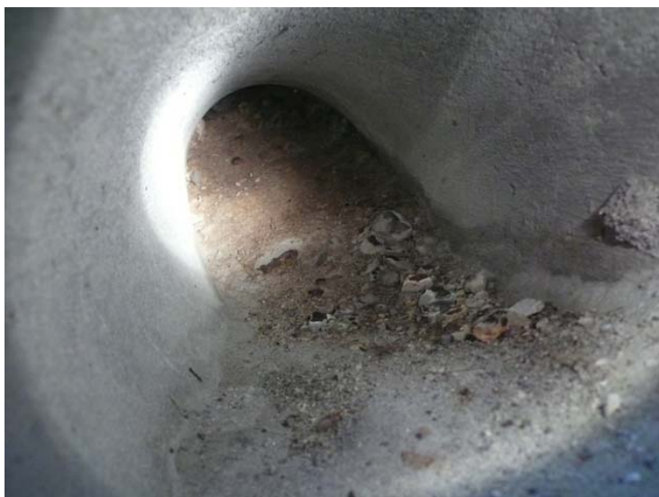
Figur 4 Stikkrenne 1 197. Sand og grus tetter utløp
