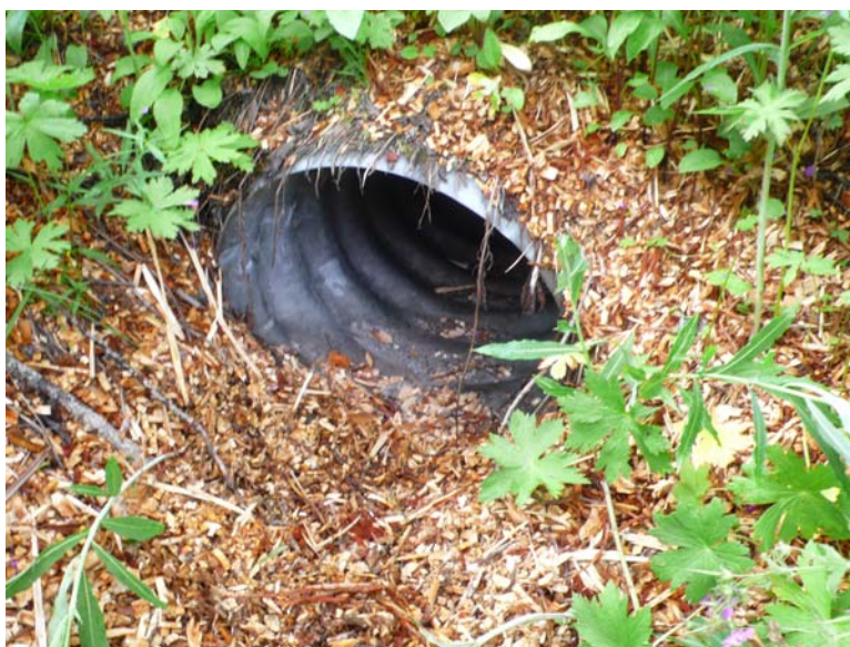
Figur 5 Stikkrenne 320. Treflis fra skogrydding tetter innløp
