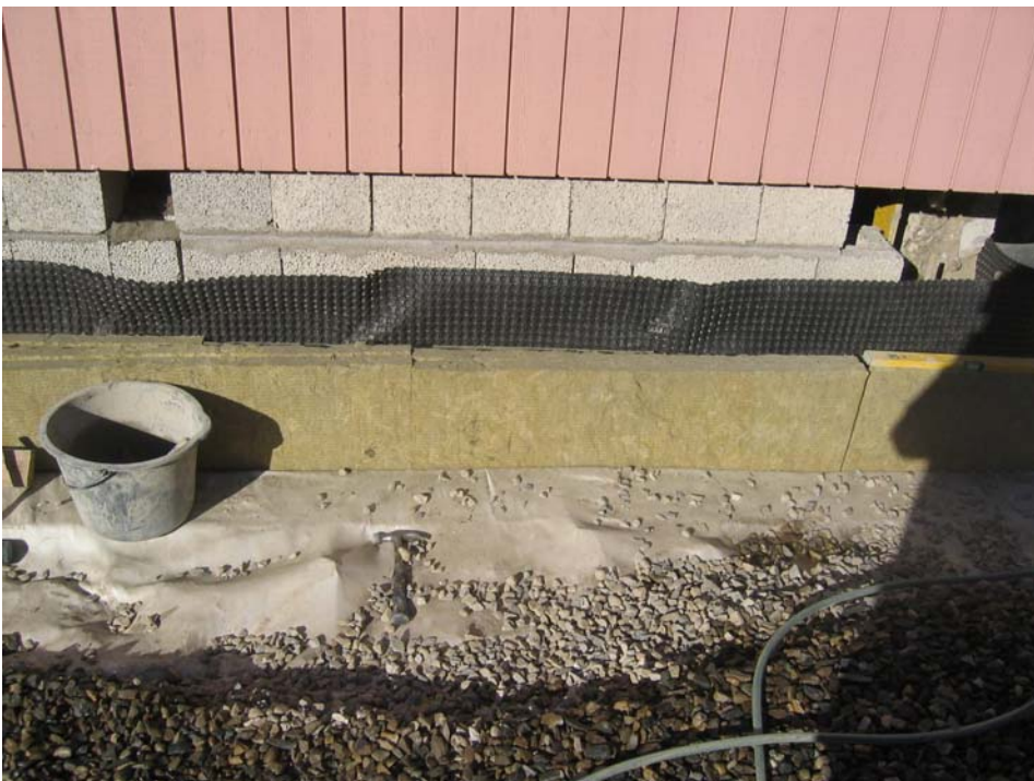
Konstruksjonen sett på toppen
