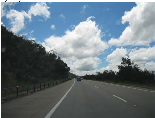
Firefelts motorveger stort sett på alle strekninger utenfor bysentrum. Små klosser i vegbanen fortalte deg at du var på vei over i annen fil. 3'je felt i hver retning var sykkelfelt...
