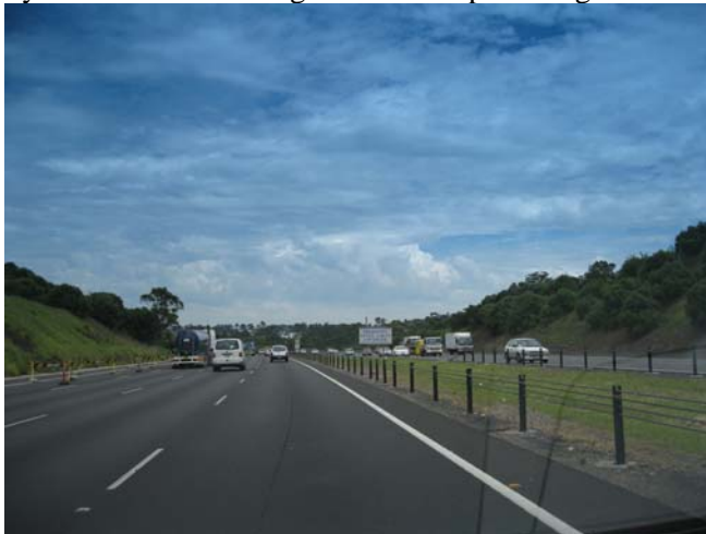
Allerede på 50-tallet bygde RTA veier med veldig bred midtdeler. Slik at de senere kunne bygge seg innover ved behov for utvidelse.
