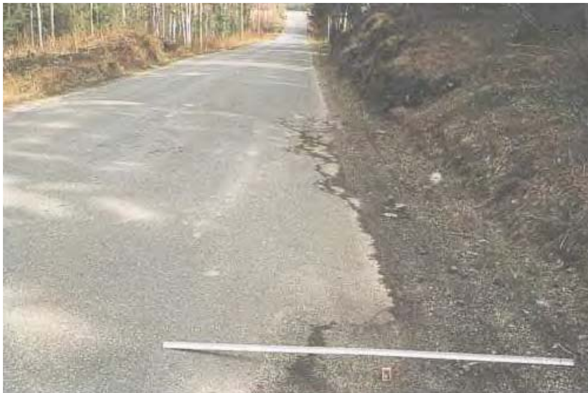
Figur 3.8 Kantdeformasjoner.
