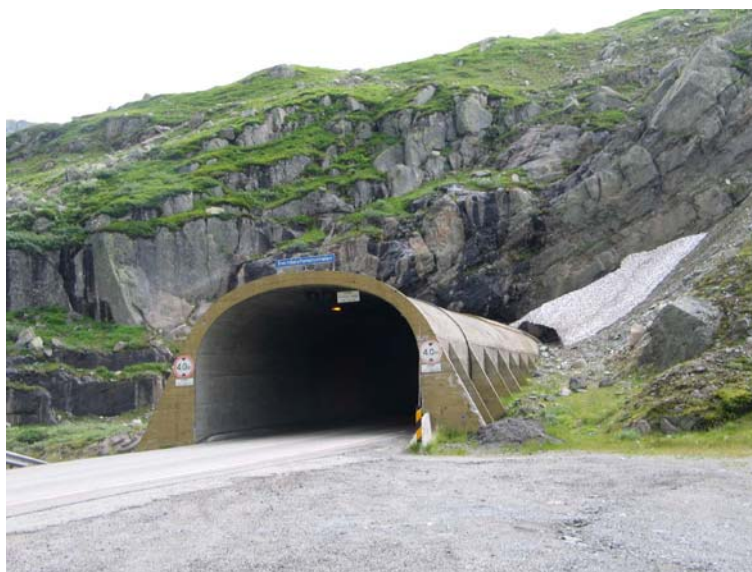
Bilde 6.6 Svandalsflona tunnel, vestre portal
