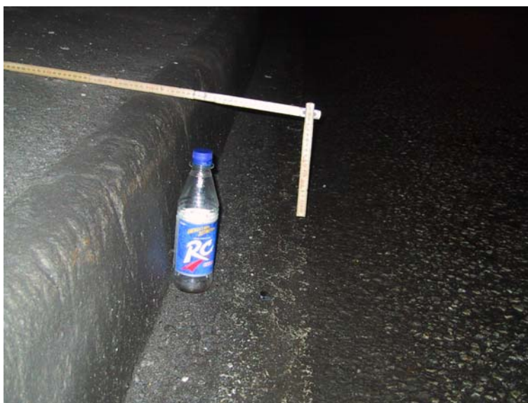
Bilde 6.2 Fortauskant i Vågslid tunnelen
