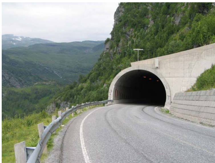
Bilde 6.8 Austmannalitunnelen, østre portal
