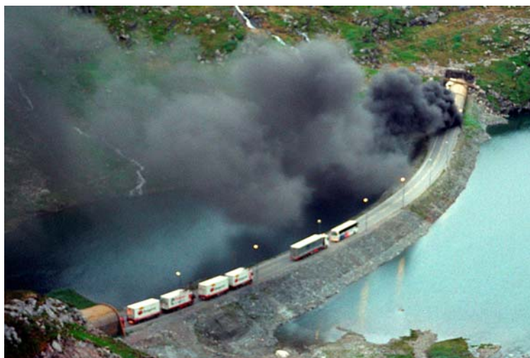
Bilde 3.2 Brann i Seljestadtunnelen i 2001
