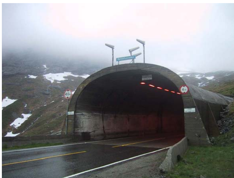
Bilde 6.12 Røldalstunnelen, østre portal
