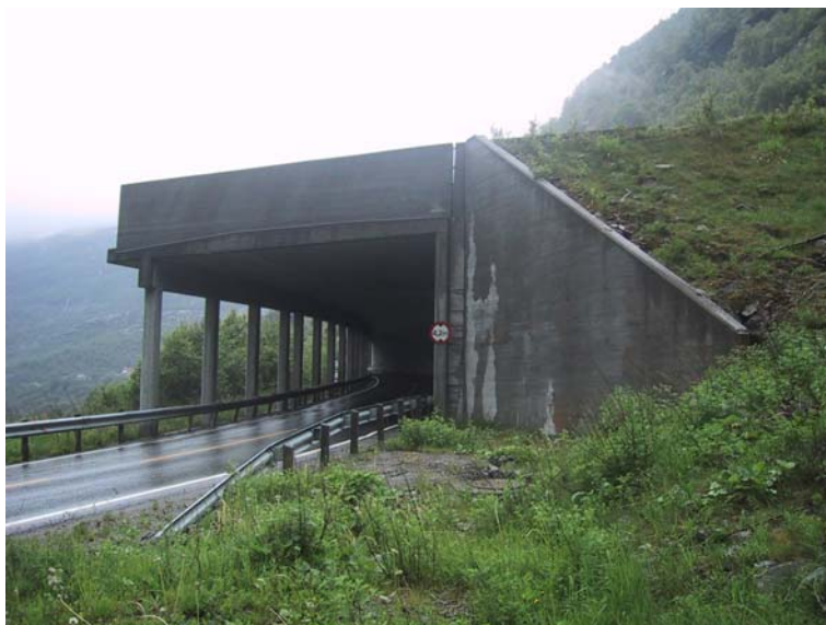
Bilde 6.10 Melkestølsreet rasoverbygg, østre portal
