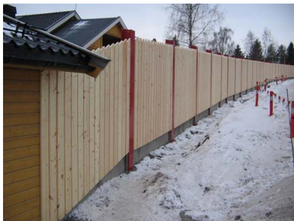
Figur 1. Deler av nyoppsatt støyskjerm i ubehandlet kjerneved av furu på Olrud i Hamar.
