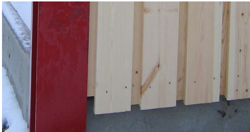
Figur 8. I underkant er kledningsbordene skrånkjært slik at vann som renner nedover veggen ikke skal renne innunder bordet og trekkes opp i endeveden. Betongfundamentet sikrer god avstand mellom bakken og trekonstruksjonen. Foto: F. Fjærtoft.
