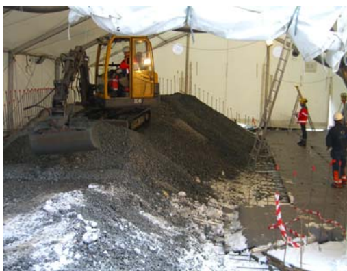
Oppbygging med pukk
