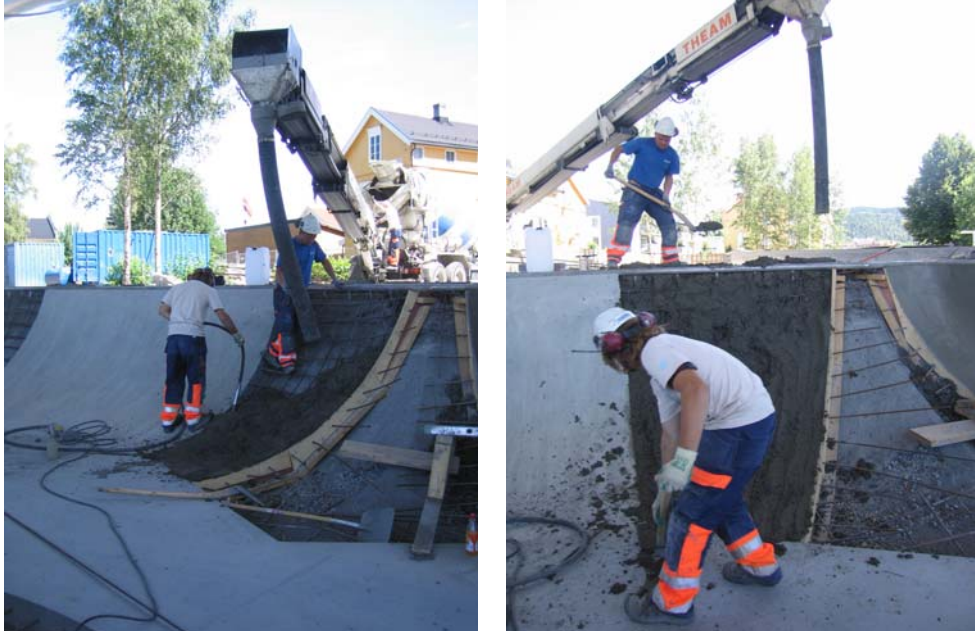
Utlekking av betong i enkelt- og dobbeltkrumbt felt i bowlanlegg.
