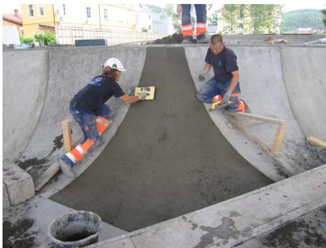
Brettskuring og stålglatting i bowlanlegg
