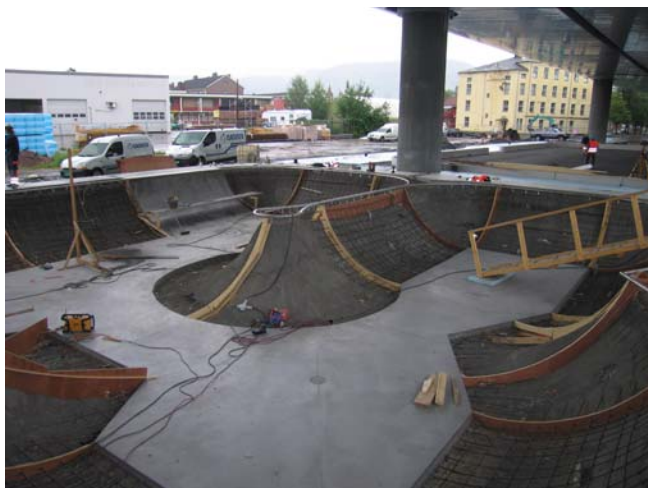
Ulike støpefaser i bowlanlegget
