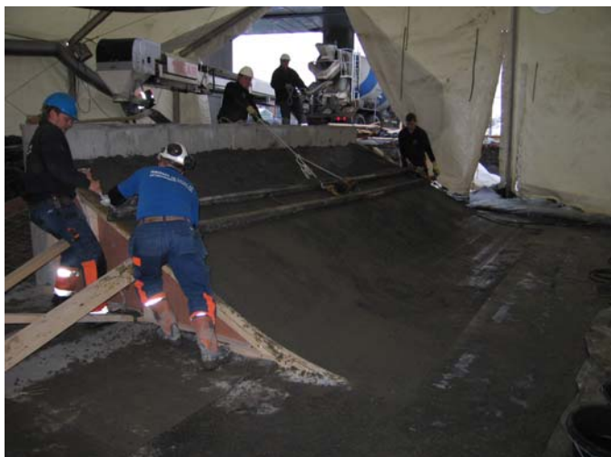
Avretting med vibrobrygge i streetanlegg
