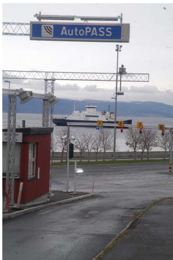
Figur 4: Bildet viser AutoPASS feltet og utstyr for registrering.
