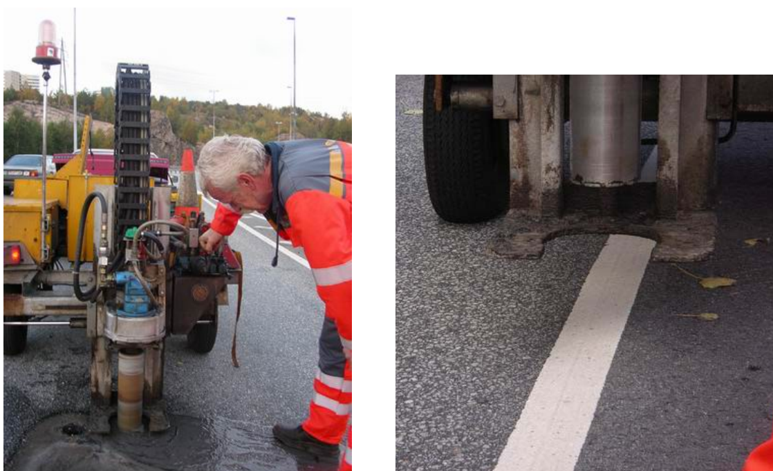
Figur 5. Prøvetaking av asfaltkjerner hhv. uten og med vegoppmerking.
