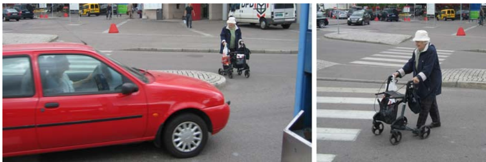
Figur 36. En eldre dame er nødt til å gå rundt deleøya grunnet høy kant.
