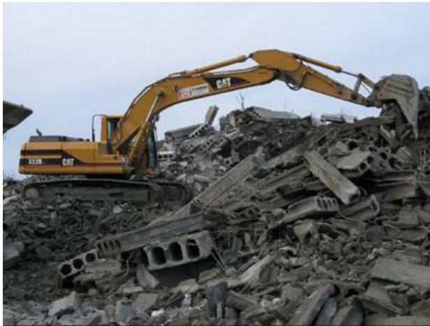
Figur 3.4: Materialproduksjon; knusing og fjerning av armering
