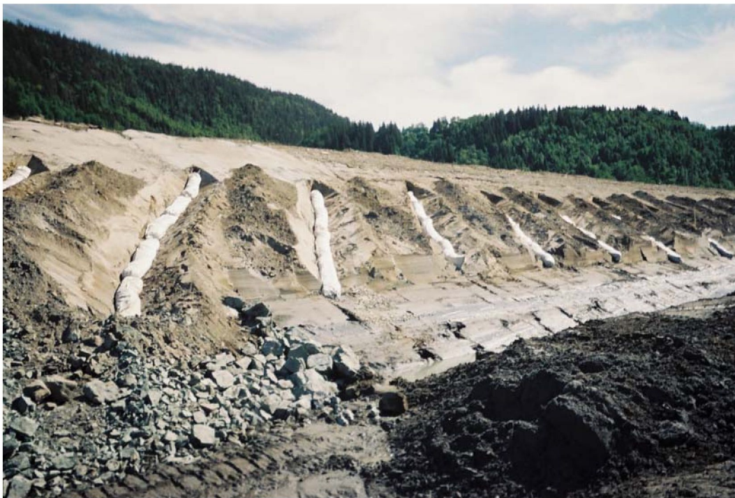
Bilde 13: Skumglasspølser brukt som skråningsdrenering
