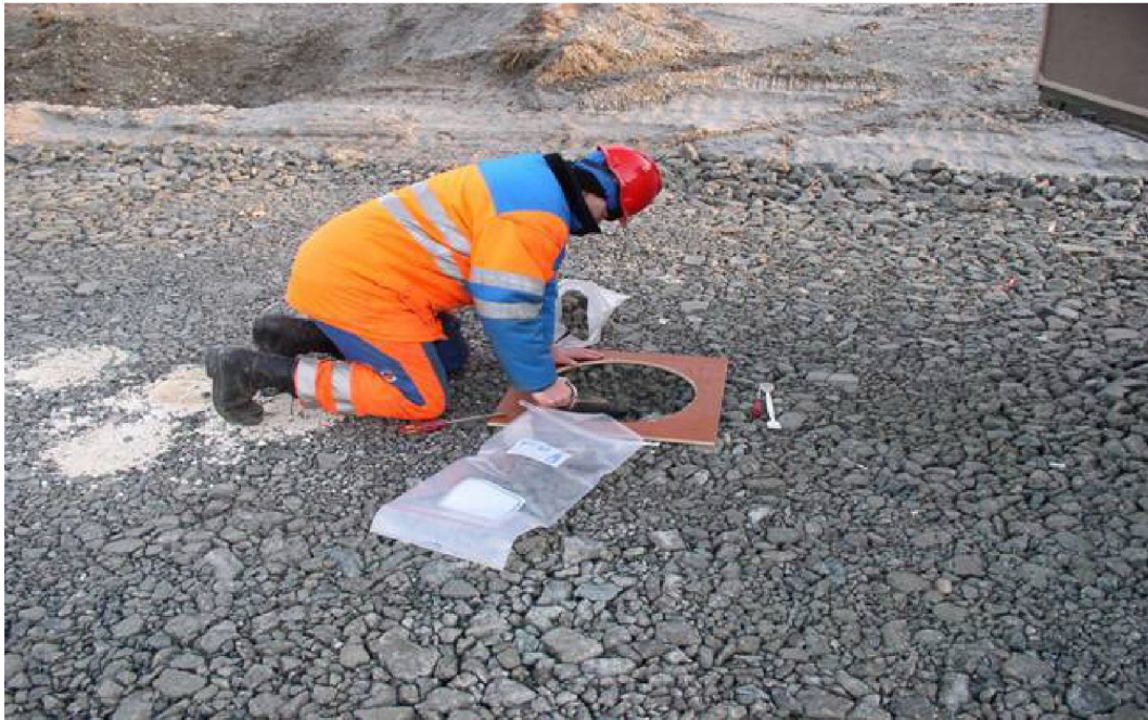
Sandvolummeter i praksis; forsterkningslag av knust betong på E6 Melhus.
