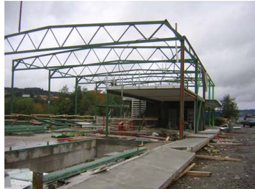
Bilde 16: Demontering av industribygg
