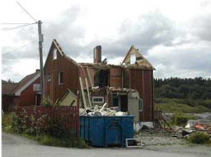
Bilde 15: Hus som blir revet
