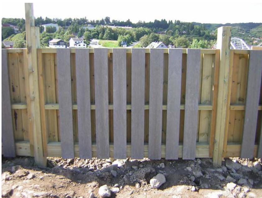
Bilde 21: De første plankene av returplast er satt opp. På utsiden av skjermen brukes vanlig treverk.
