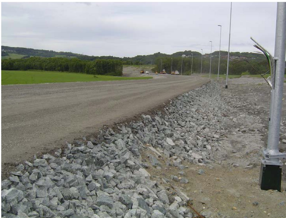
Bilde 8: Gjenbruksasfalt (Gja) brukt til forkiling og avretting av nedre bærelag av pukk
