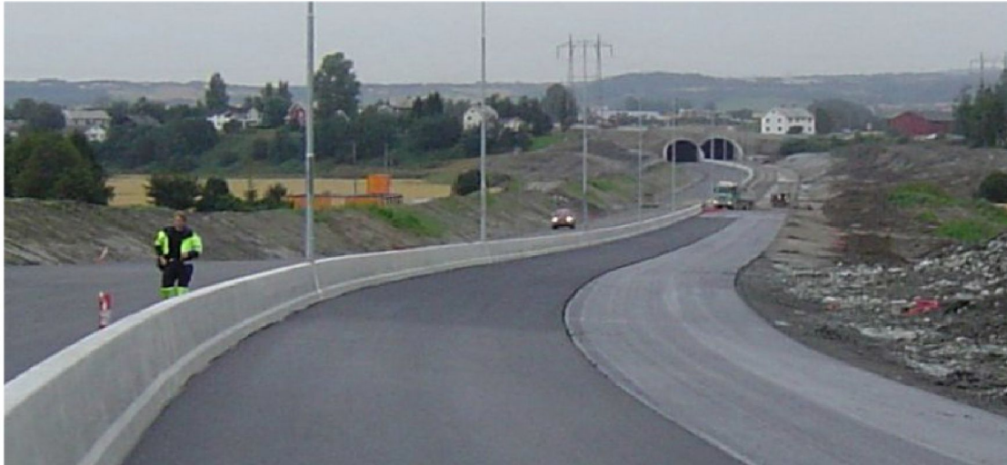
Bilde 10: Fargeforskjell på gummigranulat (i bakgrunnen) og vanlig asfalt
