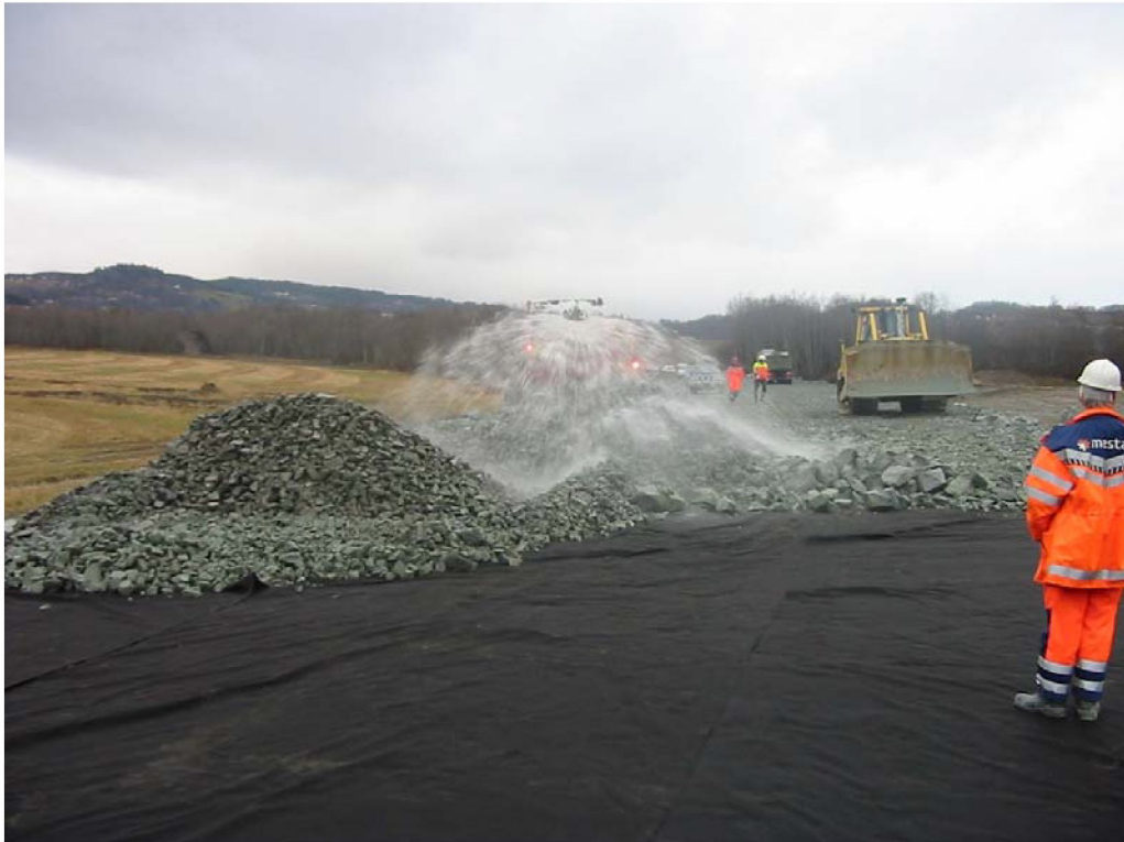
Bilde 4: Vanning av gjenbruksbetong ute på vegen
