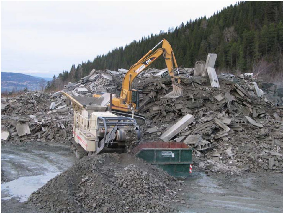
Bilde 3: Produksjon av gjenbruksbetong – knuseren mates med oppklippede betongstykker
