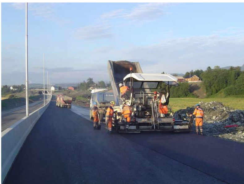
Bilde 11: Utlegging av forsøksstrekningen på E6 Melhus
