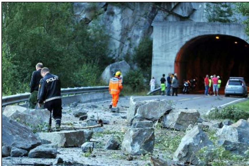
Figur 4: Skredet 24.08.2008 gjorde stor skade. Heldigvis gikk ingen liv tapt (foto: Tidens Krav).
