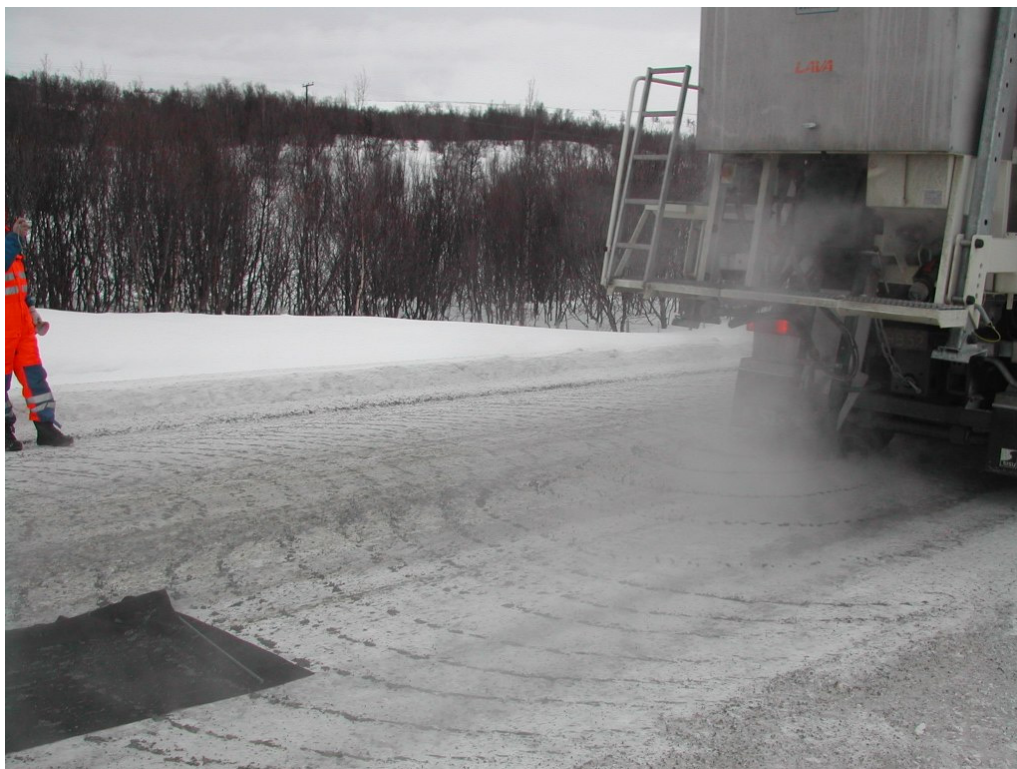
Figur 3.29: Overfart over fiberduk under utstrøing på veg. Stratos Lava II Elverum
