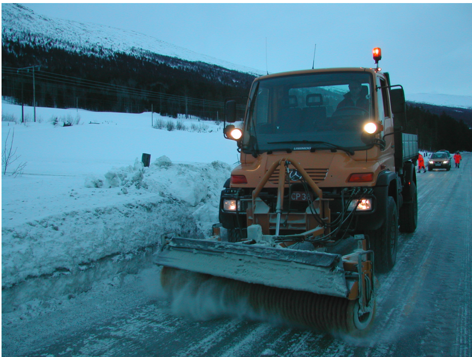
Figur 2.25: Preparering av underlaget
