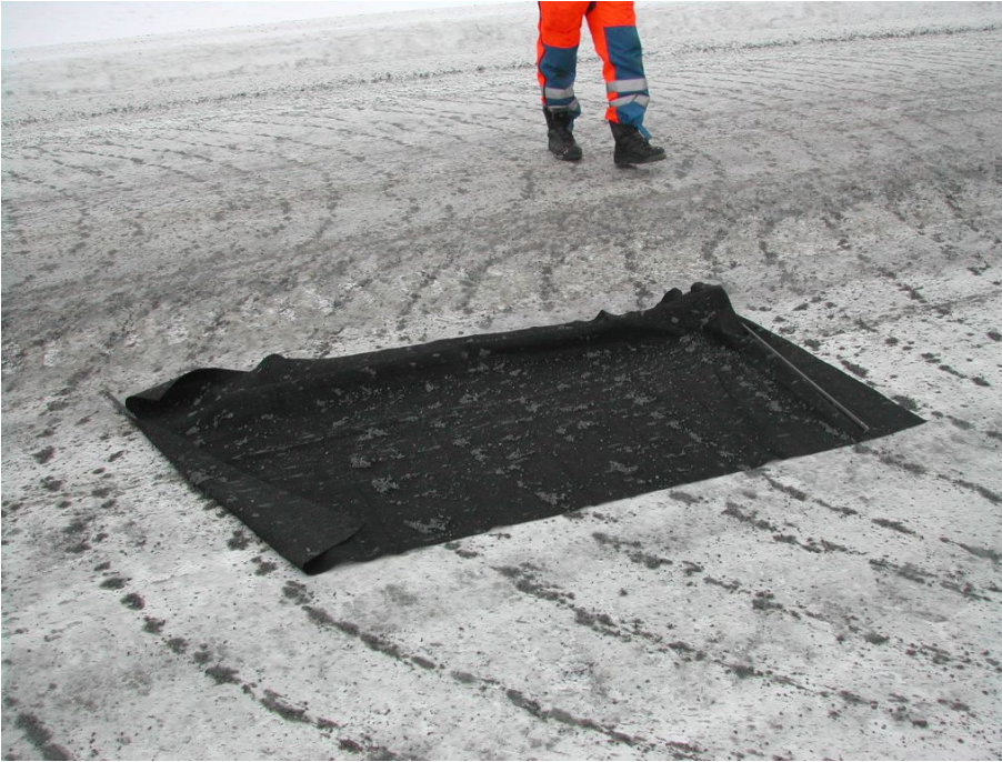
Figur 3.30: Detaljbilde av fiberduk
