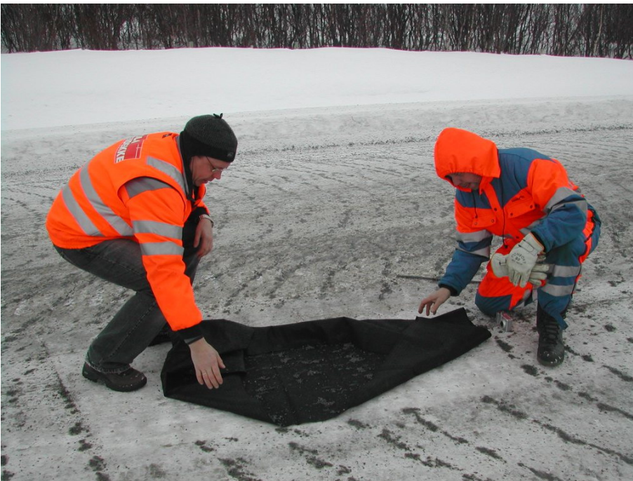
Figur 3.31: Sammenlegging av fiberduken for veiing
