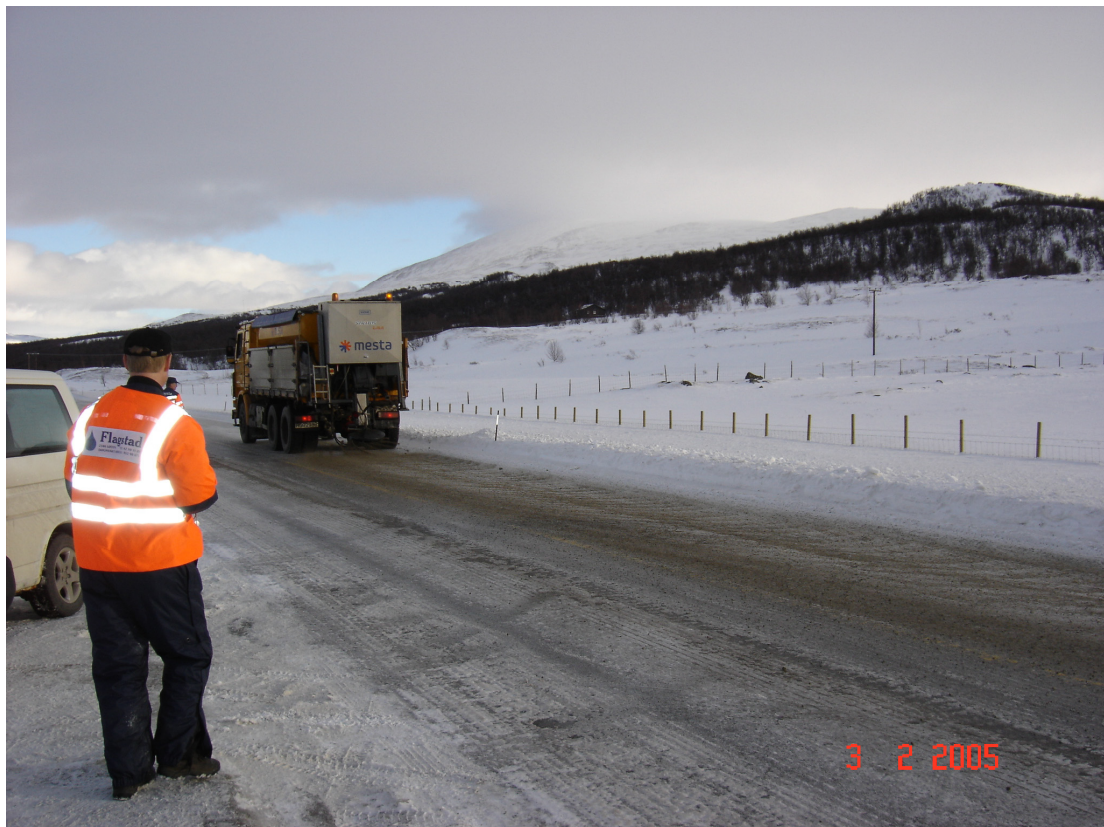
Figur 3.58: Utstrøing av tørr sand
