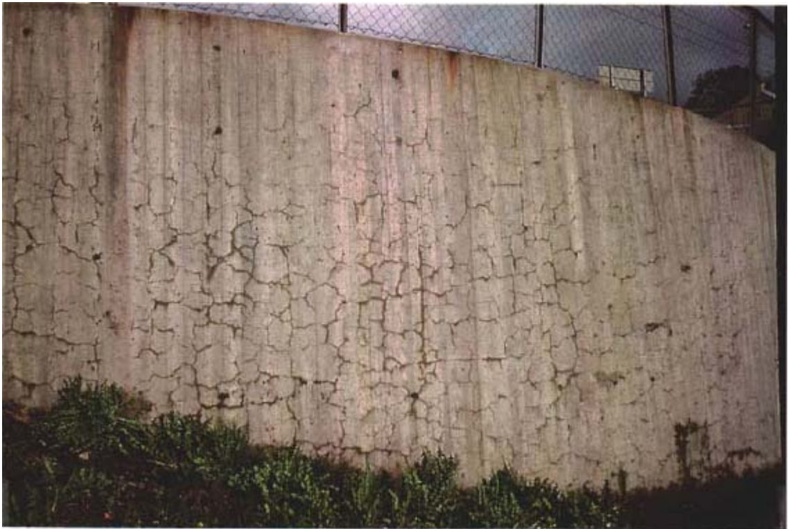
Fig.2. Opprissing på grunn av alkalireaksjoner i et relativt tidlig stadium
