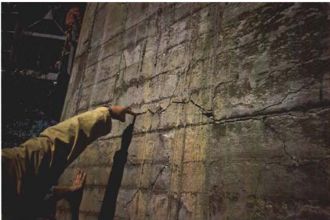
Fig. 3. Alkalireaksjon i en mer utviklet fase. At det ikke er utfelling av gel og kalk på overflaten er atypisk.
