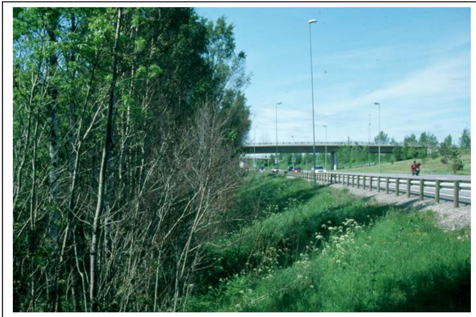
Figur 6. Typiske sprutskader ved E6, Åsgård i Østfold. Juni 2003.
