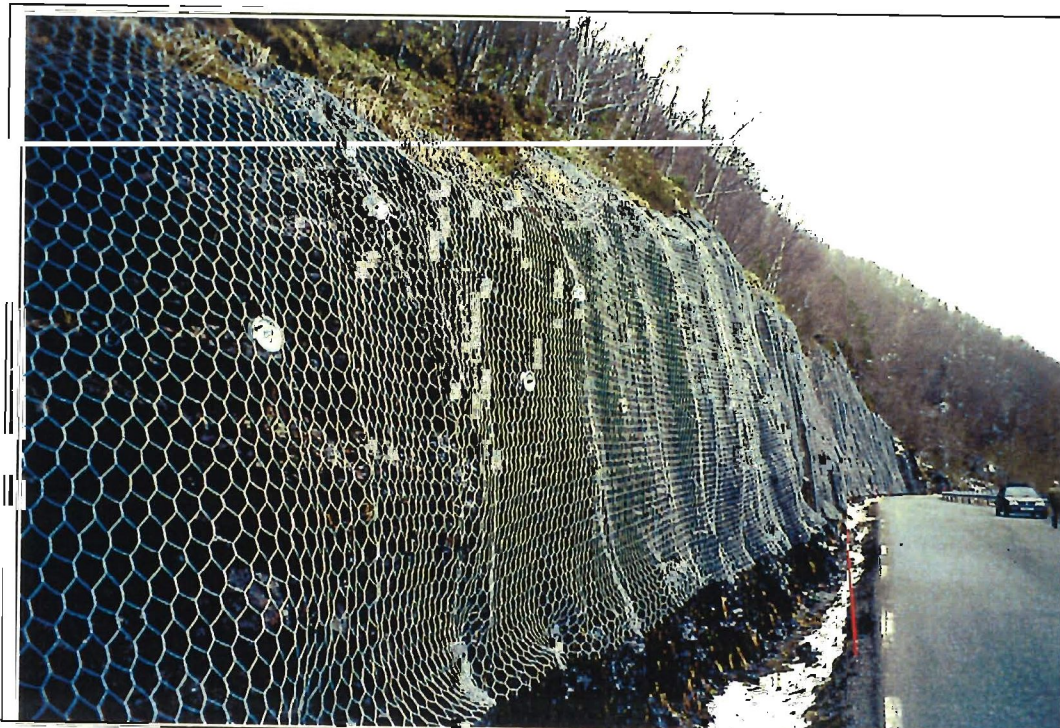
Fig. 37 Til issikring vert det brukt seks- kantnett bunde saman av gal- vaniserte trådar verna av eit PVC- belegg. Netta vert festa til fjellet med avstands- boltar plassert i eit fem-kort mønster. E39 Halså.
