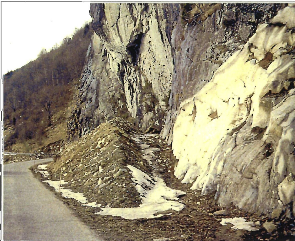
Fig. 55 Fangvollar er eit alternativ for å fange isras frå stor høgde. Fv 421 Roskevaulen
