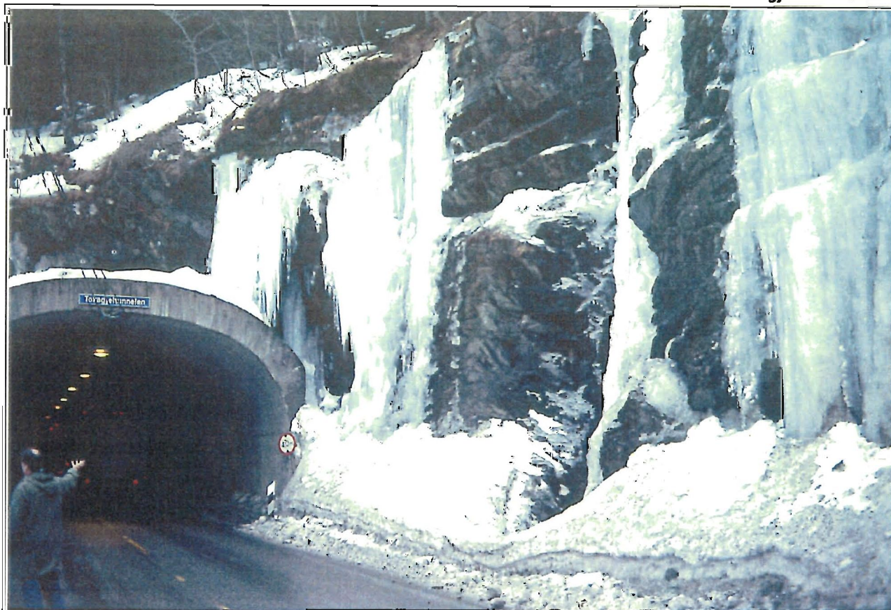
Fig.6 Tunnelmunningar er spesielt utsett for iskjøving og nedfall av is. Rv 7 Tokagjeltunnelen.
