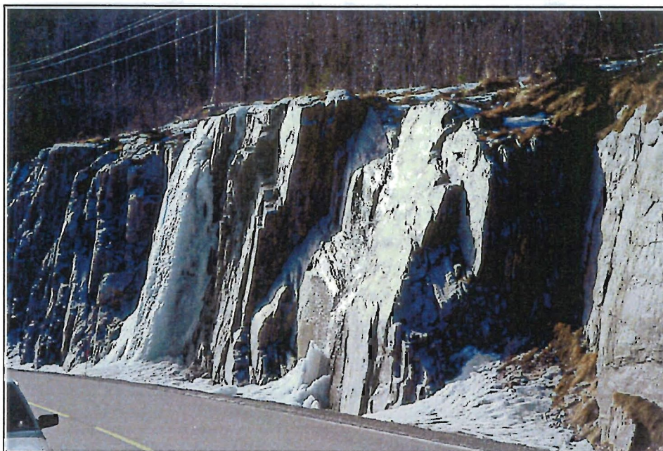
Fig. 23 Bekken i fig. 22 gjev store iskjøvingar i fjellskjeringa Rv 37 Tinnsjø.
