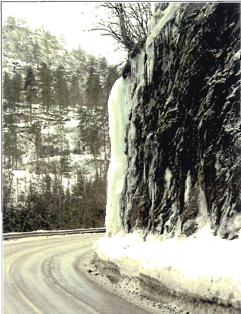
Fig. 7 Store iskjøvingar kan føre til ein vesentleg reduksjon av siktlengda. E16 Kvarme.
