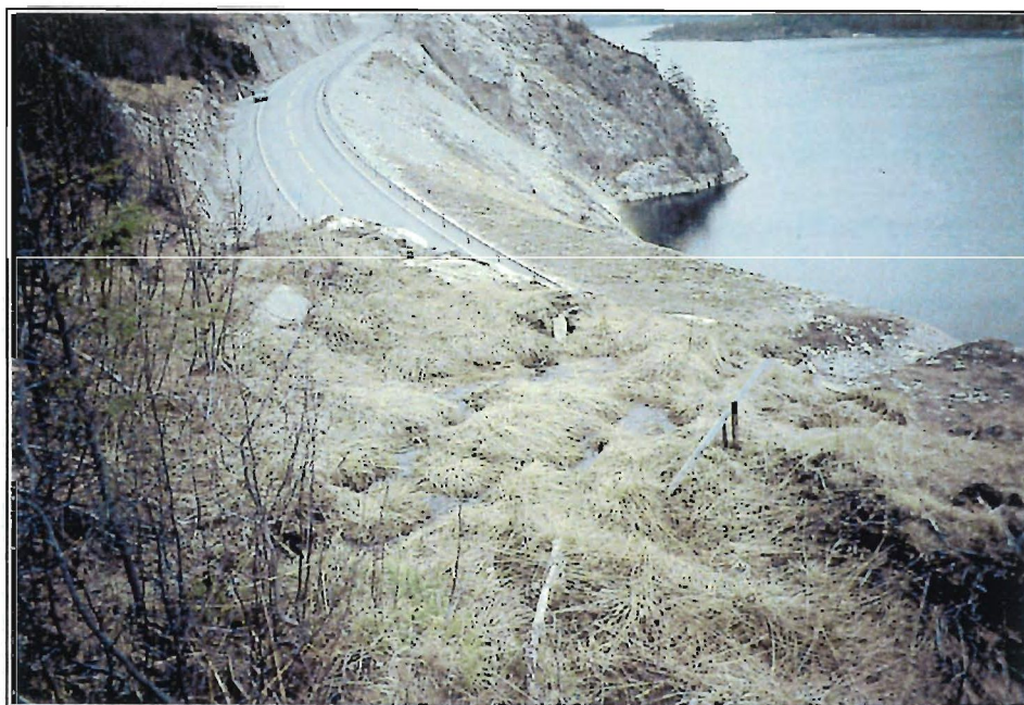
Fig. 22 Foto av bekk som renn over ei lita myr og vidare fram til fjellskjeringa. Rv 37 Tinnsjø.
