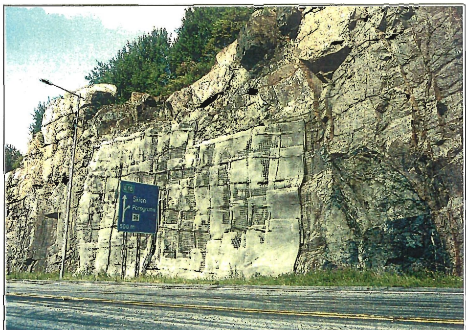
Fig. 30 Plater av PE-skum festa med boltar i fjellveggen og dekte med armeringsnett og sprøytebetong. Ev18 Porsgrunn
