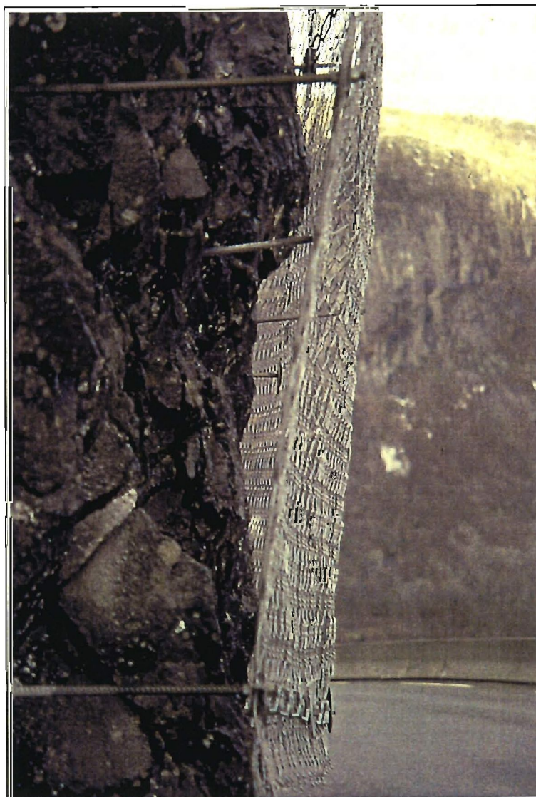
Fig.38 Nettet vert til vanleg plassert 20-30 cm ut frå fjellveggen. Dersom det er ujamne fjellsider er det viktig at nettet dannar ei jamn flate, noko som krev varierende boltelengder. Rv 7 Kvanndal
