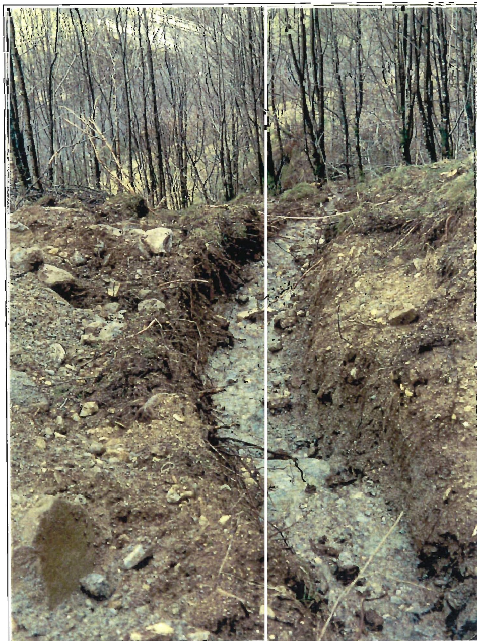
Fig. 27 «Etter grøftinga» jfr. fig. 25. Ev 39 ved Matre
