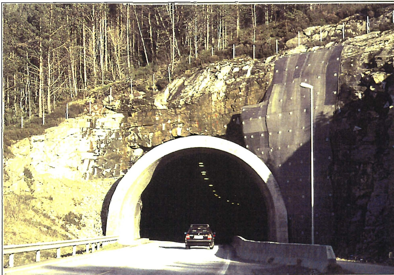
Fig. 57 Problema med iskjøving og nedfall av is mot tunnelportalen er redusert ved montering av plater av PE-skum og issikringsnett. Denne løsinga er ikkje estetisk god og andre alternativ burde vore vurdert. E136 Sørnestunnelen
