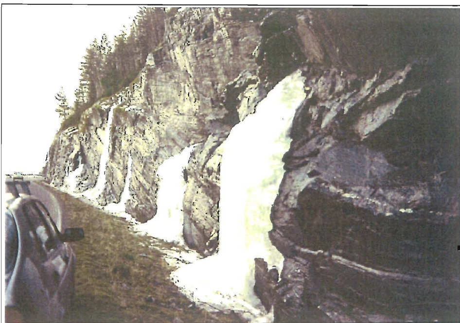
Fig. 31 Grøfter som er 3 m eller breiare fangar opp dei fleste iskjøvingane som fell ned frå fjellskjeringar lavare enn 10 m. Rv 15 Skredestranda.
