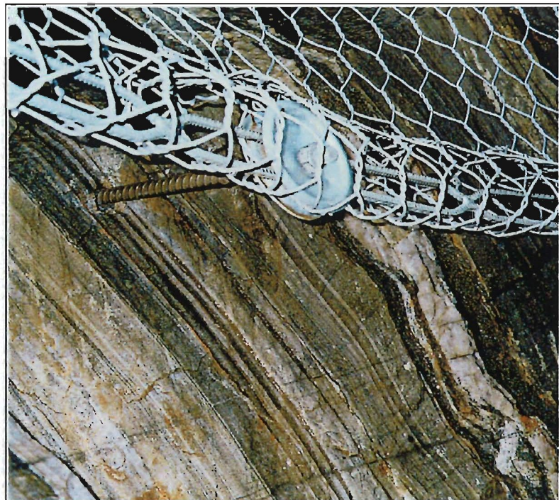
Fig. 45 Avslutning av nettet i botnen med tilbakebretting
