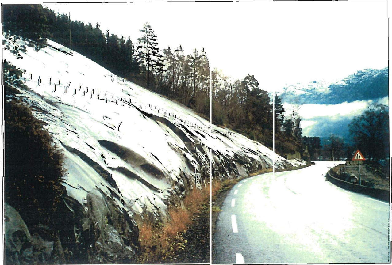
Fig. 19 Is som losnar på skråplan gjev ofte store ras med lange utløp. Rv 13 Kyrkjenes.
