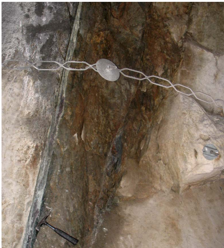
Figur 6. Fra tverrslag 5. Her er forkastningen med oppsprukket syenitt ca 20-50 cm bred med en leirsleppe (ved hammerhodet) langs hovedforkastningen .
