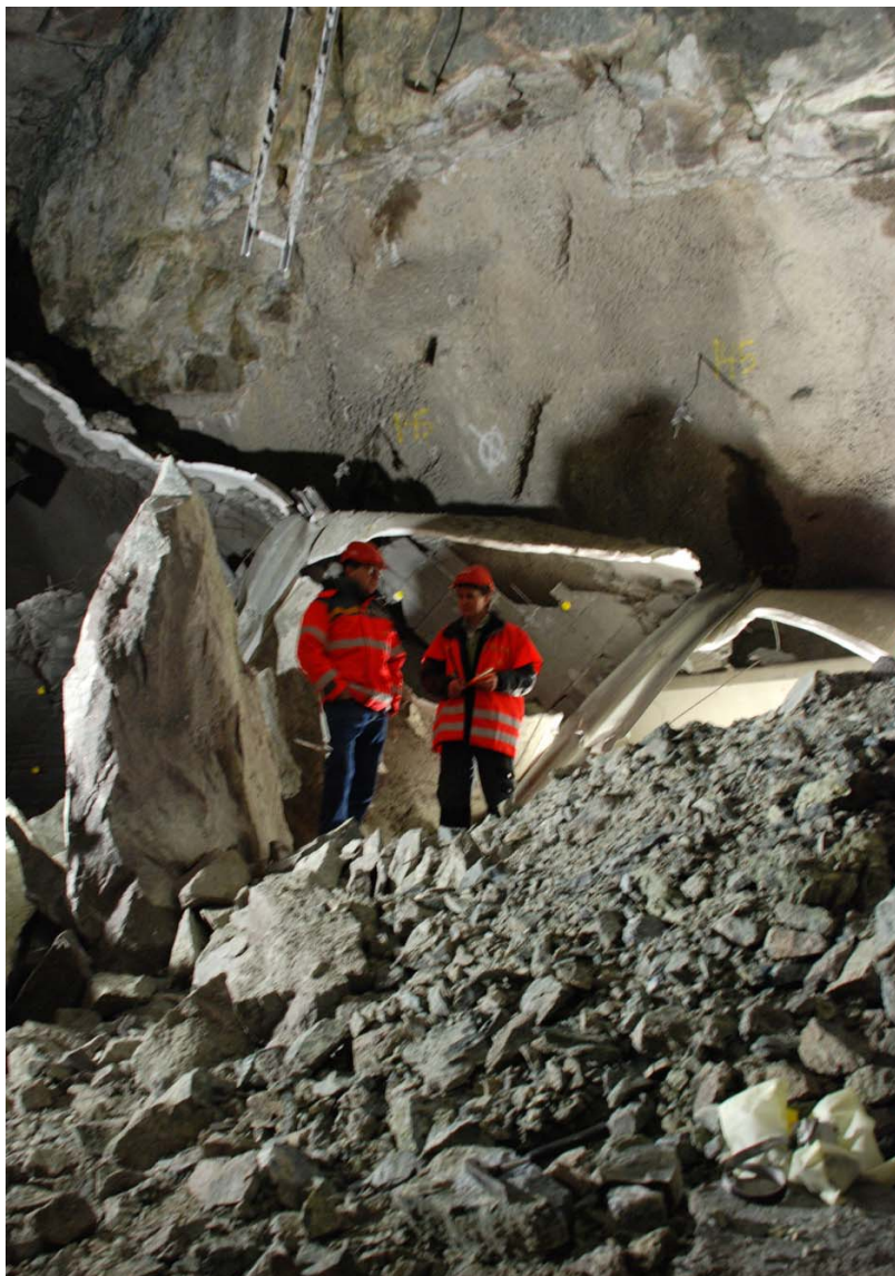
Figur 9: Det nedraste materialet. Merk stor blokk av syenitt (Foto fra Statens vegvesen).
