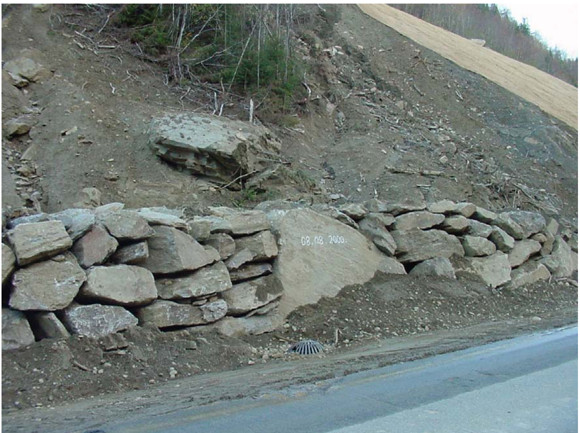
Figur 10: Foto mur mot rasrenne
