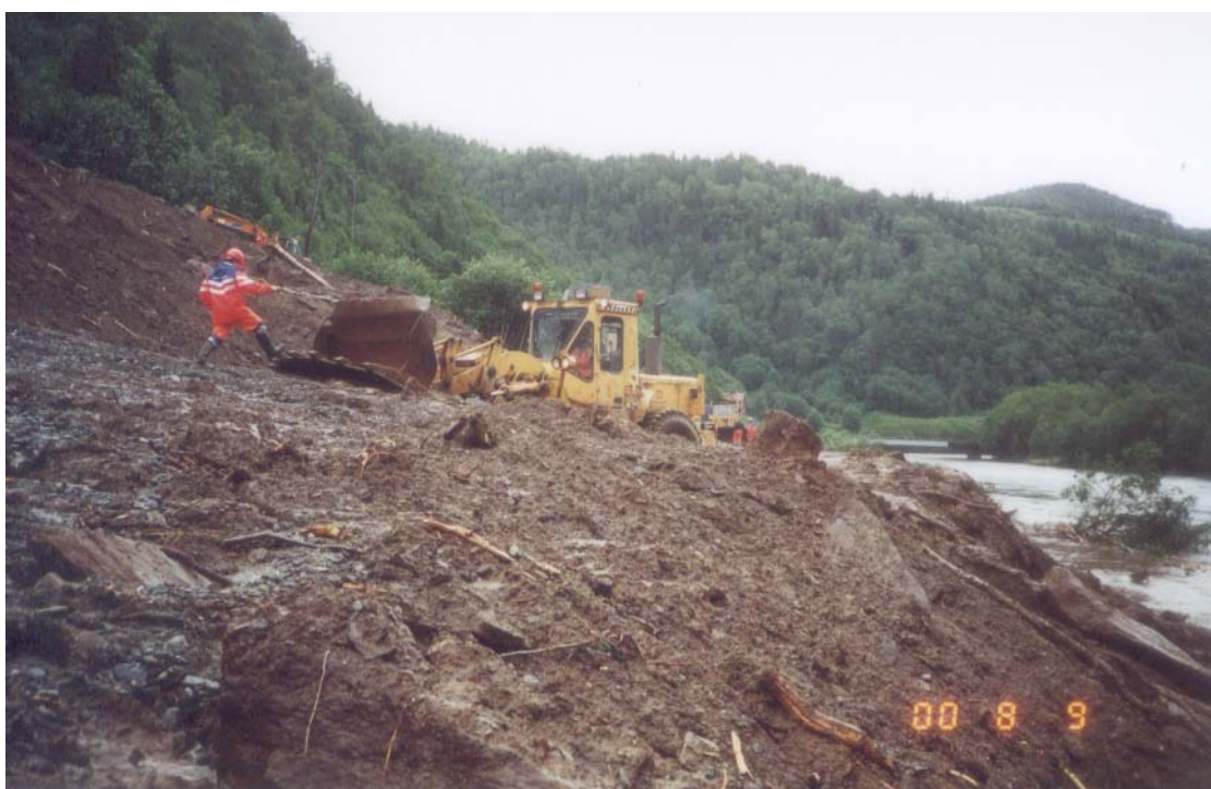
Figur 7: Foto utbedring E14
