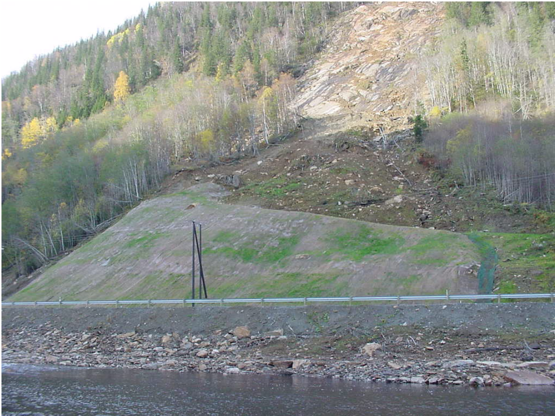
Figur 12: Foto av tilsådd skråning ett år etter raset
