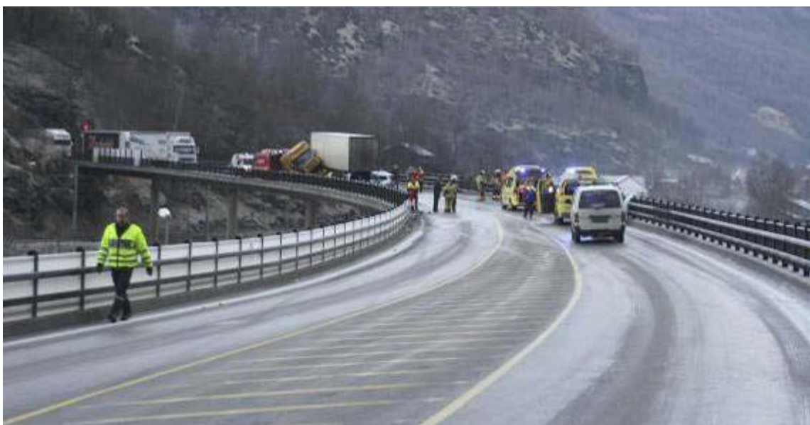
Figur 4: Ulykkesstedet etter at redningsarbeidet er påbegynt. Bildet viser rimdannelse i kjørebanelen. (Foto: Arne Veum)
