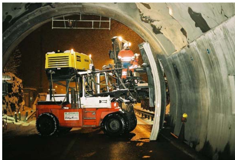
Montering av lettbetongelementer
