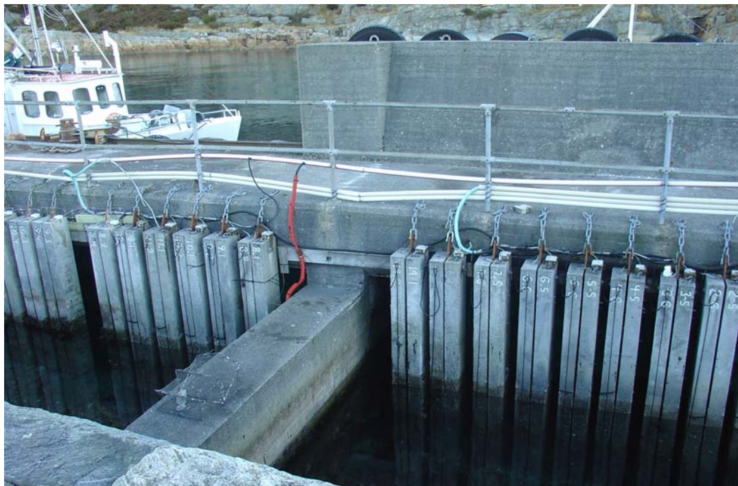
Bjelkeelementer opphengt i en kai på Solsvik utenfor Bergen
