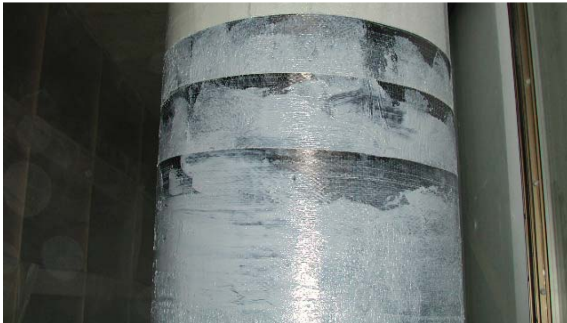
Karbonfiberforsterkning på en søyle (fra Postgirobygget)
