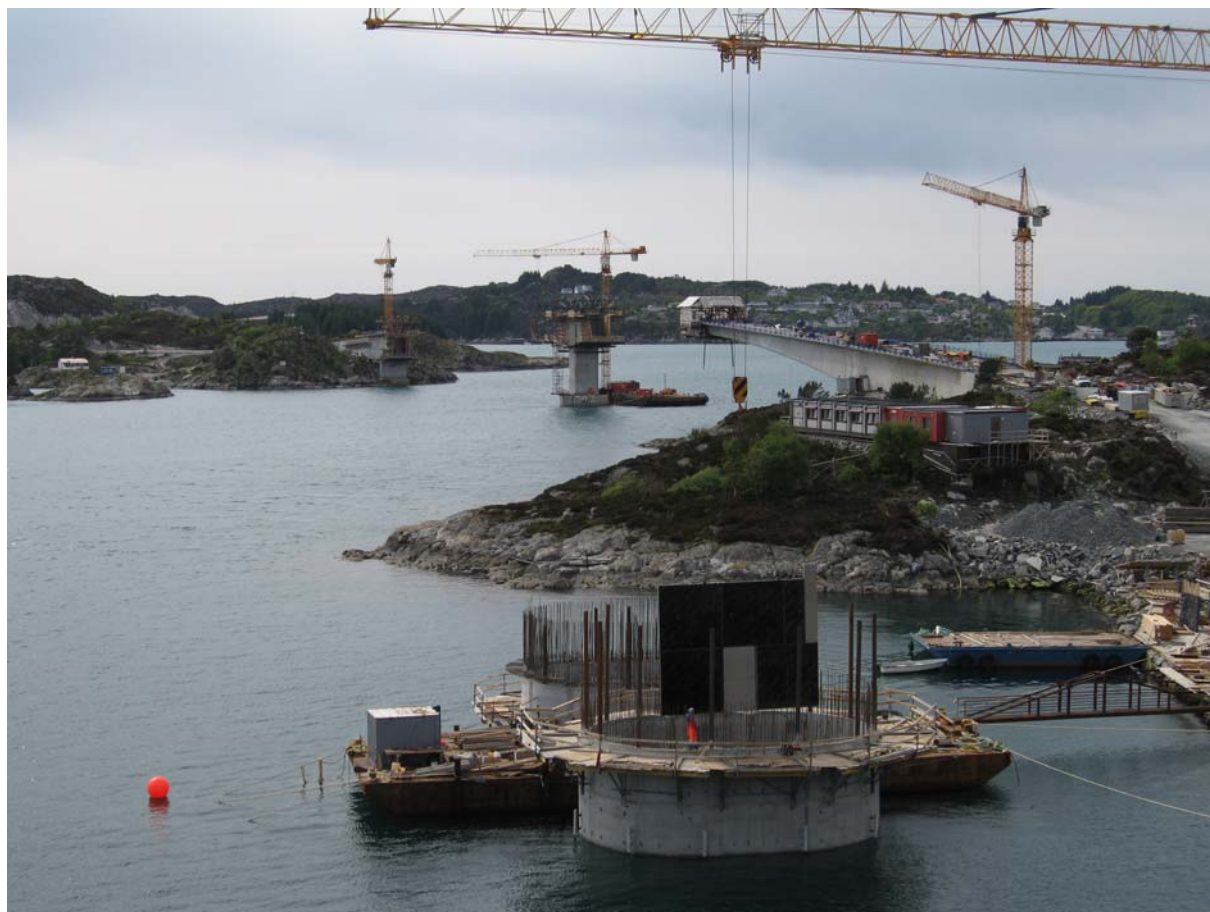
Fra bygging av Storholmenbrua i Austevoll kommune
