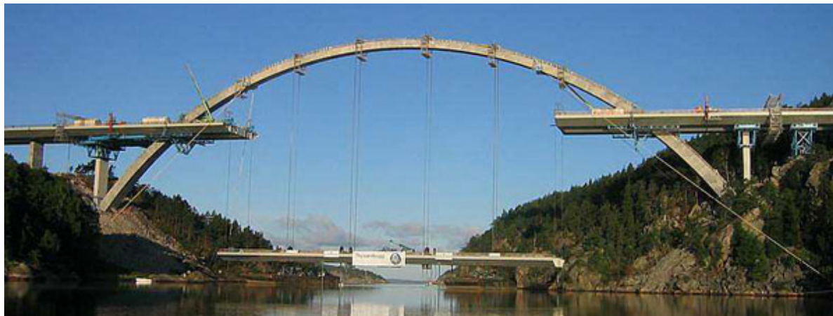
Svinesundsbrua under bygging
