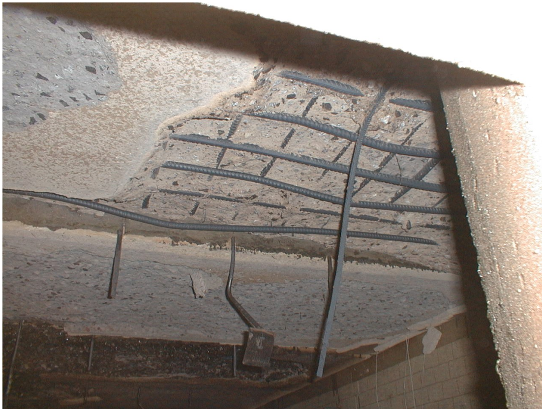
Resultatet av brannprøving av armerte elementer etter RWS-kurven. Betongen var IKKE tilsatt PP-fiber og brannbeskyttelsen falt av under brannforsøket
