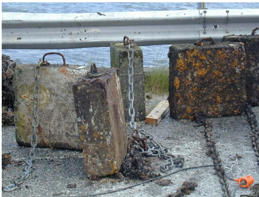
Betongelementer som har vært plassert ulike steder i tidevannssonen
