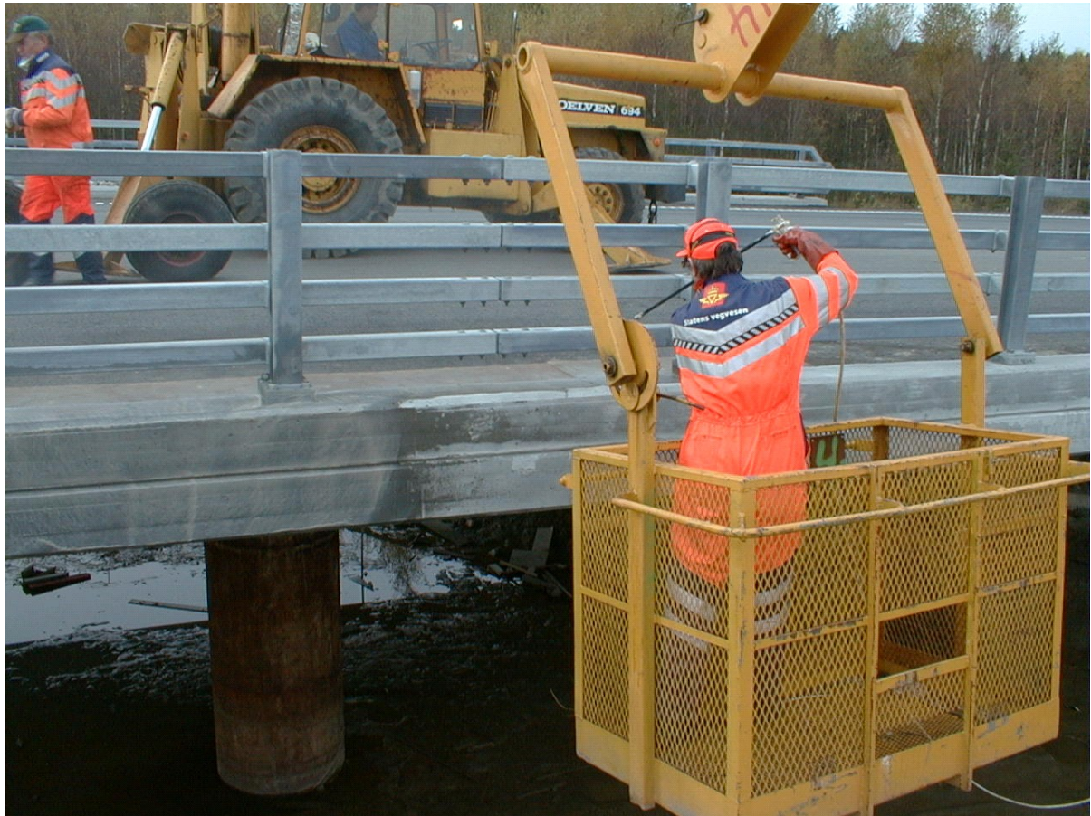
Påføring av silangel (hydrofobering) på en bru i Østfold
