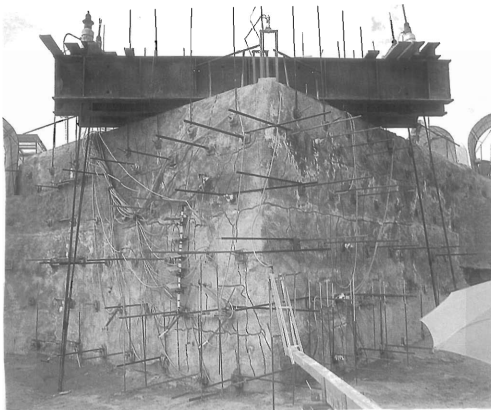
Figur 21. Fullskalaforsøk med soil nailing. (Bauer)
