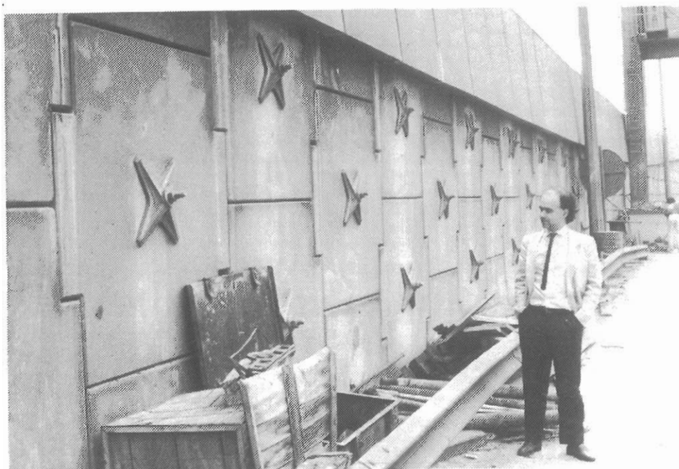
Figur 11. Veg av armert jord reparert med jordnagling.
