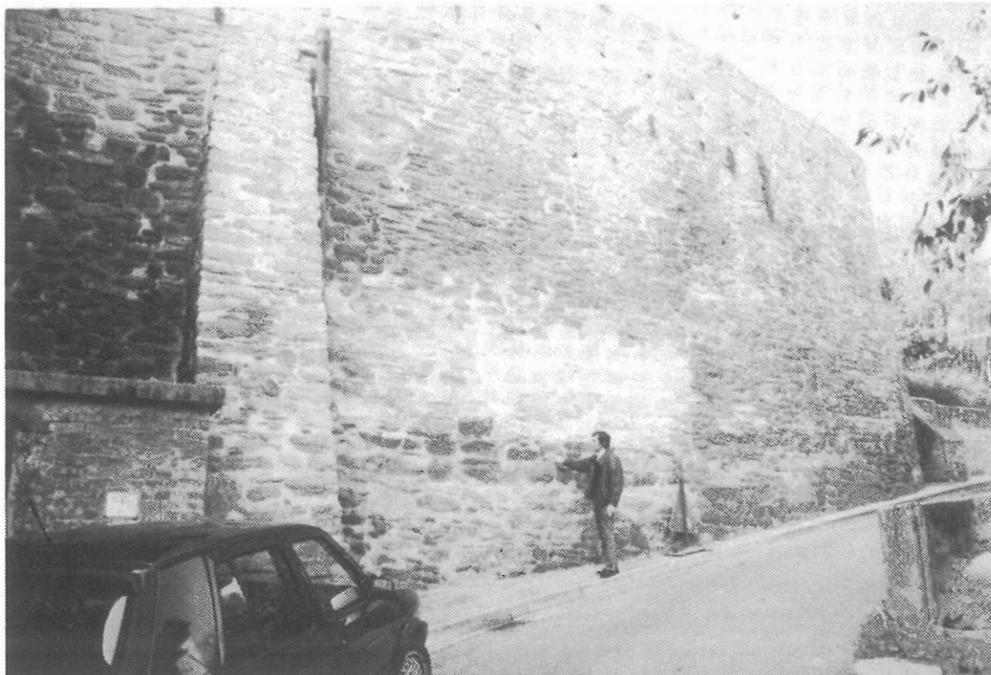
Figur 19. Reparasjon av steinmur ved Heilbronn.
