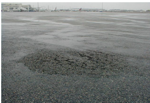
Figur 6 Konsekvenser av økte hjullaster på større lufthavner
