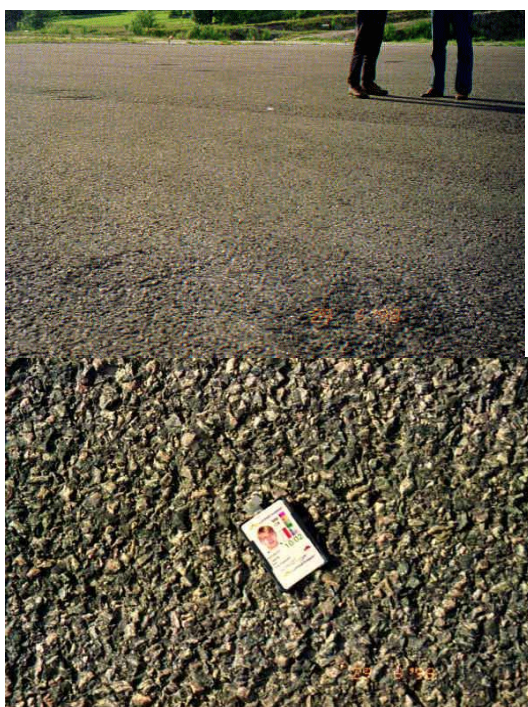
Figur 9 Molde lufthavn Ska 16
