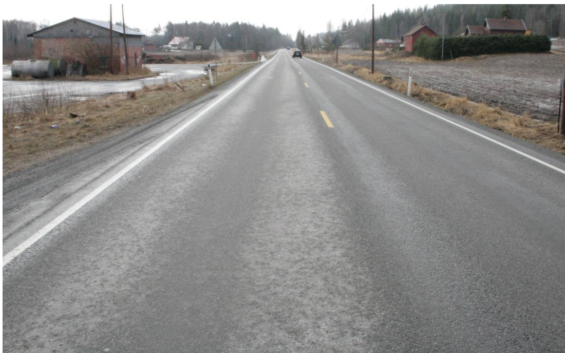
Figur 53: bildet viser opptørking av vegbanen ved V2 ( referansedekke Ska11 ) kl 10:59.
