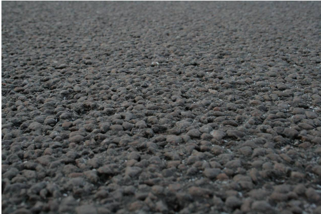
Figur 52: Vegbanen ved FF1 ( forsøksdekke Wa8 over Da16 ) kl 06:55. Vegbanen er fuktig, men det er ikkje fritt vatn til stades.
