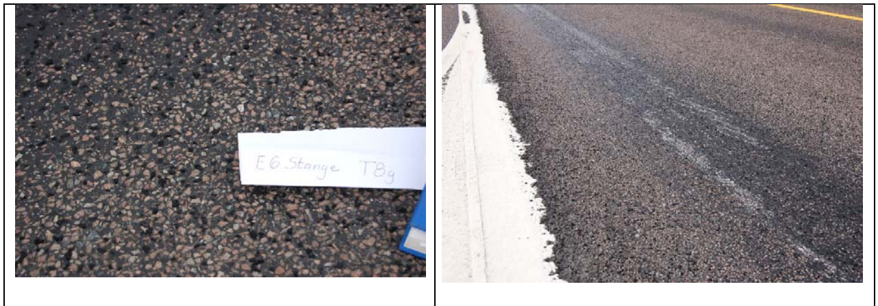
Figur19: Foto av dekke med gummigranulat, T8g, E6 Stange, 15. mai 2008
