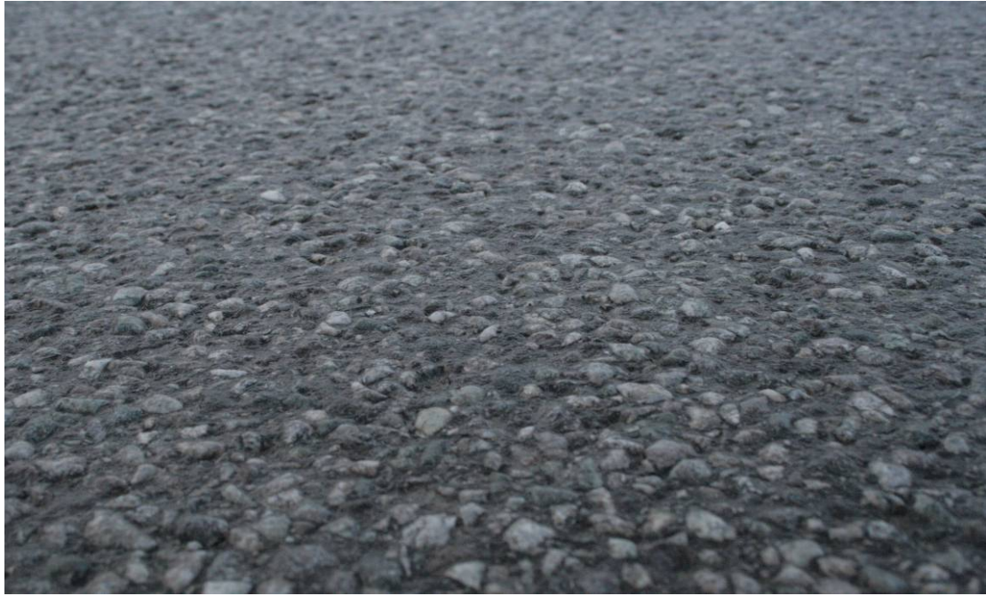
Figur 56: Vegoverflata ved V2 ( Referansedekke Ska11 ) kl 06:50. Ingen uoppløyste saltkorn er synlige.
