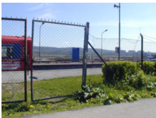
Barriere mellom gang-/sykkelvei og kollektivtrafikk: Vollebekk stasjon Foto: G.I.Rudolph
