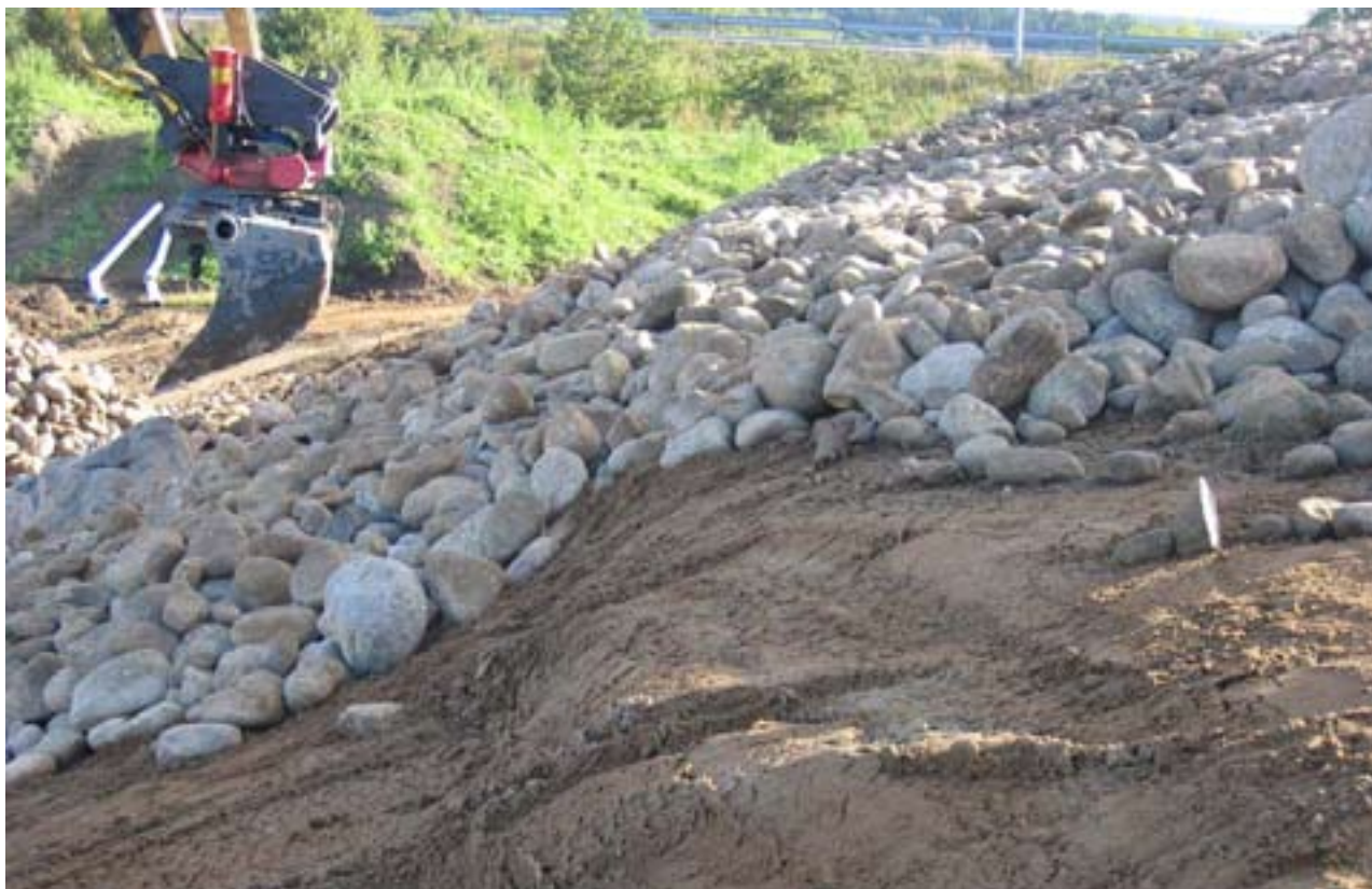
Figur 3_20: Utbulning under fiberduk der plastisk leire møter tørrskorpeleire, Bustgård (lokalitet 34). Foto: Kristin Marie Berg.
