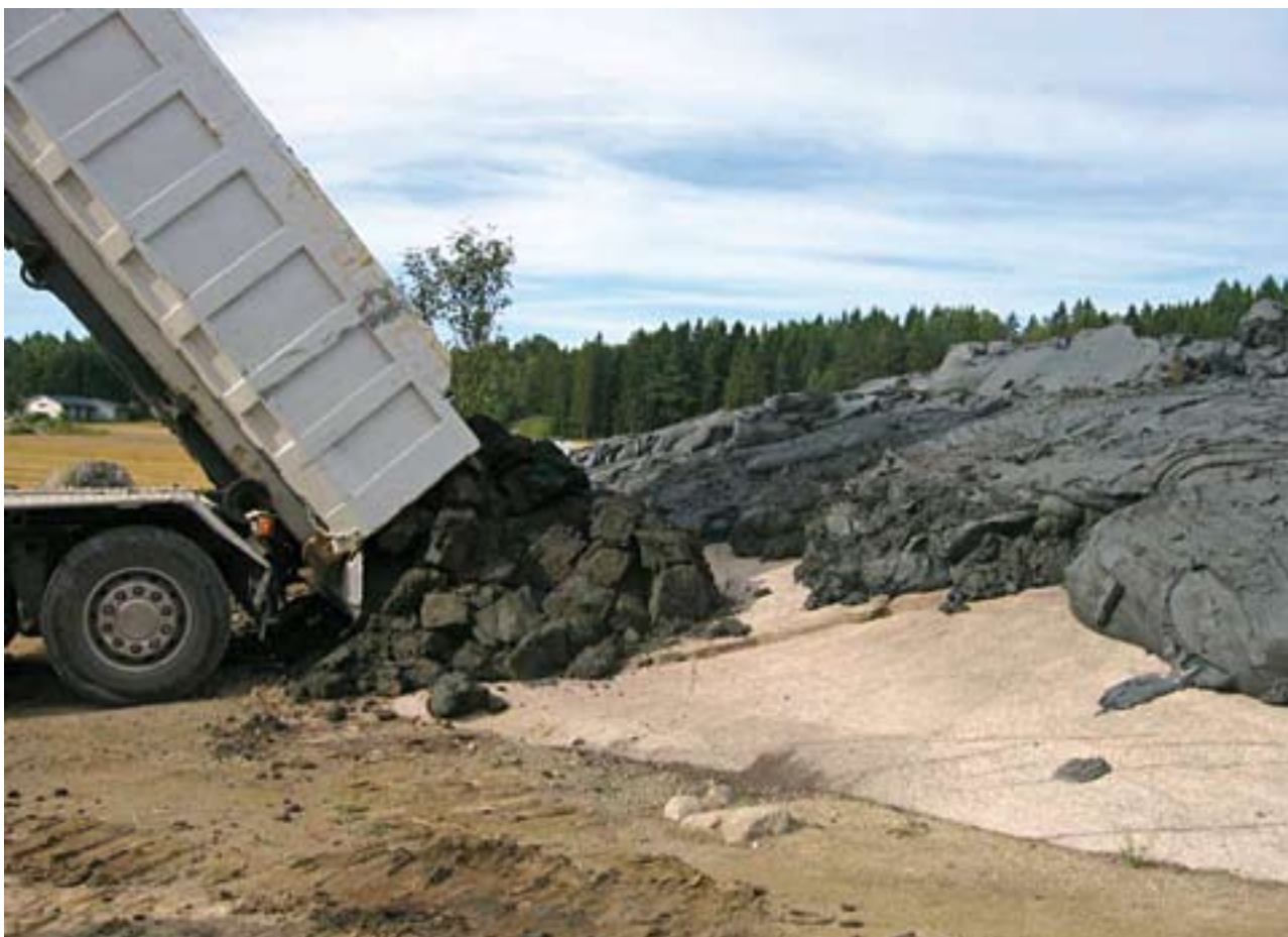
Figur 3_16: Tipping av tørrskorpeleire i underkant av plastisk leire for å holde denne på plass. Foto: Kristin Marie Berg.
