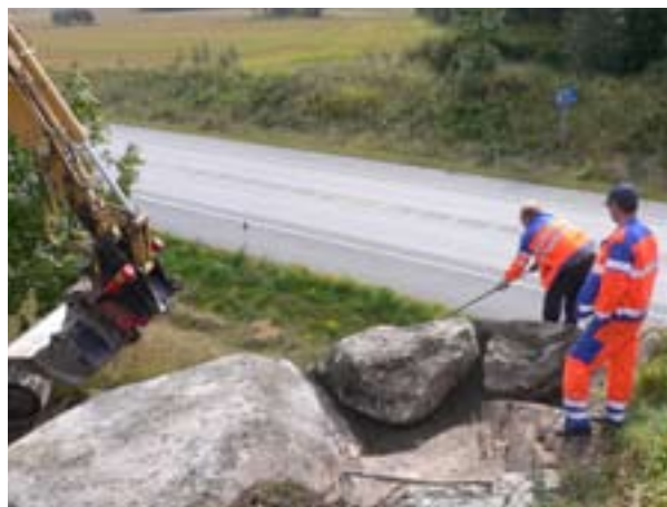
Figur 3_22: Stenbumlingar gjuts fast på den övre delen av Tunggården (lokal 17) för att leran ska ligga kvar och inte glida ned på E6. Foto: E6-projektet Østfold, Kulturhistorisk museum.
