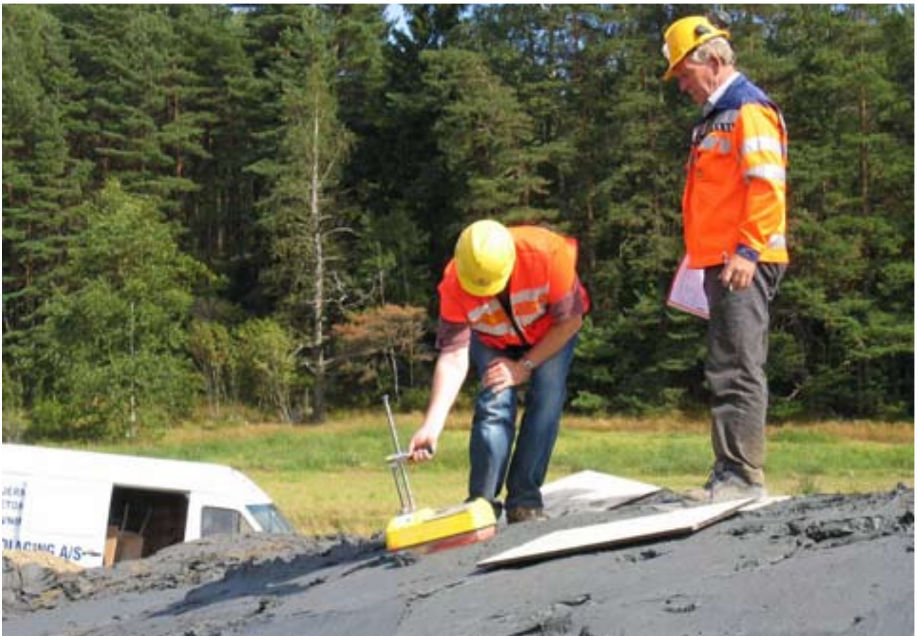
Figur 3_18: Det vert utført troxler-målingar på overflata av leirekappa for å måle pakningsgrad. Foto: Kristin Marie Berg.
