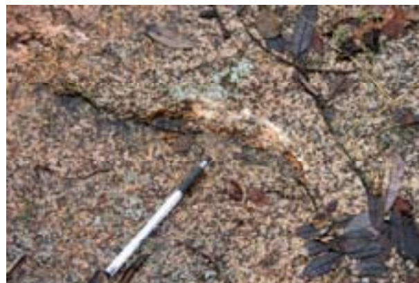
Figur 3_7: Bustgård (lokalitet 34). Typisk sterk overflateforvitring med lokalt 1–2 cm tjukk forvitringshud i langtidseksponert Iddefjordgranitt. Forvitringa er sterkast nær buskar og anna vegetasjon, der det blir danna humussyrer frå nedbryting av planterestar. På opne flater utan særleg innslag av lav var forvitringsomfanget tydeleg mindre. Foto: Per Hagelia.
