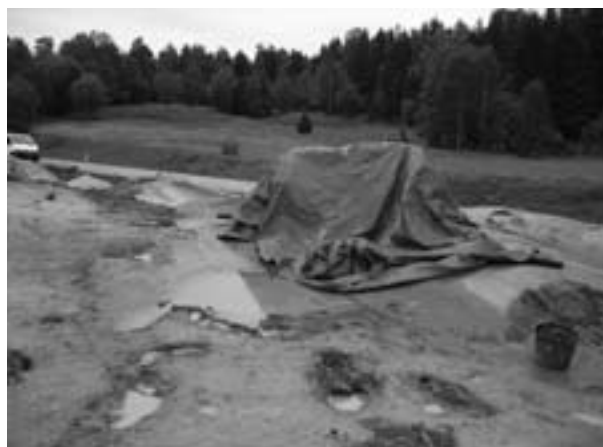
Figur 5_1: Presenningstelt i funksjon på Solberg nordre (lokalitet 27/XVII). Bildet er tatt mot nordøst. Helleristningsfeltet Solberg nordre (lokalitet 31) (ID 100238) befinner seg i skogkanten, like over bilen i høyre billedkant. Foto: E6-prosjektet Østfold, Kulturhistorisk museum.
