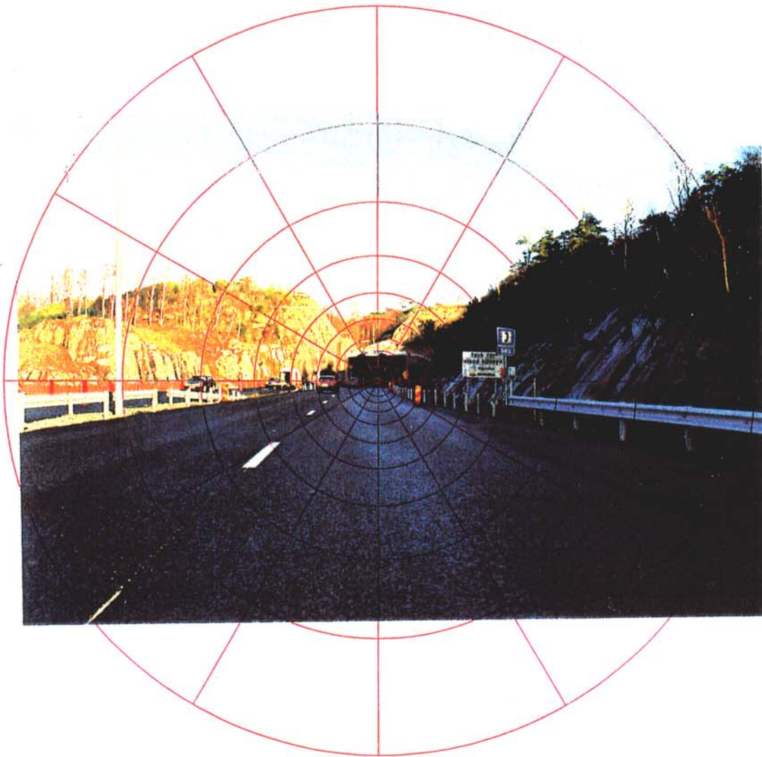
Fig. 5 Gnistängstunneln. Foto taget 110 m før tunnelindkørsel
