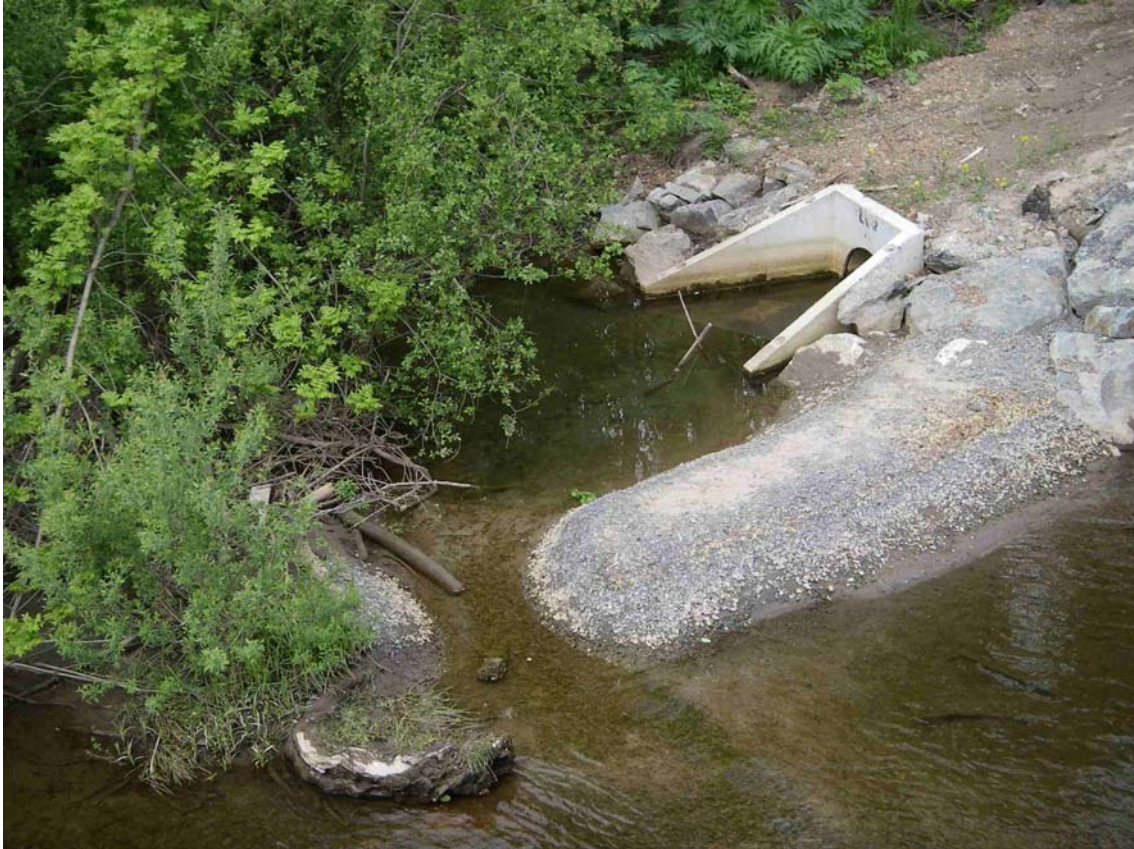
Figur 21. Utløpet av Wøyenbekken til Isielva i juni 2006.
