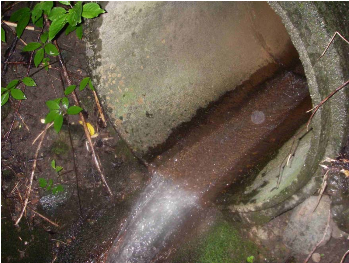
Figur 22. Grøfterør som slippes til Isielva ved Nybrua, dvs. der Økrivegen krysser Isielva.
