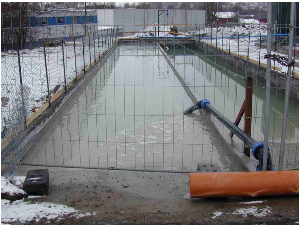
Figur 11. Plastøppte sedimentasjonsbasseng på Wøyen med to kammer for alternerende drift.
