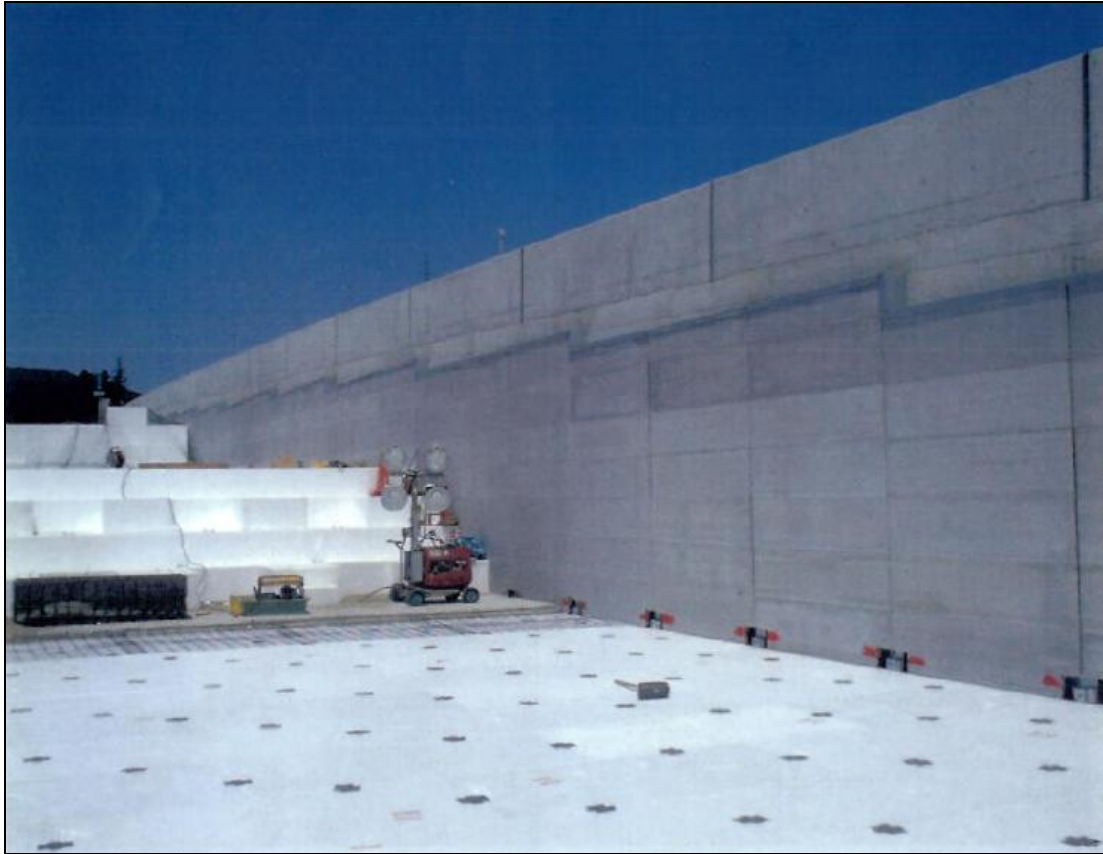
Figur 3 Beskyttelsesveggen i komposittmateriale fra første byggefase og nye blokker i andre fase stables opp.
