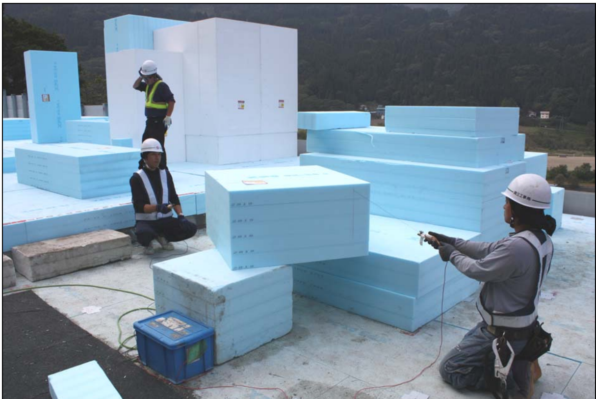
Figur 23 Kutting av EPS blokk med "glødende" tråd.
