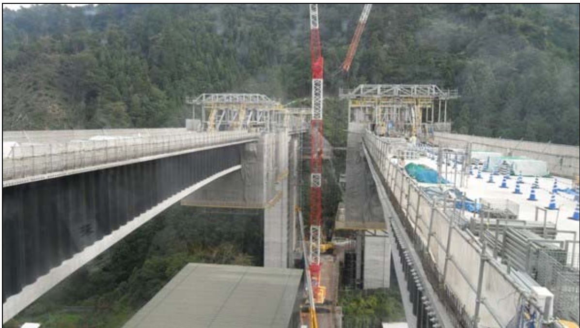
Figur 12 De to bruene under oppføring. Utsikt fra anleggsheisen.
