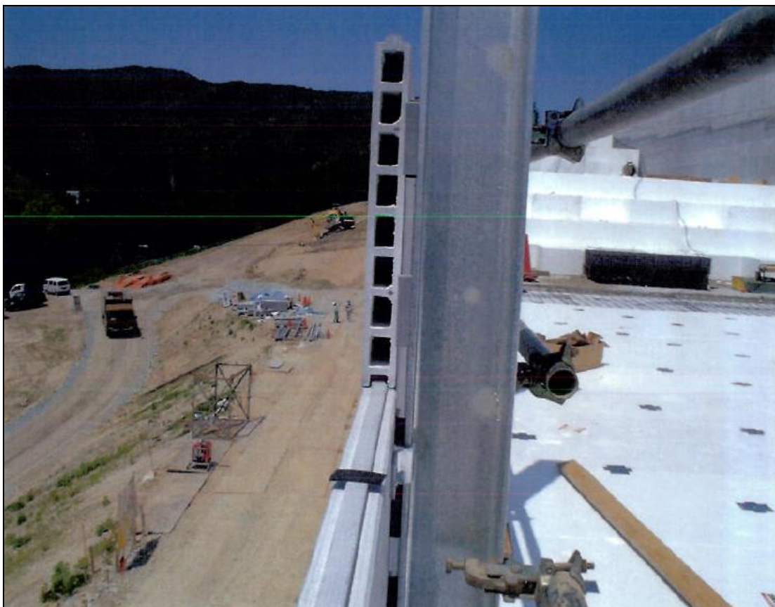
Figur 4 Bildet viser den vertikale oppbygningen med komposittpanel ytterst, H-bjelke og EPS på innsiden.
