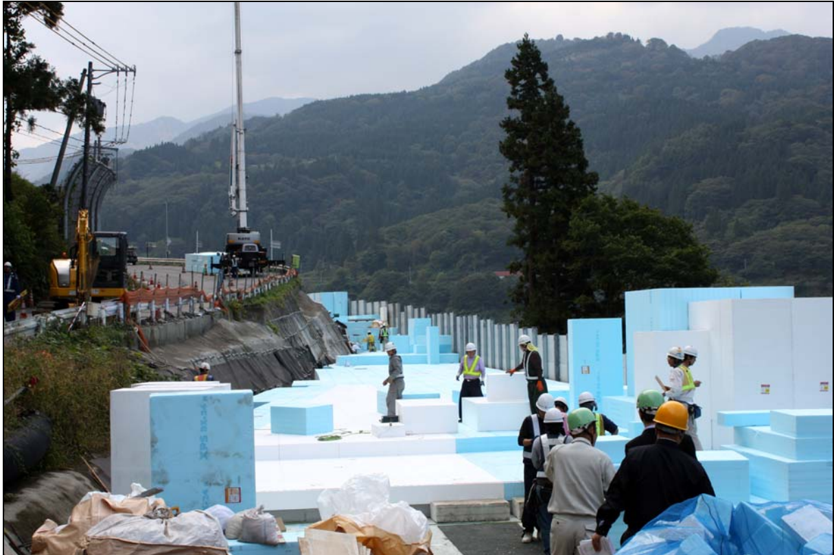
Figur 22 Bygging av EPS fylling Otari Road.
