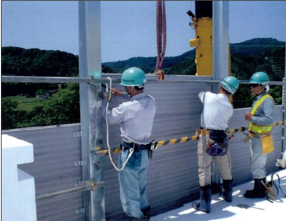
Figur 5 Festing av kompositt-panelene til H-bjelkene.
