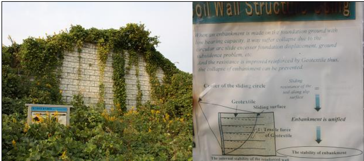
Figur 27 Testfylling hvor det har blitt brukt geosynteter.
