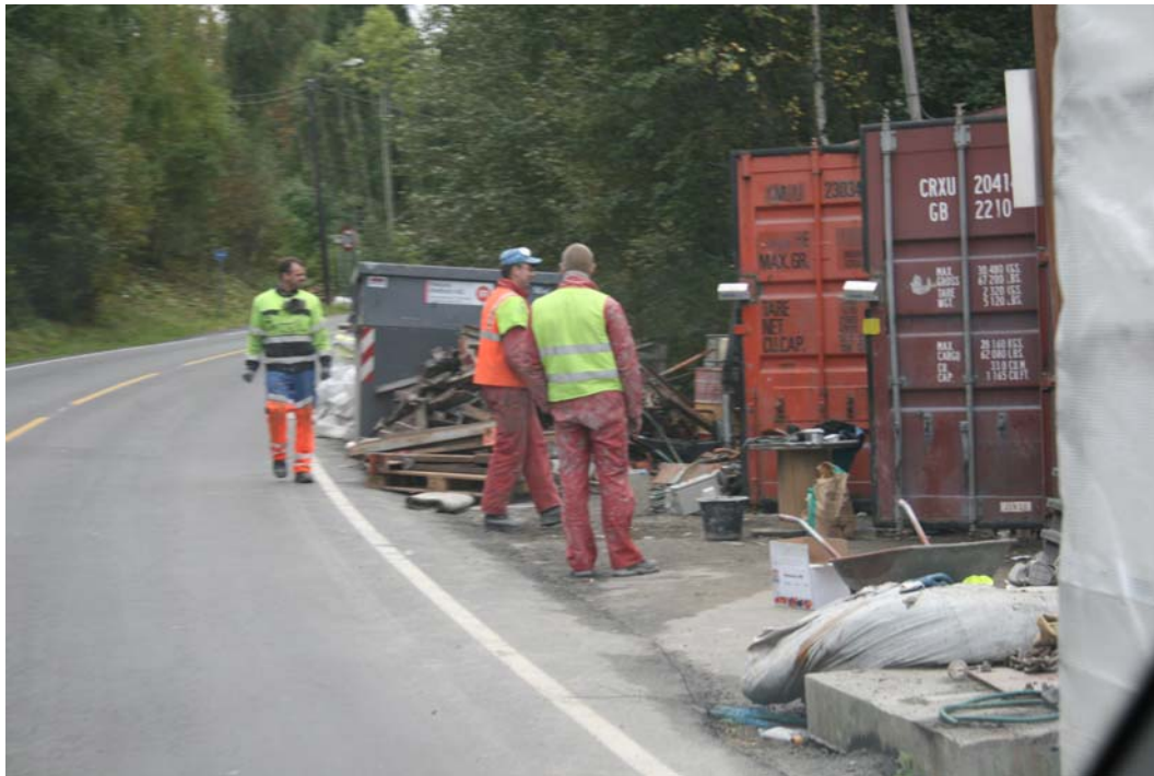
Figur 18 Observasjon 6 En arbeider i NS EN 471 Kl.3 arbeidstøy.
