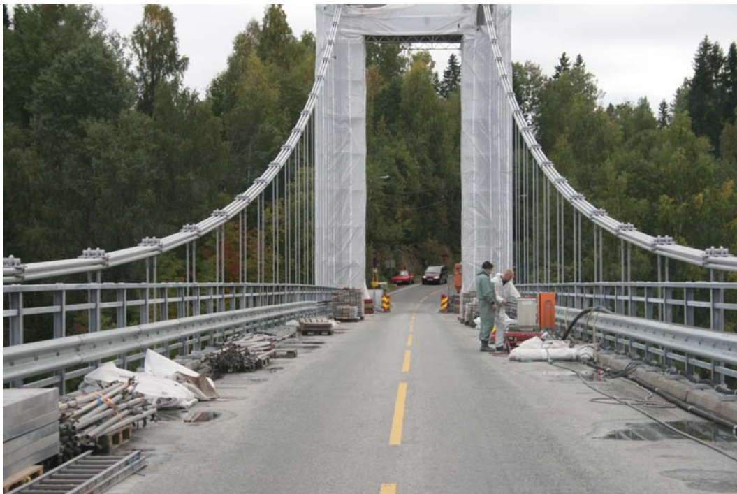
Figur 17 Observasjon 6 kont. Dette bilde forsterker inntrykket
