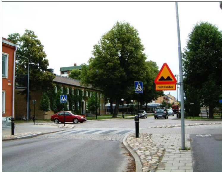
Figur 35 Opphøyd overgangsfelt og ulik steinsetting som fartsreducerende tiltak.
