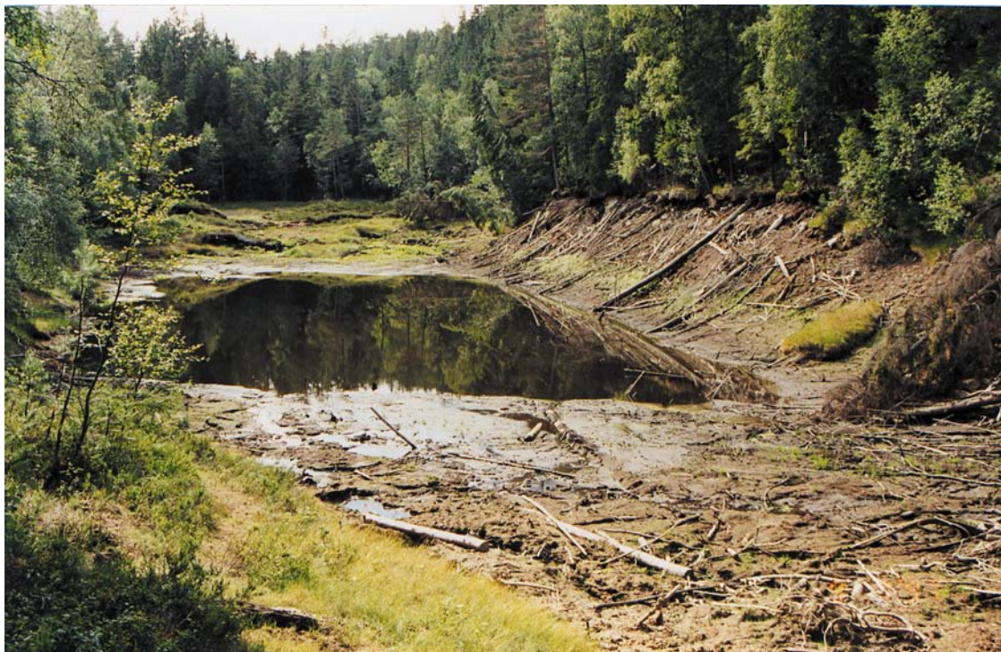
Figur 8 Puttjern i Østmarka i Oslo etter at lekkasjeskader oppstod og før avbøtende tiltak ble satt i verk (Foto: L. Erikstad).
