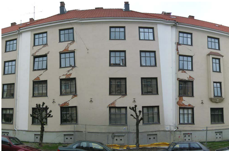
Foto B Fasade mot Gardeveien – utsnitt (bildet er fordreid)
