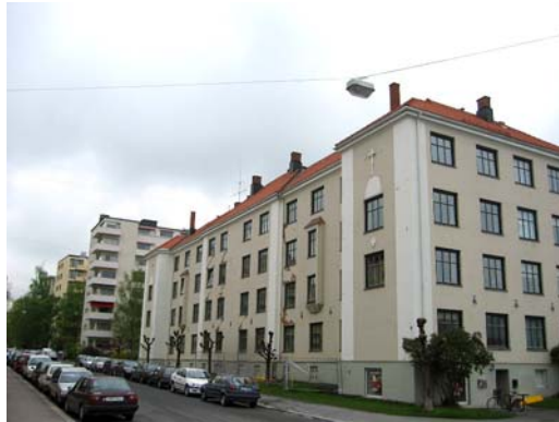
Foto A Fasade mot Gardeveien – oversikt
