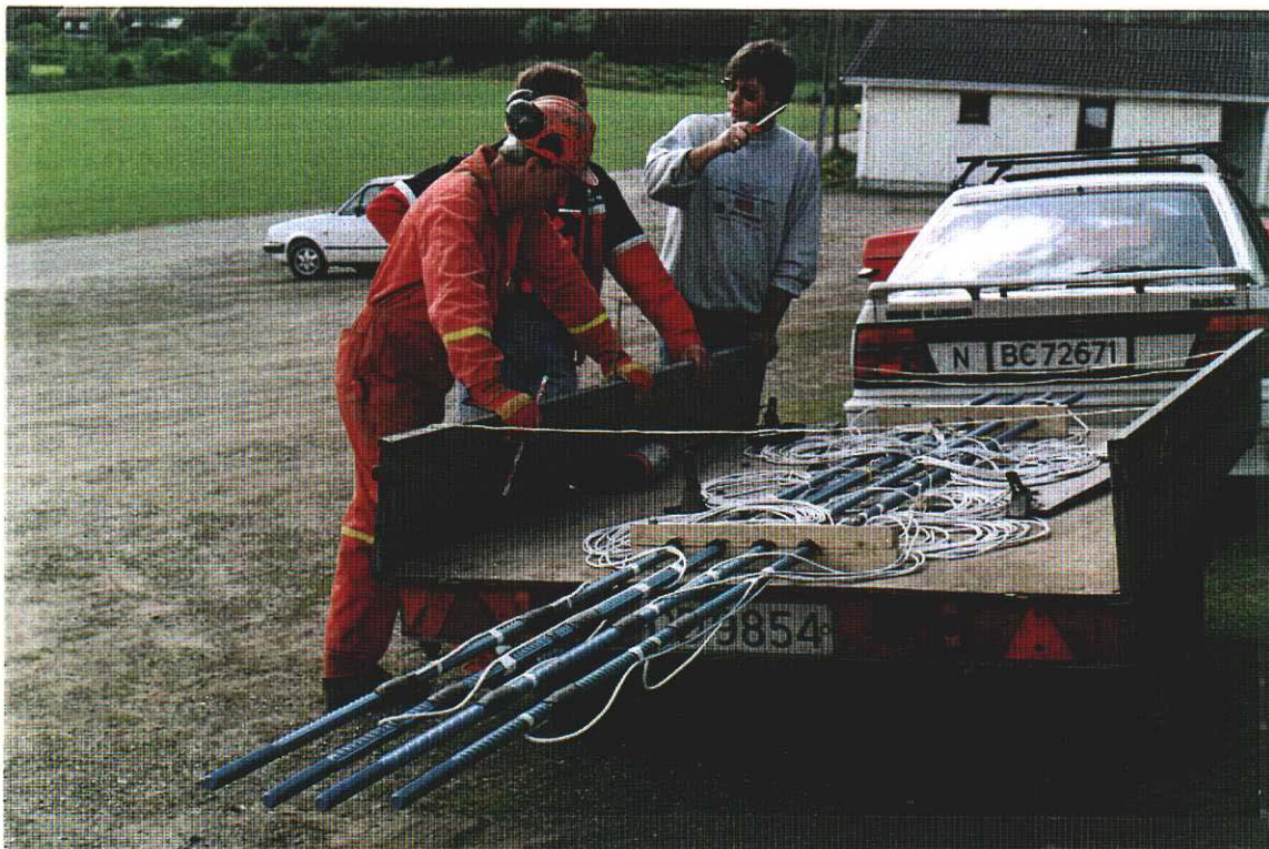
Figur 8.2 Ferdig monterte strekklapper på 4 stag
