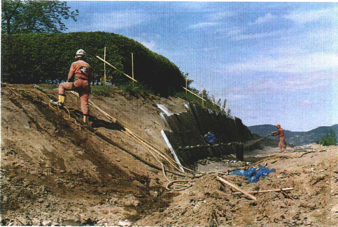
Bilde 5.3. Første nivå med kombinerte drens- og isolasjonsplater påføres 1.lag av sprøytebetong. Merk rørstussene for lettere gjennom boring ved stagsetting og enklere kontroll av tykkelse på betongen.
