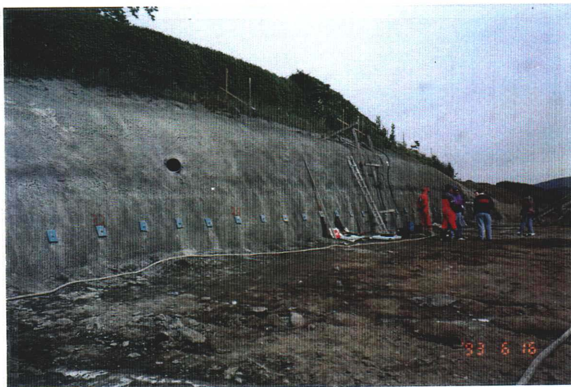
Bilde 5.10. Første og andre stagrad ferdig påsprøytet, mens tredje nivå er klargjort for avsluttende sprøyting( 16. juni 1993).
