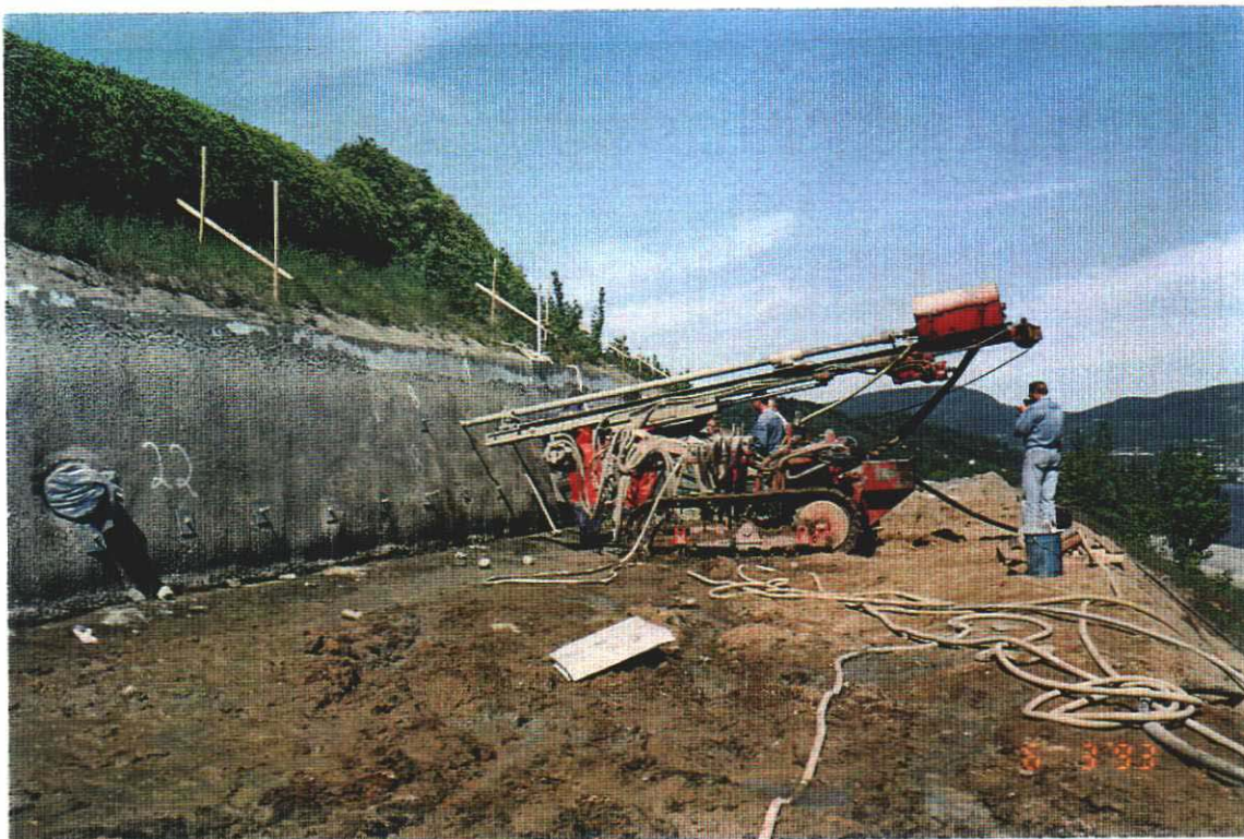
Bilde 5.9. Boring av hull for første stagrad( 3. juni 1993).
