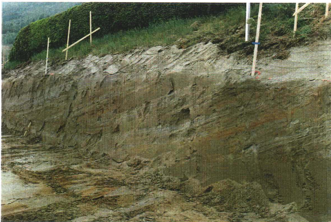
Bilde 5.2. Utgraving for første stagrad foretatt. Blottleggingen ga veldig god oversikt over grunnforholdene.
