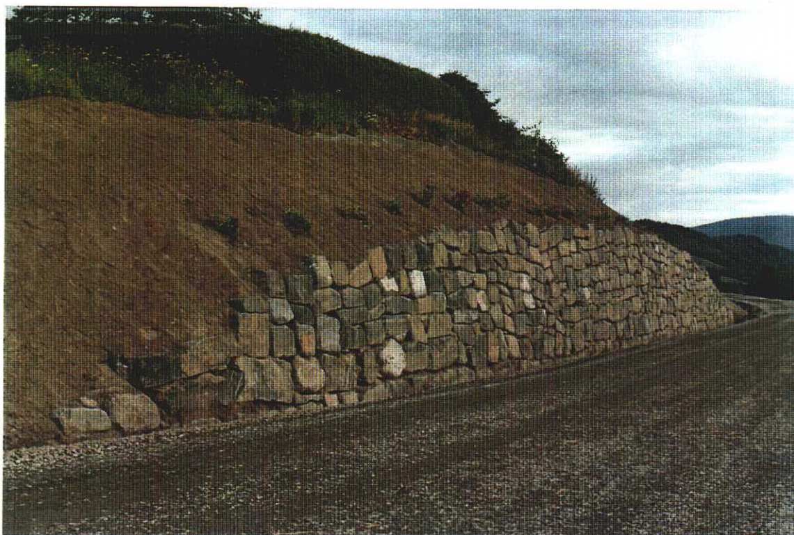
Bilde 5.14. Jordnaglingsprosjektet skjult bak endelig tørrmur, sett langs lokalvegen ( september 1993).
