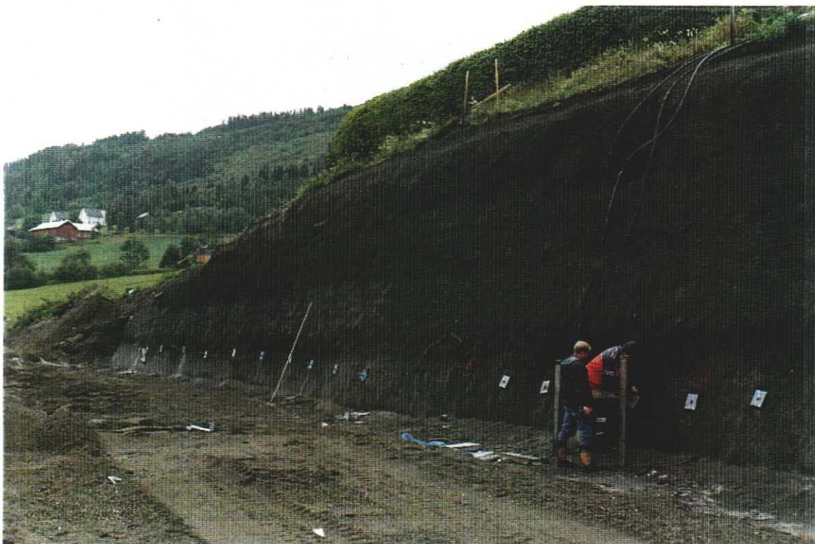
Bilde 5.11. Klargjøring for prøvebelastning av stag 5/20. De fire øvre stageradene er ferdig påsprøytet( 12. juli 1993).
