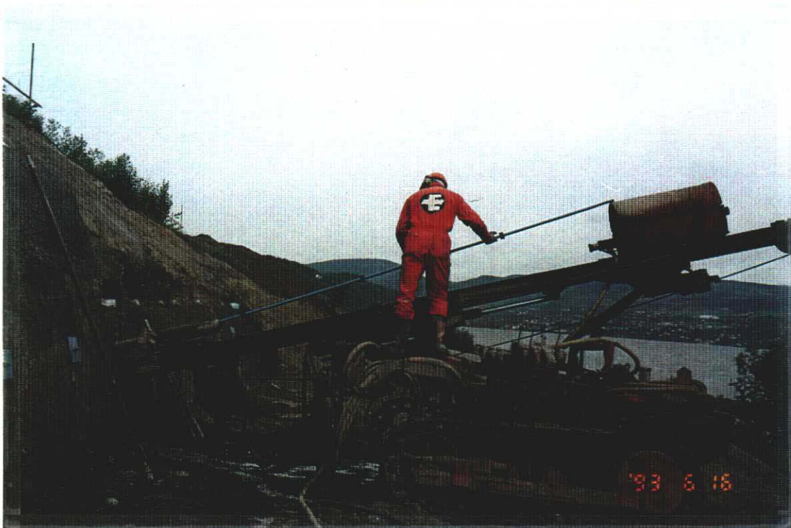
Bilde 5.4. Kamstålboltene installeres med avstandsholdere i foringsrør.
