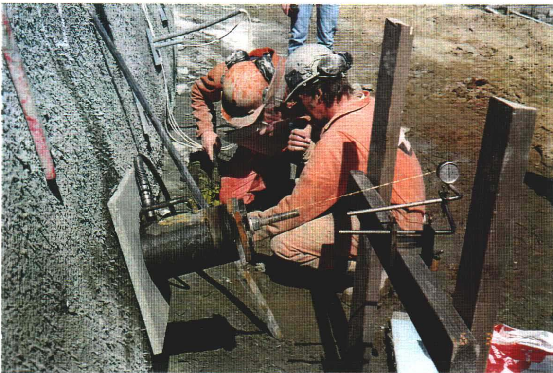
Bilde 5.8. Detaljer av måleoppsett under prøvebelastning i 2. stegrad( 3. juni 1993).
