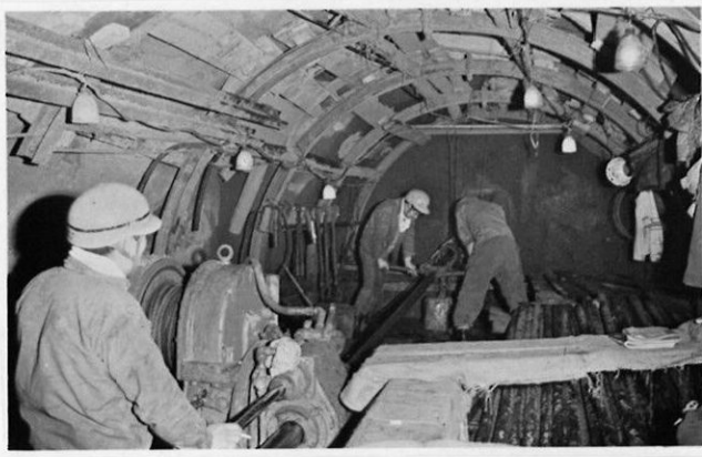
Undersøkellesboring før drift av pilot -og servicetunnel.
