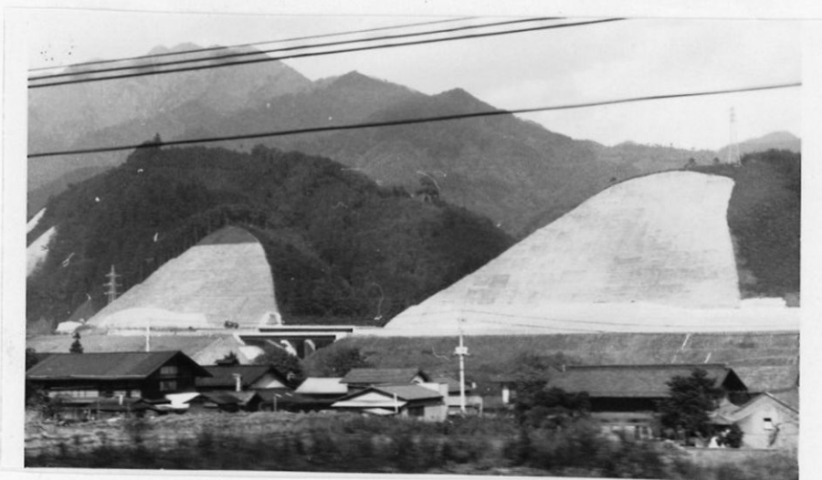
Omfattende skrånings-stabilisering preget Omfattende sikring av skråningene preget nye japanske hovedveger.
