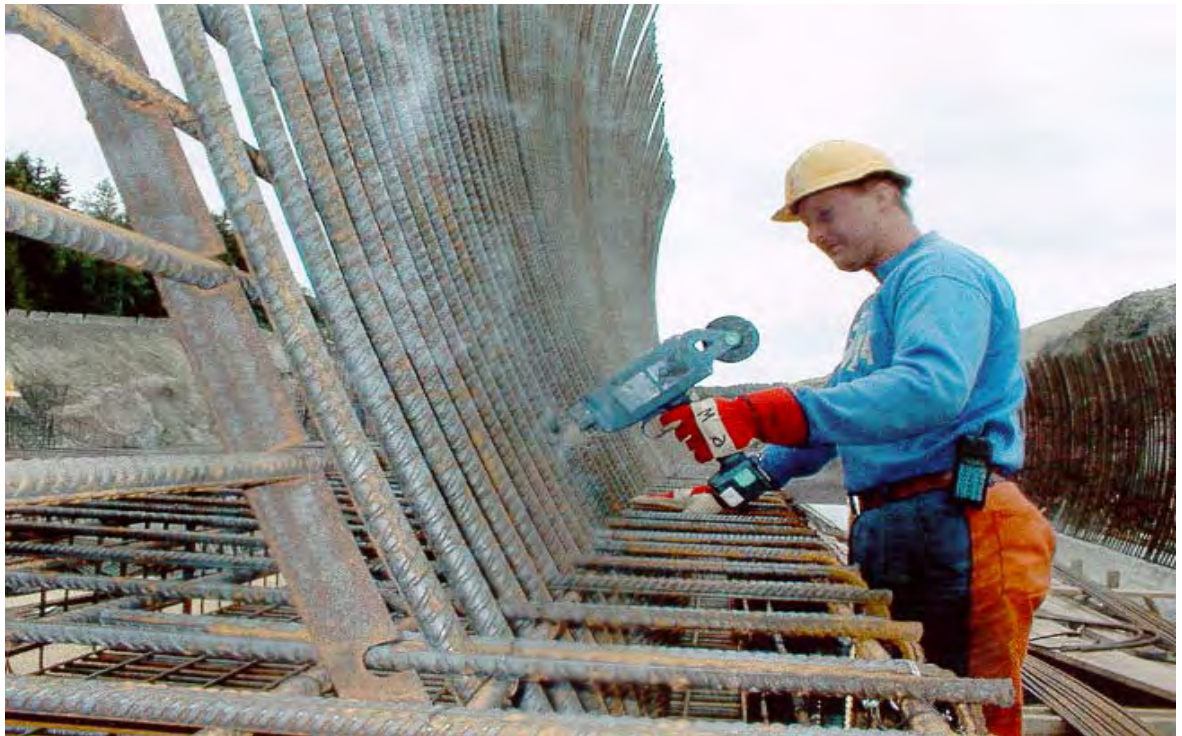
Figur 10. Binding av armering med bindepistol
