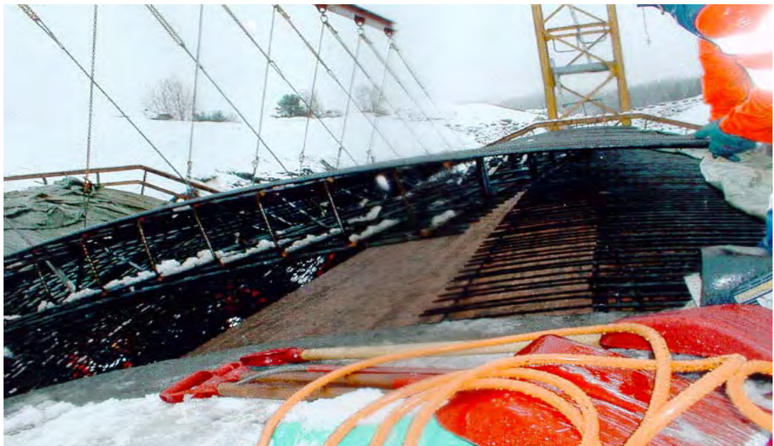
Figur 9. Andre hvelvarmeringskurv plasseres
