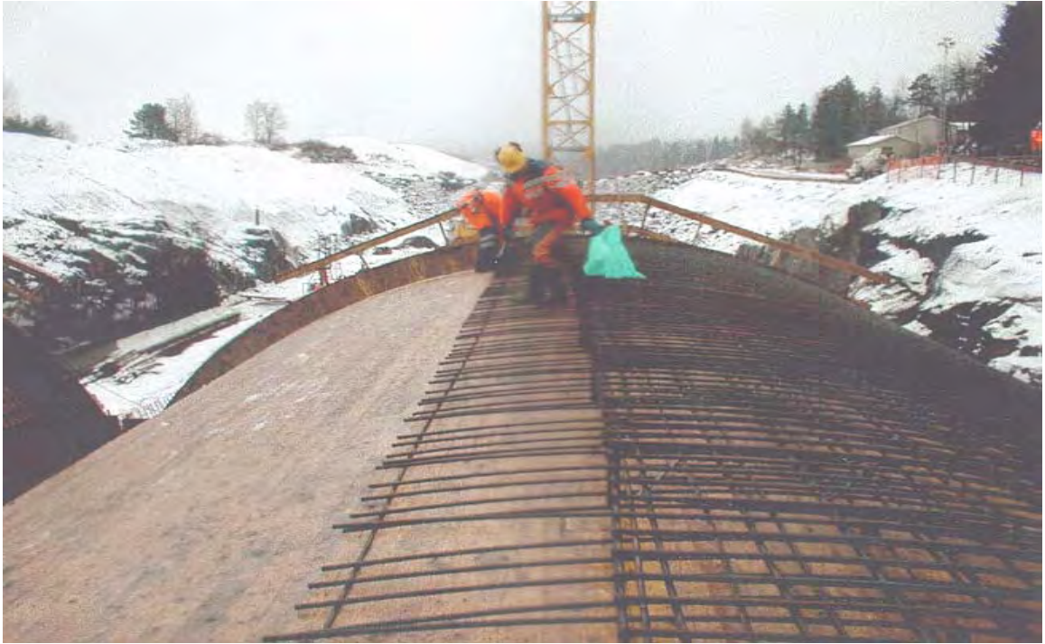
Figur 8. Første hvelarmeringskurv plassert
