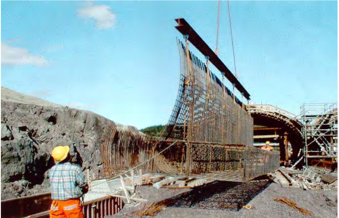
Figur 6. Sålearmering med skjøtejern til vegg
