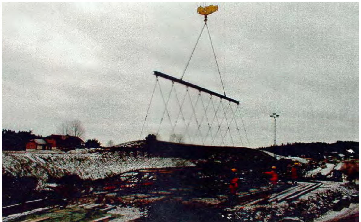
Figur 7. Løfting av hvelvarmeringskurv fra monteringsmalen
