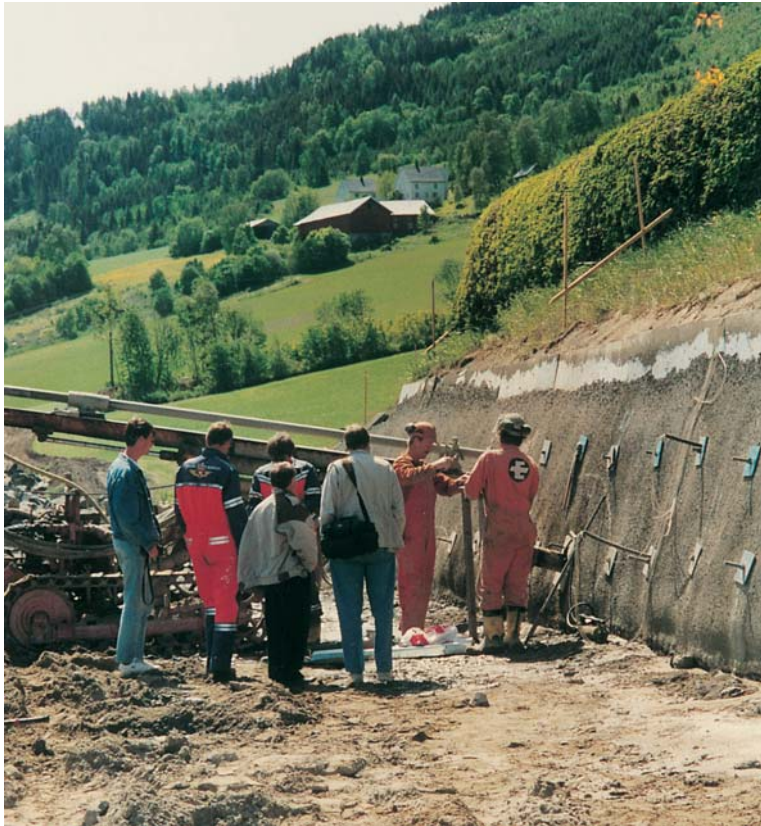
Bilde 7. Forberedelser til prøvebelastning i stagrad 2 (3. juni 1993).
