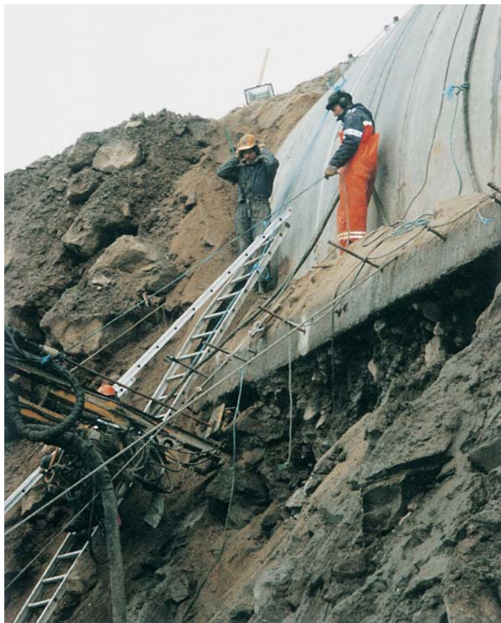
Bilde 18: Plasstøpt del av fundamentet for rasoverbygget er sikret. Boring pågår for første stegrad i skråningen.
