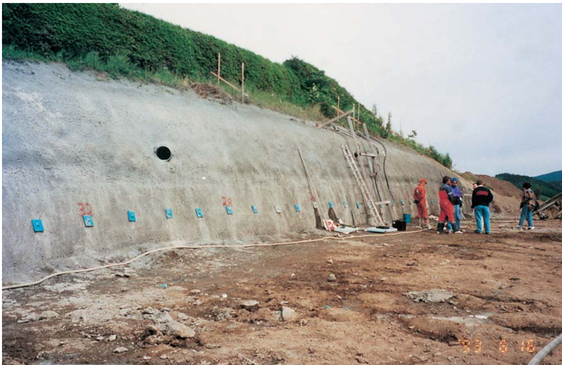
Bilde 10: Første og andre stagrad ferdig påsprøytet, mens tredje nivå er klargjort for avsluttende sprøyting (16. juni 1993).
