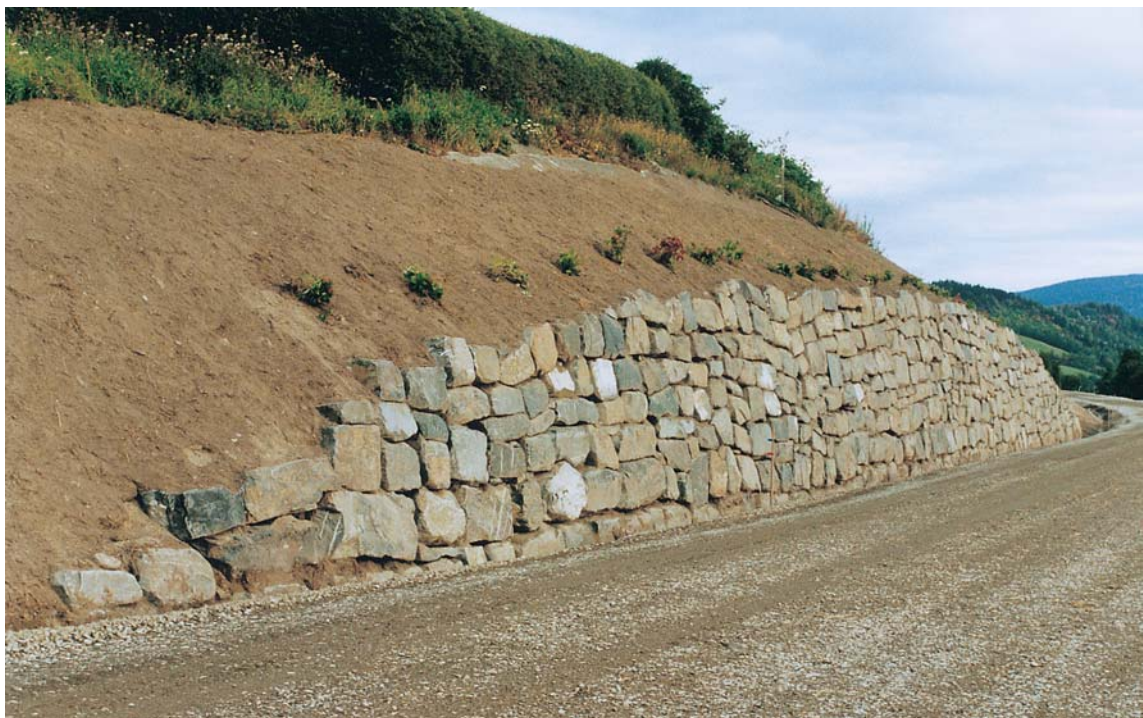
Bilde 14: Jordnaglingsprosjektet skjult bak endelig tørrmur, sett langs lokalvegen (september 1993).
