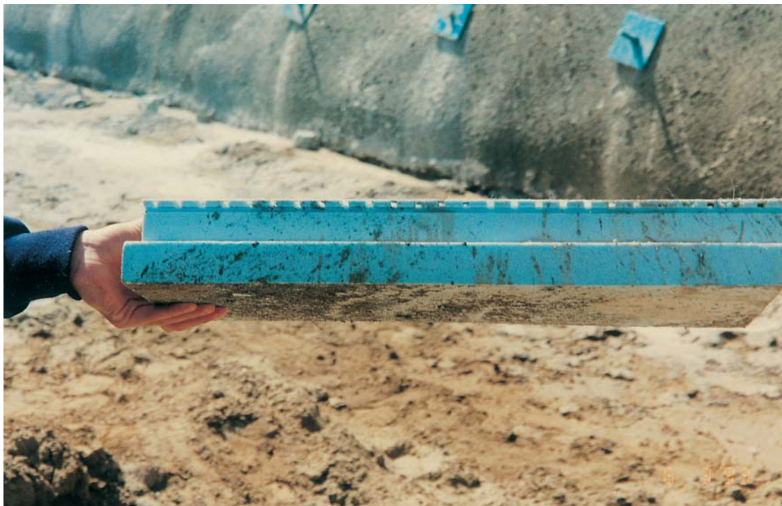
Bilde 6: Detalj av kombinert drens- og isolasjonsplate. Merk not/fjær-systemet som forenklet og sikret plassering av platene før og under påsprøyting av betong.
