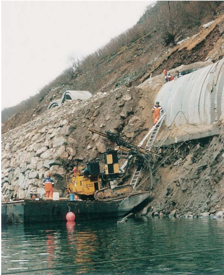
Bilde 17: Jordnagling pågår med sikring av skråningen nedenfor rasoverbygget.
