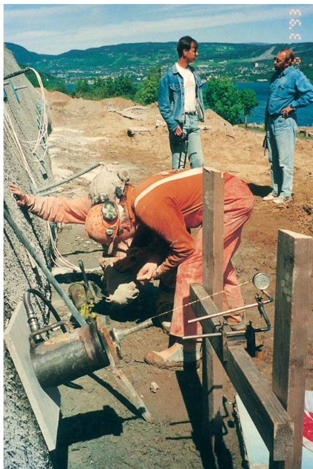
Bilde 8: Detalj av oppsett under prøvebelastning i 2. stagrad (3. juni 1993).
