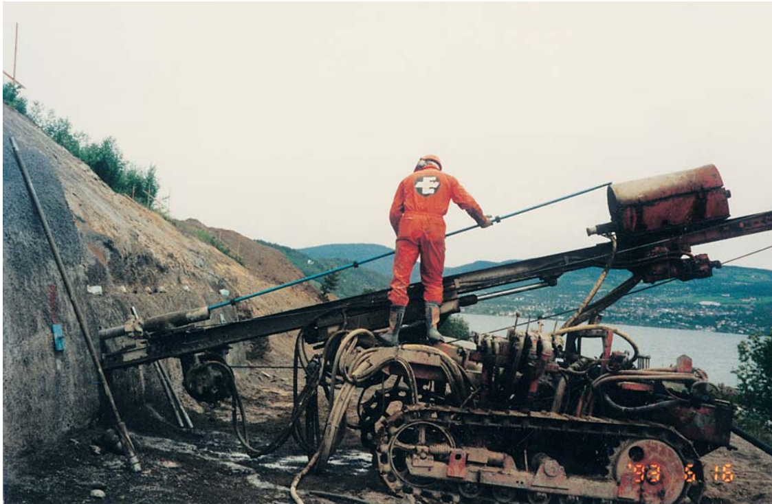
Bilde 5: Kamstålboltene installeres med avstandsholdere i føringsrør.
