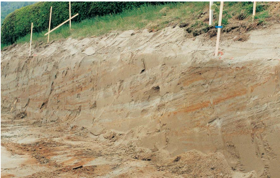
Bilde 2: Utgraving for første stagrad foretatt. Blottleggingen ga god oversikt over grunnforholdene.
