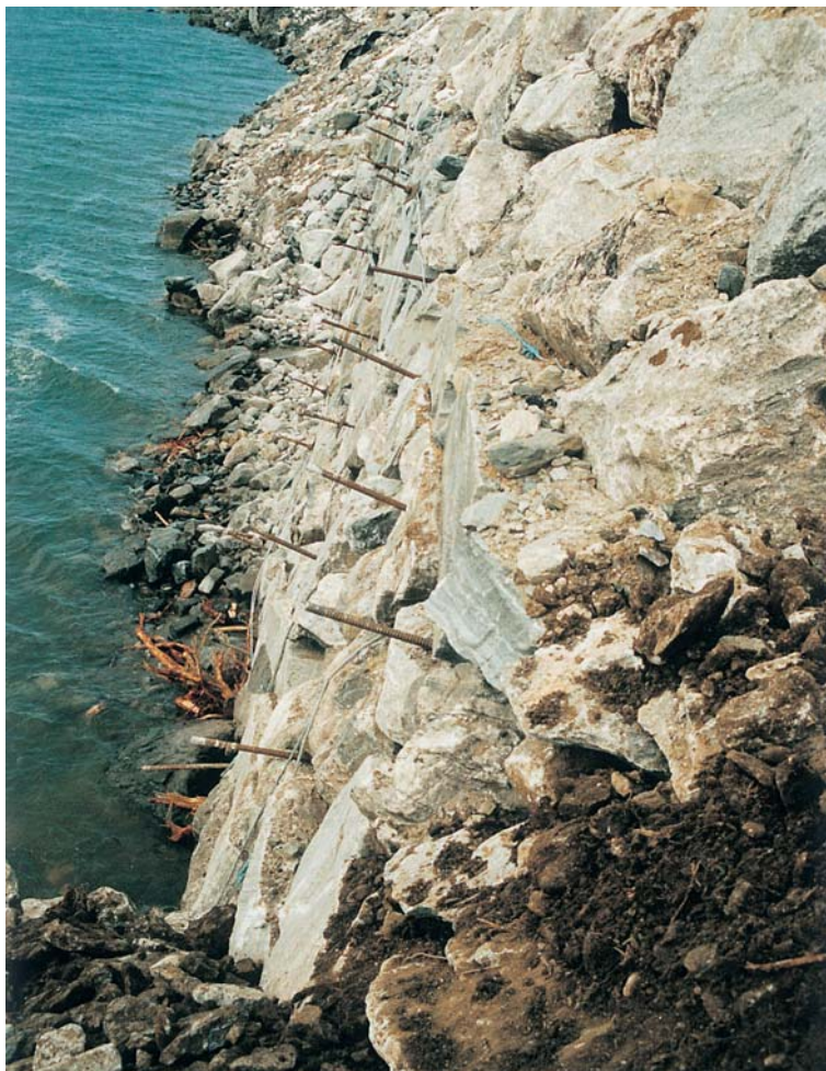
Bilde 20: Sikring av tørrmuren med jordnagler.
