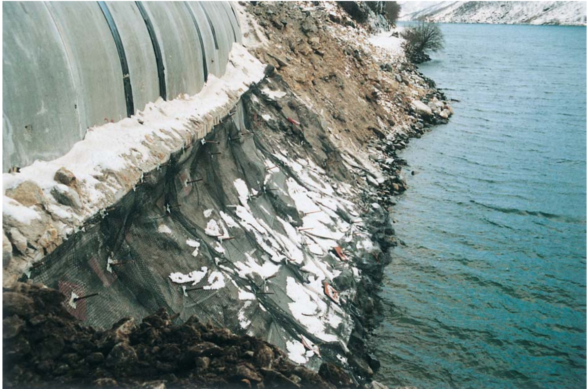
Bilde 19: Fundament og skråning ferdig sikret.
