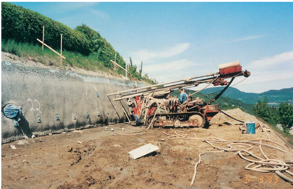
Bilde 4: Boring av hull for første stagrad (3. juni 1993).
