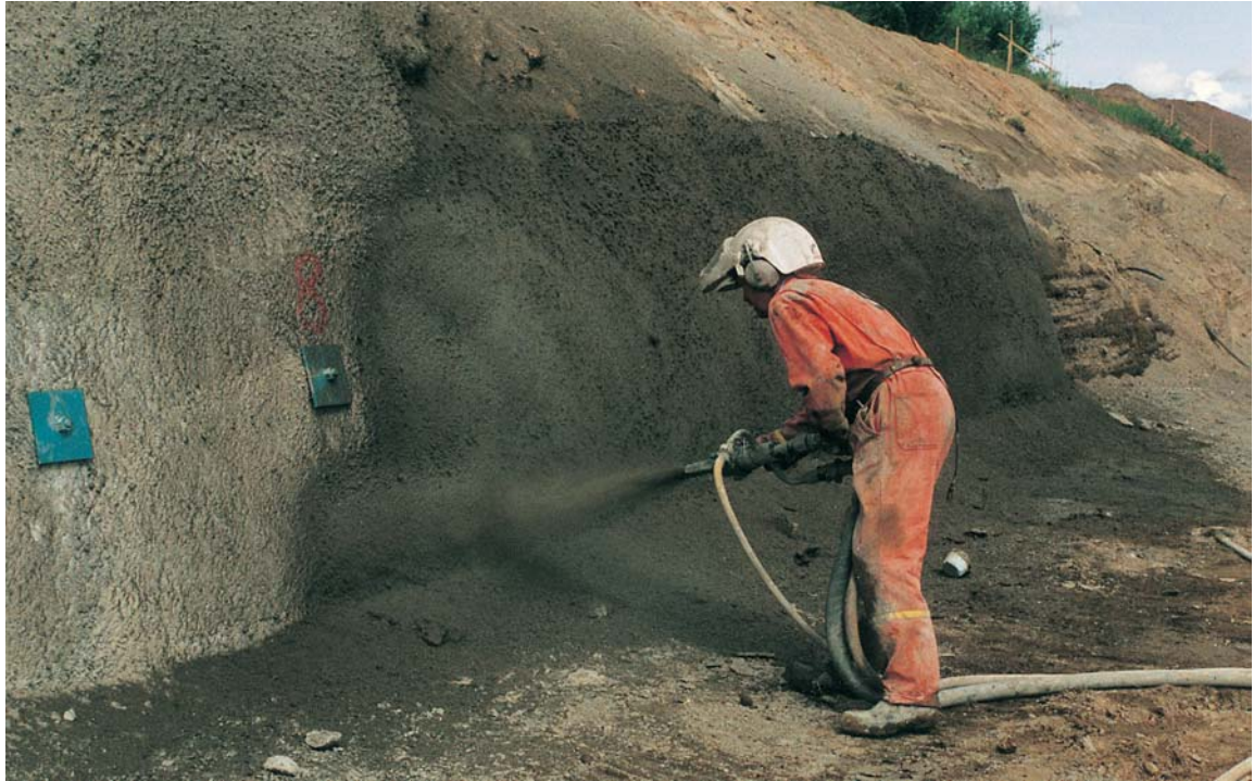
Bilde 9: Detalj av påføring av konserverende lag av sprøytebetong over staghodene i tredje rad.
