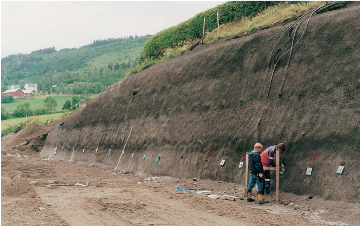
Bilde 11: Klargjøring for prøvebelastning av stag 5/20. De fire øvre stageradene er ferdig påsprøytet (12. juli 1993).
