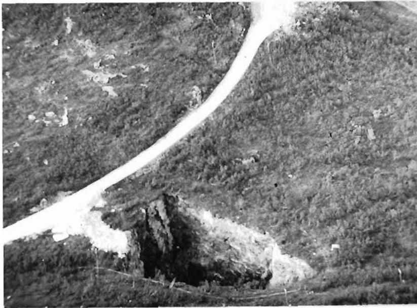
Fig. 1. Berggrunnen i Norge mangler materialer på overgangen mellom berg og løsmasser. Lokale brudd- eller omvandlingssoner kan imidlertid finnes. Krateret på bildet er forårsaket av ras i en tunnel som er drevet inn i en slik sone i grunnfjellgneis.
