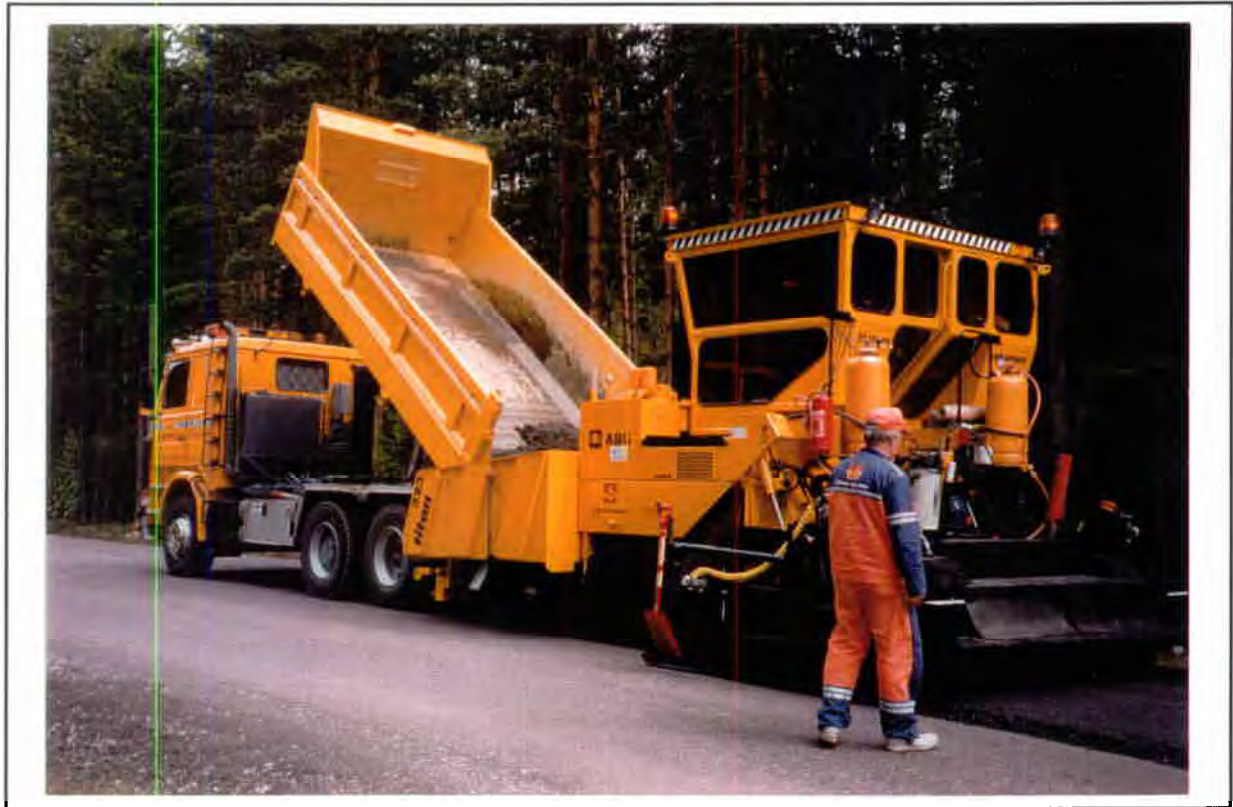
FIGUR 7 Utleggeren som ble brukt i Østfold
