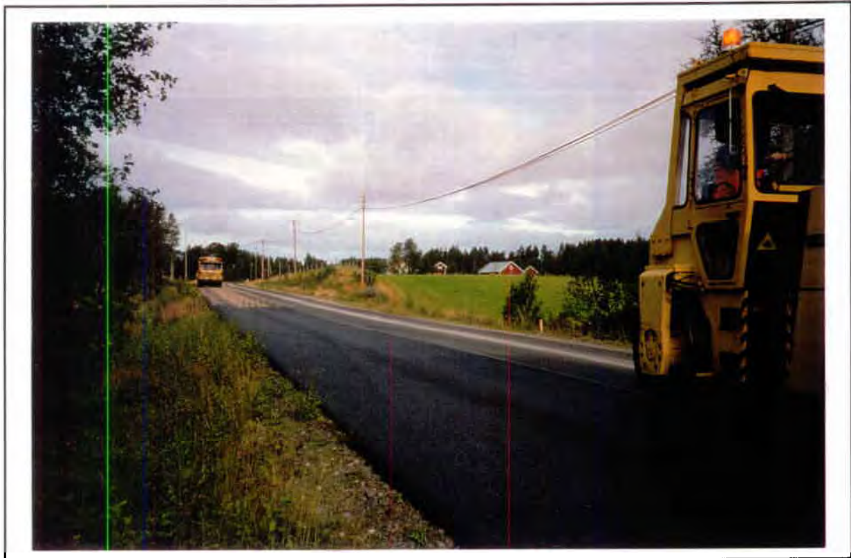
FIGUR 19 Bilde av utlagt dekke av Eska 12
