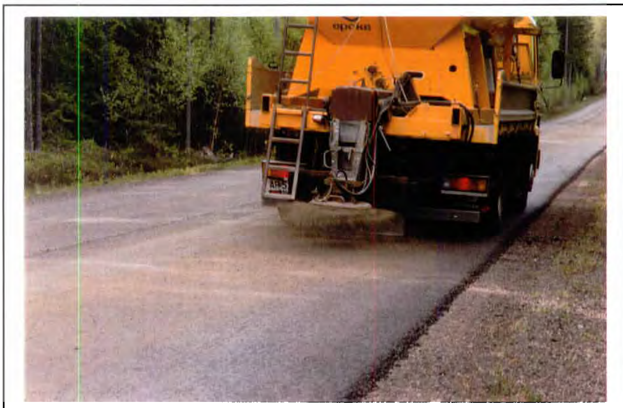
FIGUR 10 Avstrøing med 0-4 mm finsand
