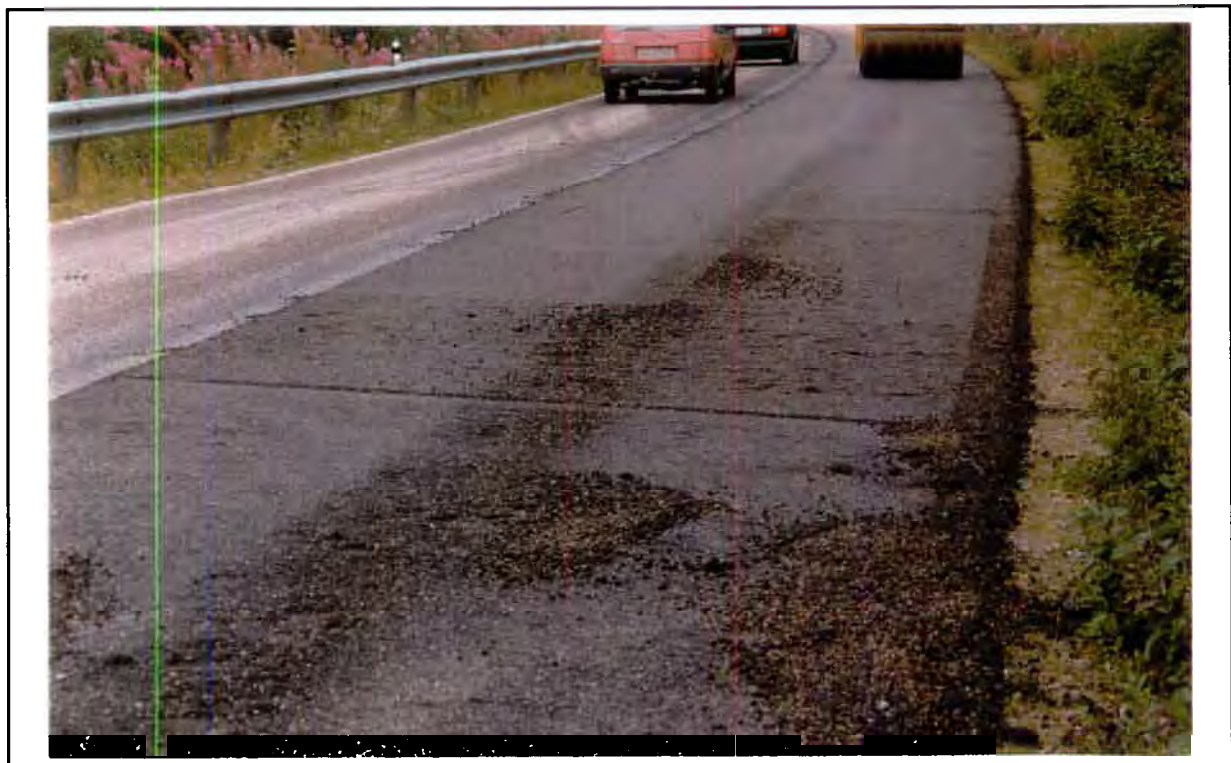
FIGUR 18 Bilde av utlagt dekke av Eb 12
