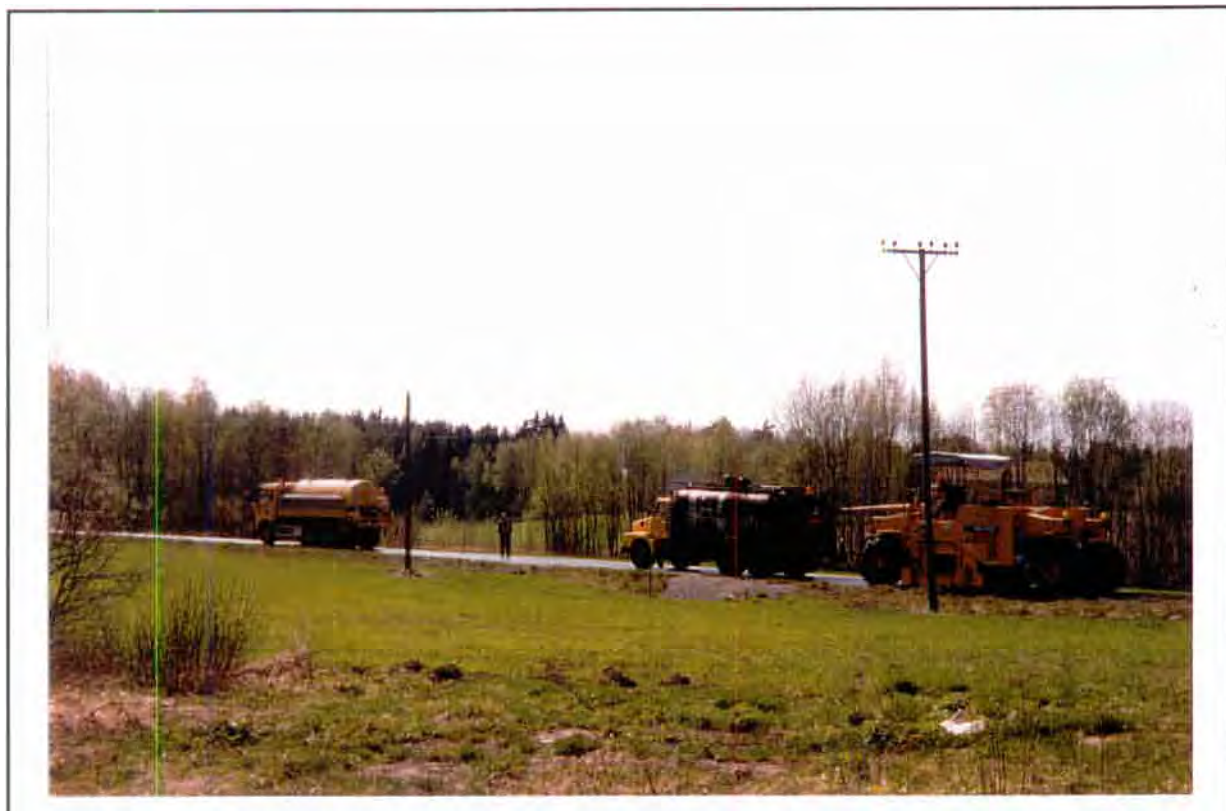
FIGUR 6 Gangen i forsterkningsarbeidet
