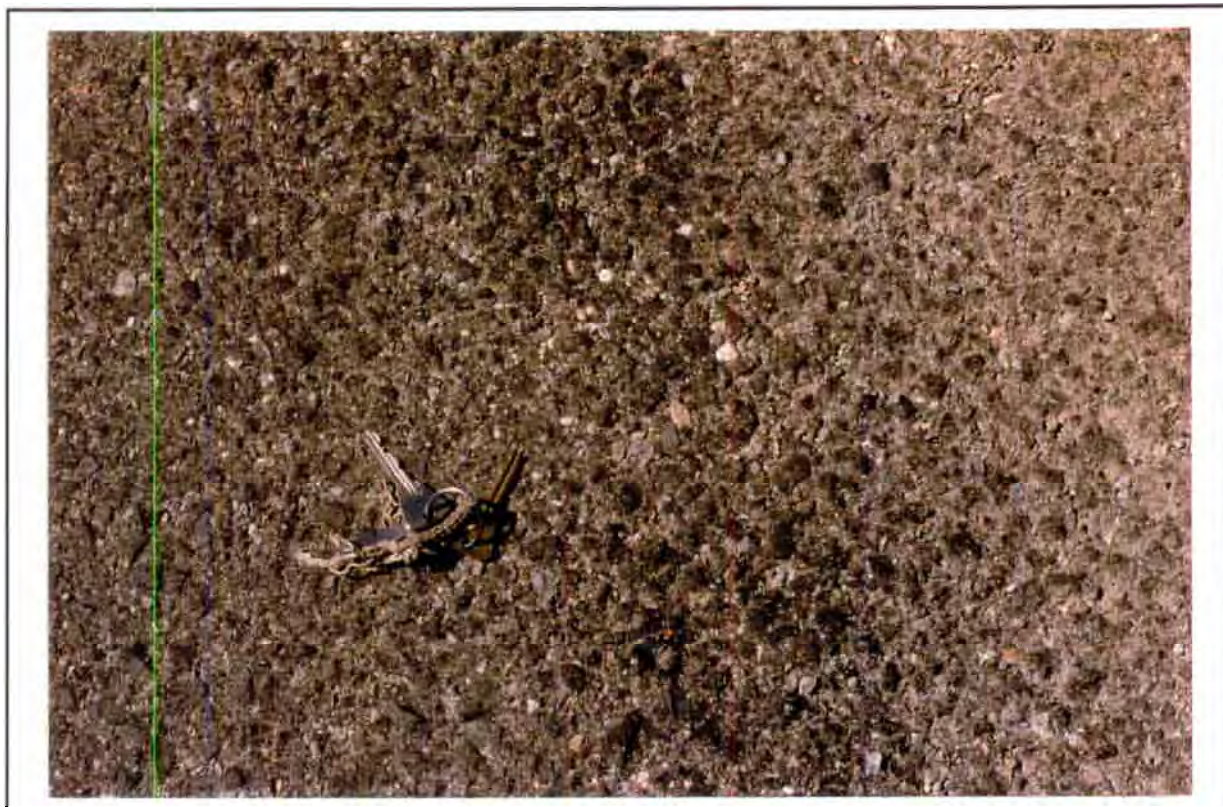
FIGUR 9 Ferdig komprimert dekke
