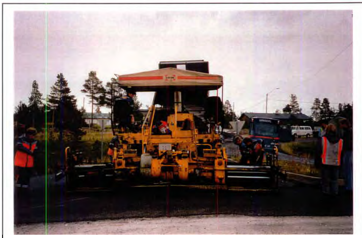
FIGUR 16 Krysset mellom Rv 26 og Rv 218 utlagt med Eska 12
