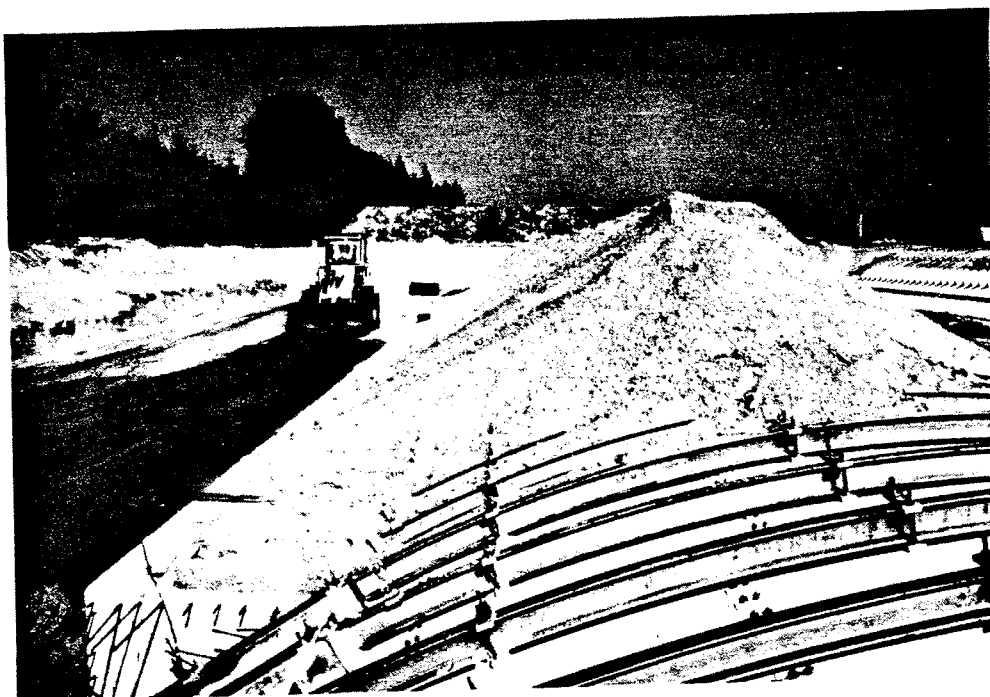
Foto 7. Masser lagt ut på rørtaket for å hindre for stor heving av toppen under tilbakefylling og komprimering inntil trykksbjelkene.
