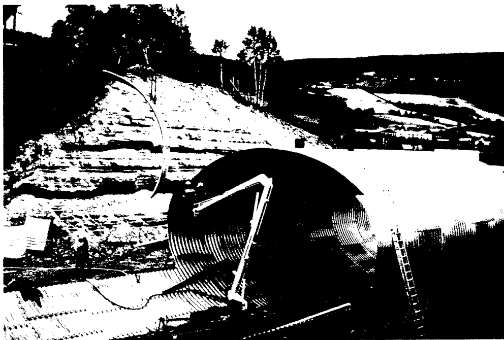
Foto 4. Formonterte plater heises på plass.
