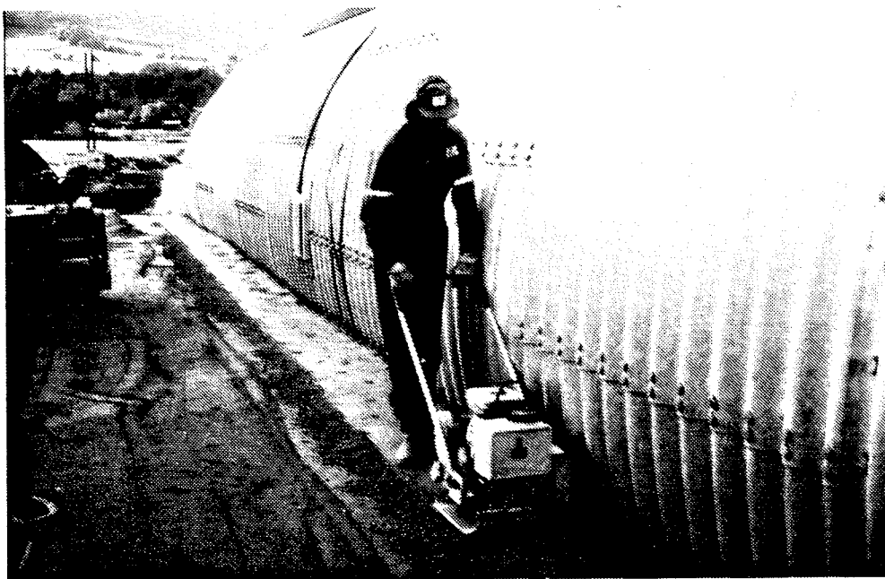
Foto 6. Komprimering langsetter røret.
