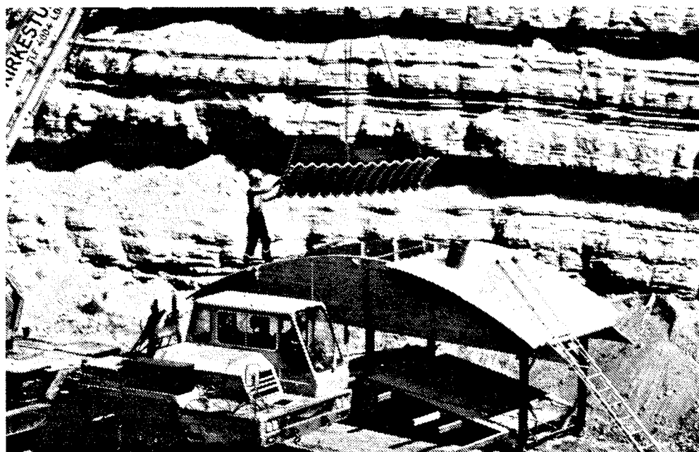
Foto 5. Mal til formontering av plater.
