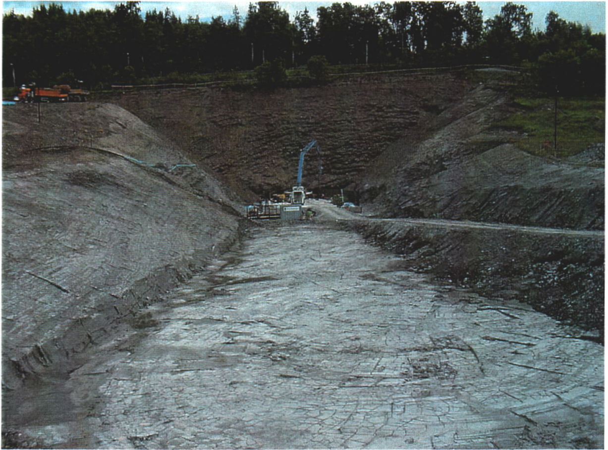
Utgraving for 1. byggetrinn
