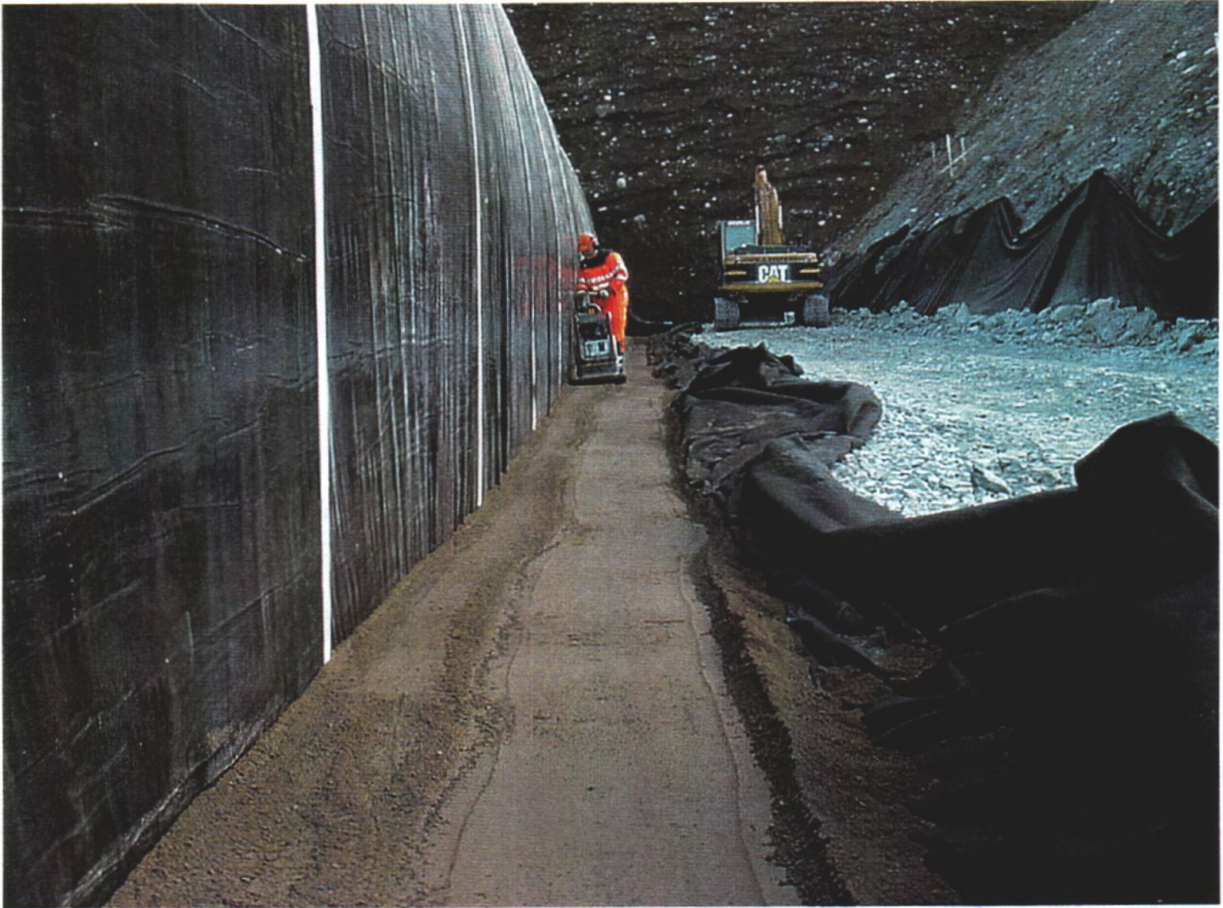
Utlekking/komprimering av sand
