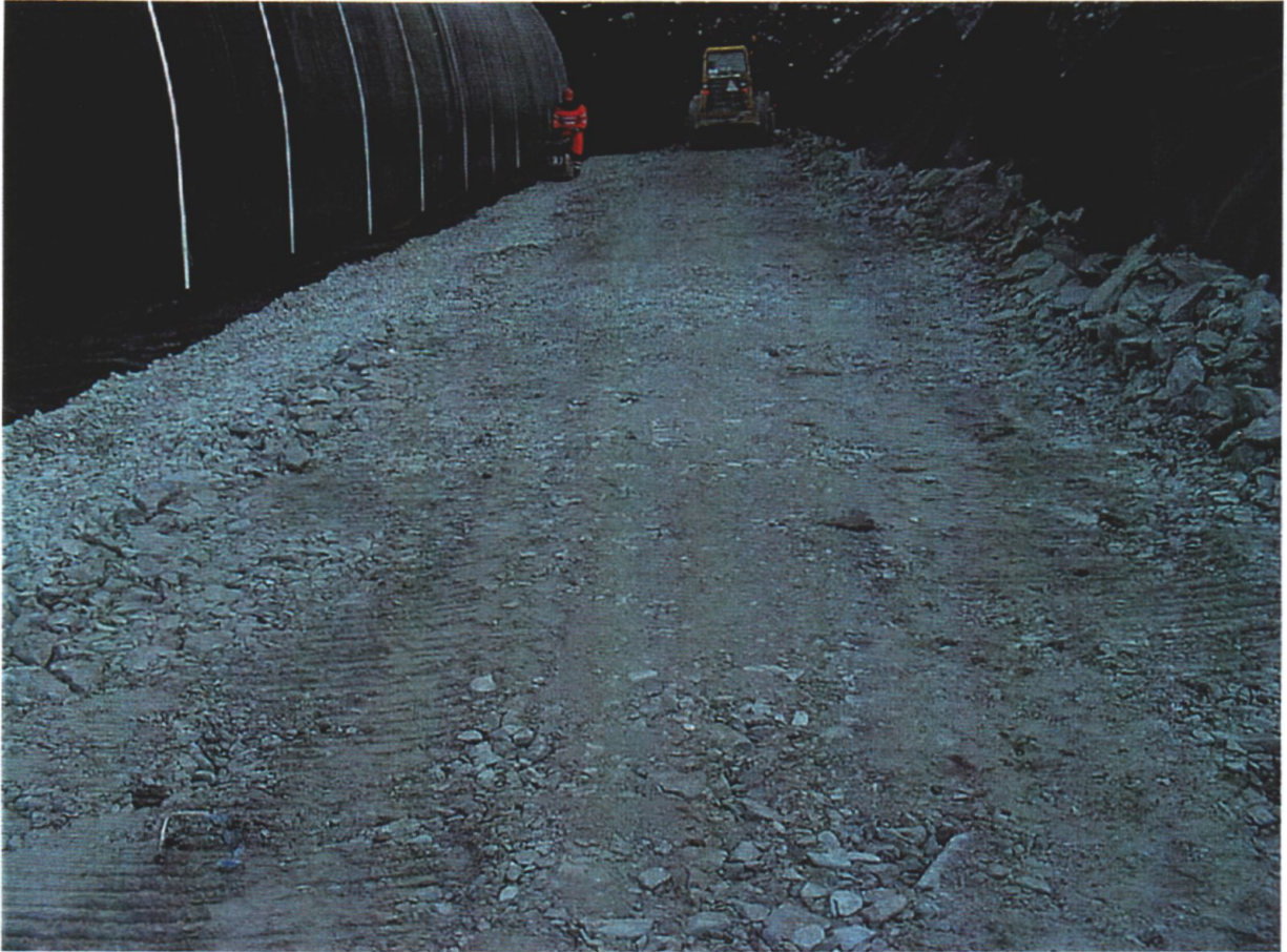
Komprimering av steinfylling
