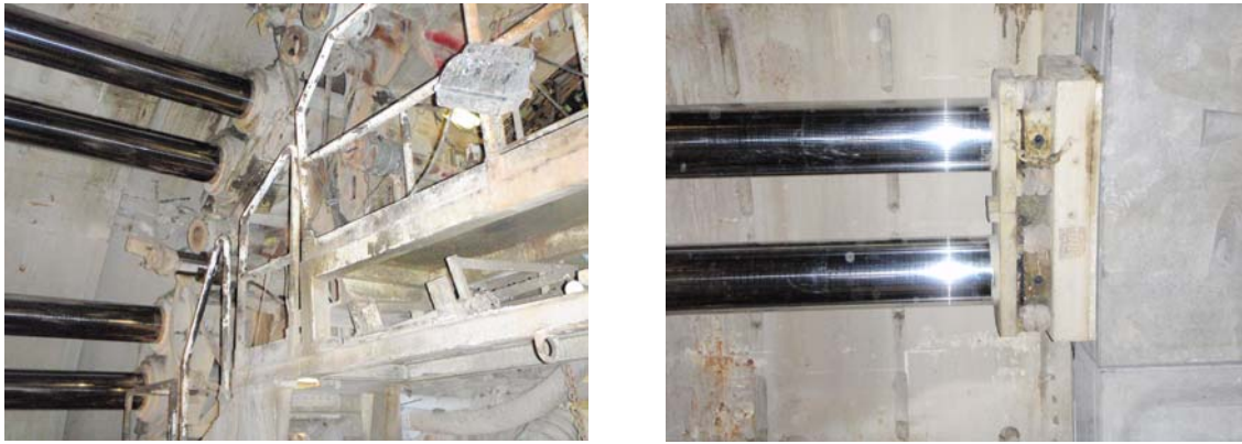
Figur 6: Foto som viser kraftoverføring fra TBM mot betongelementer
