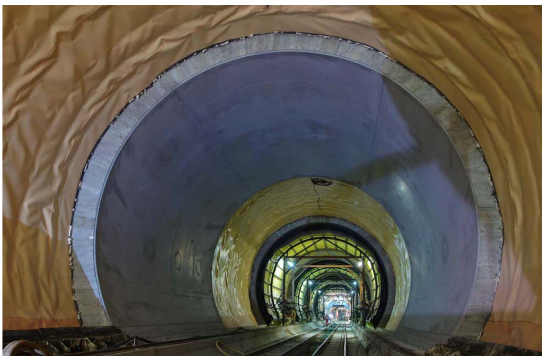
Figur 15: Foto av betonglinging som benyttes i Gotthard.
