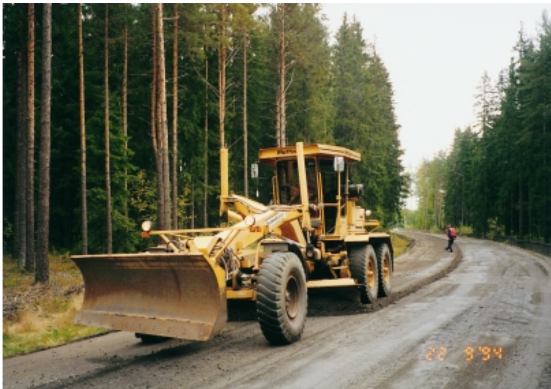
Figur 5: Rv 169 Stensrud – Midtskog: Profiljustering etter tørrfresing.
