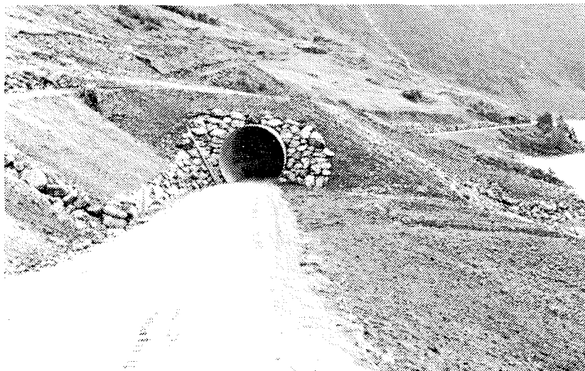
Fig. 10. 170 m langt stålrør som rasoverbygg ved Veitastrond
