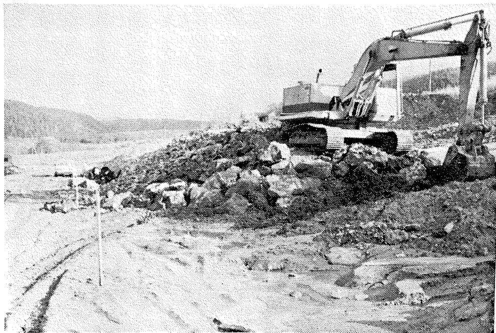
Bilde 31: Steinjeté foran gården fra pr. 4010 til 4060 blir lagt opp før ettersprengningen.
