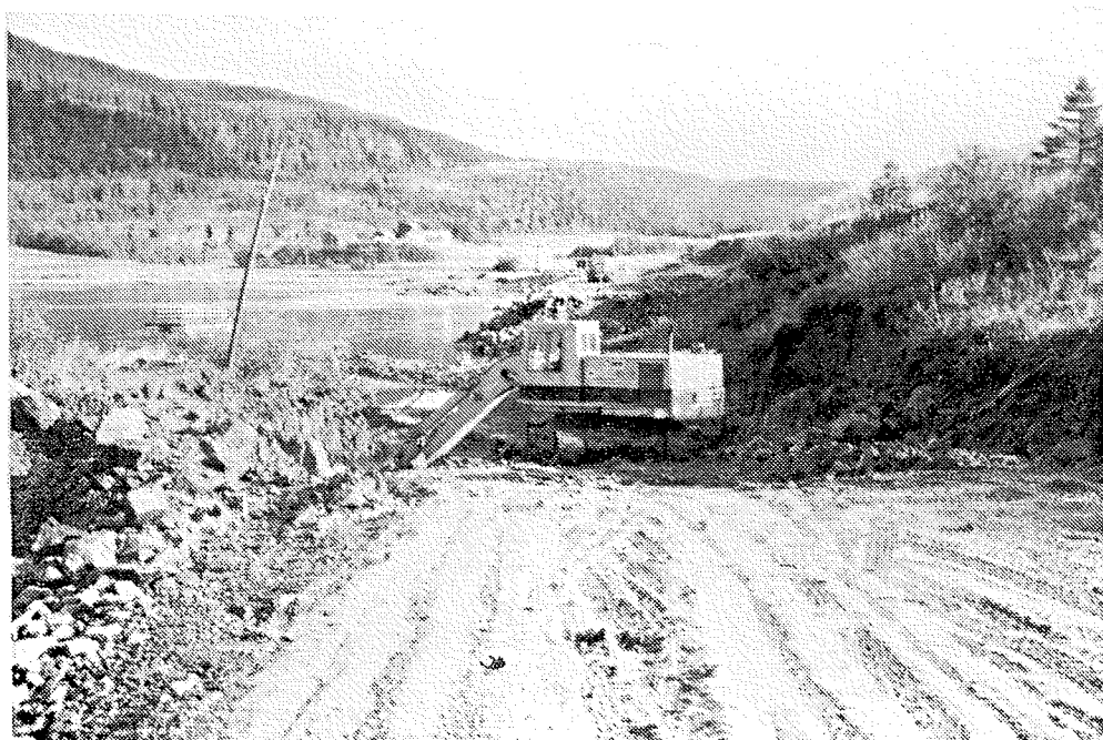
Bilde 25: Oppstarting av uttrauing ved bekken pr. 3770.
