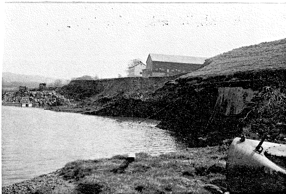
Bilde 16: Ny raskant ved ca. pr. 3865.
