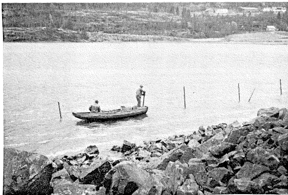
Bilde 32: Lading av salve for ettersprengning langs fyllingsfot.
