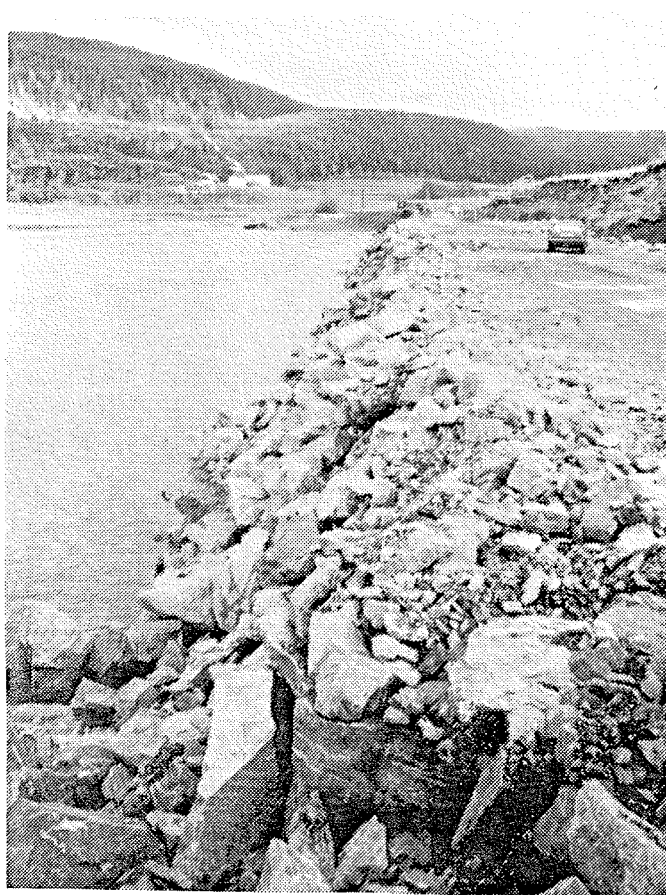
Bilde 30: Ettersprengning langs fyllingsgot fra pr. 3940 til 3785 gjenstår.
