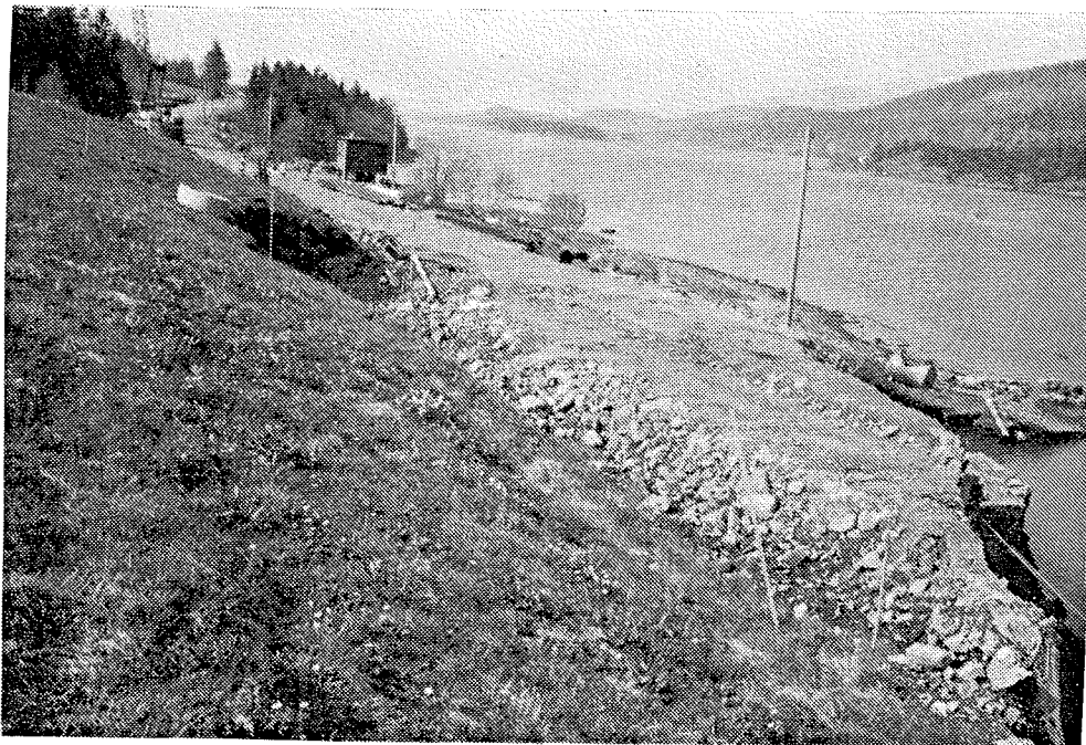
Bilde 15: Etter utrasing av spunt. Bildet viser også uttrauetgrøft mot skråningen.
