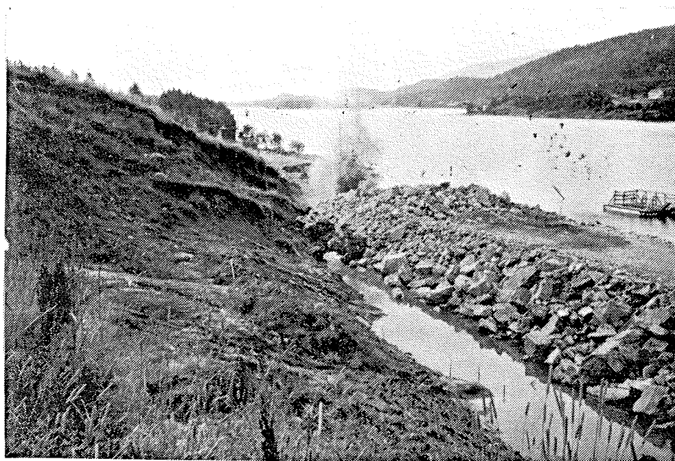
Bilde 22: Sprengning av salve nr. 32. Siste salve før utrasing fra pr. 3870 - 3810.
