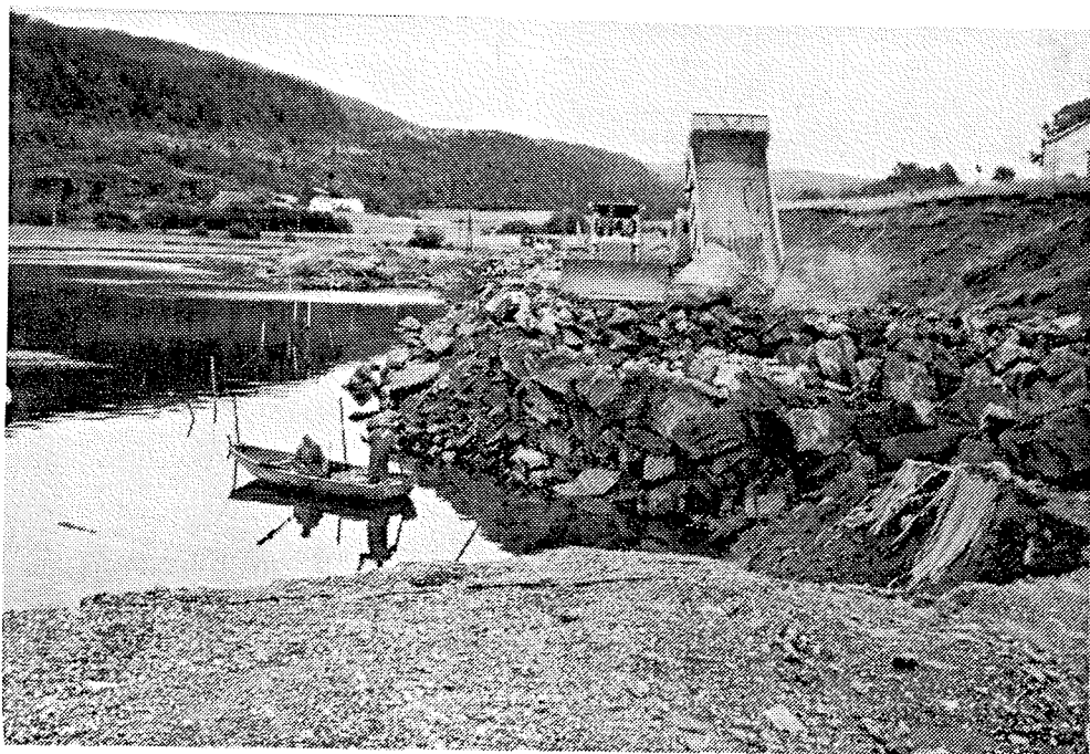
Bilde 21: Oppfylling og lading for salve nr. 32. Topp fyllingsfront ved pr. 3894. Lading pågår fra båt.
