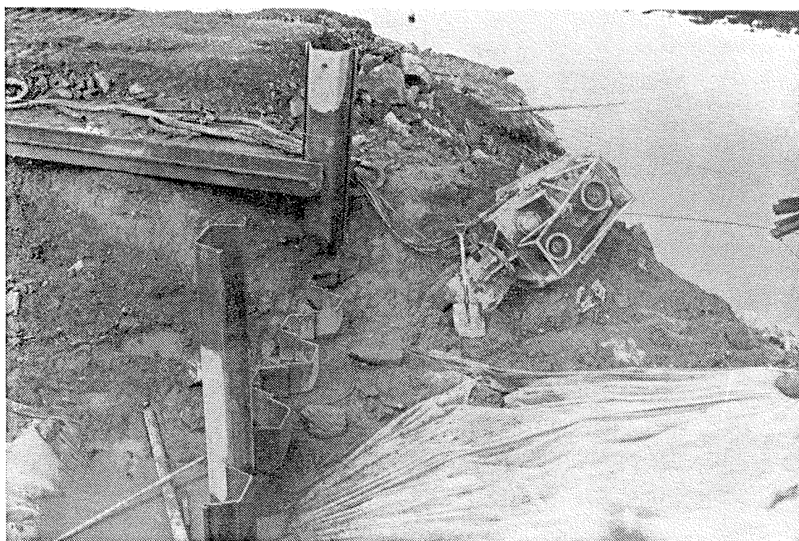
Bilde 14: Spuntvegg (tverrvegg) ved pr. 3900, og vibrolodd før utrasing.
