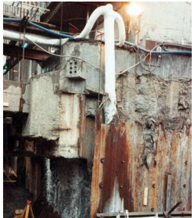
Foto 3. Samvirke mellom spunt, betong og frostkonstruksjon. (Foto: A-L. Berggren)
