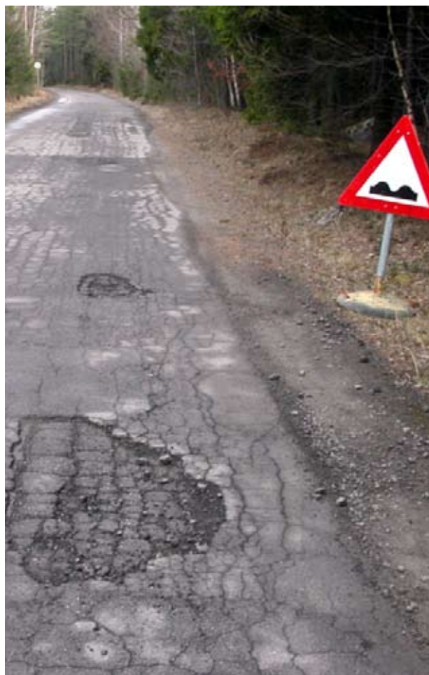
Figur 1. Bildet viser et typisk resultat av årvis økning i skader og ujevnheter (telehiv) om våren.
