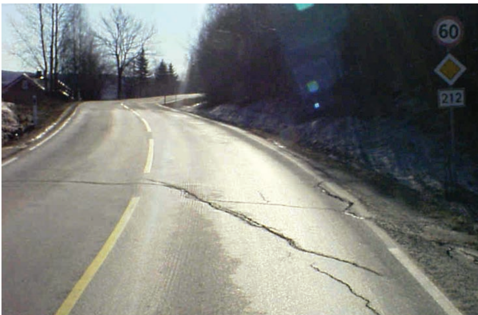
Figur 6. Foto fra riksveg 212 den 19.4.2006 km 2,852 (lokal strekning med store IRI-verdier, se figur 5).
