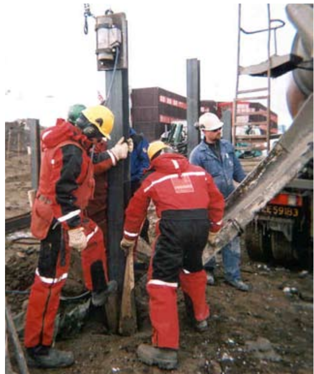
Figur 8. Innfylling av betongslurry. (Foto: Trygve Espelin)
