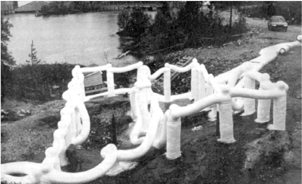
Foto 1. Fryserørsinstallasjon. (Foto: Rana Blad)
