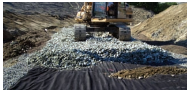
Figur 6. Legging av separasjonsduk og tildekking med knust stein
