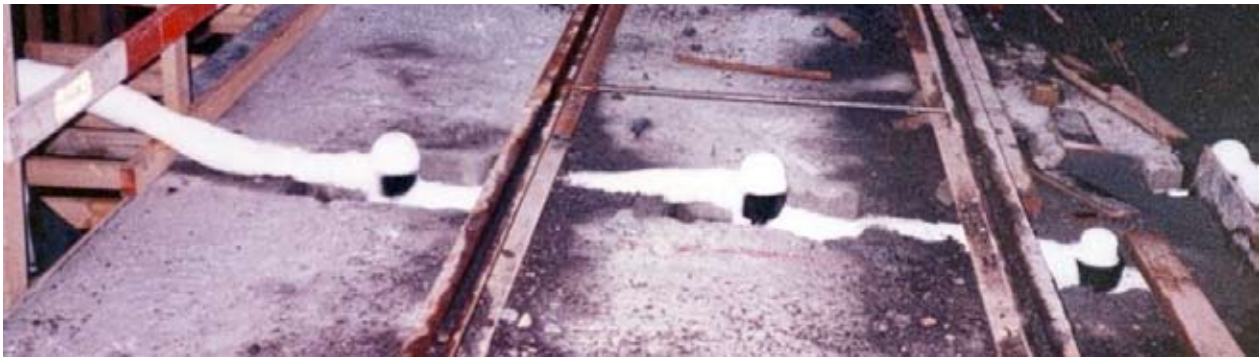
Foto 2. Frostkonstruksjon krysser trikkeskinner. (Foto: A-L. Berggren)
