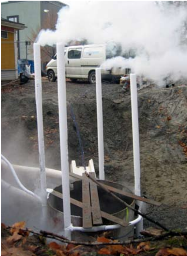
Foto 4. Nitrogenfrysing i 4 rør. (Foto: A-L. Berggren)
