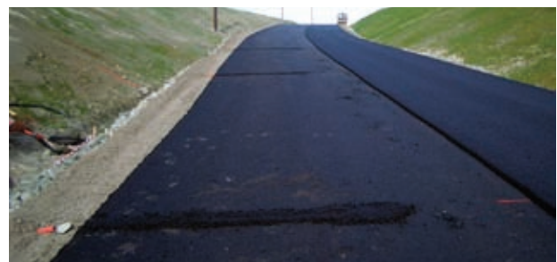
Figur 7. Temperaturfølere lagt mellom asfaltlagene
