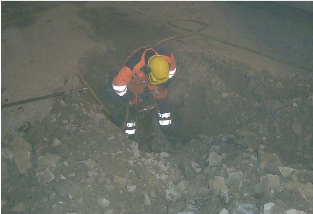
Figur 12: Boring i fast fjell med håndholdt bormaskin.
